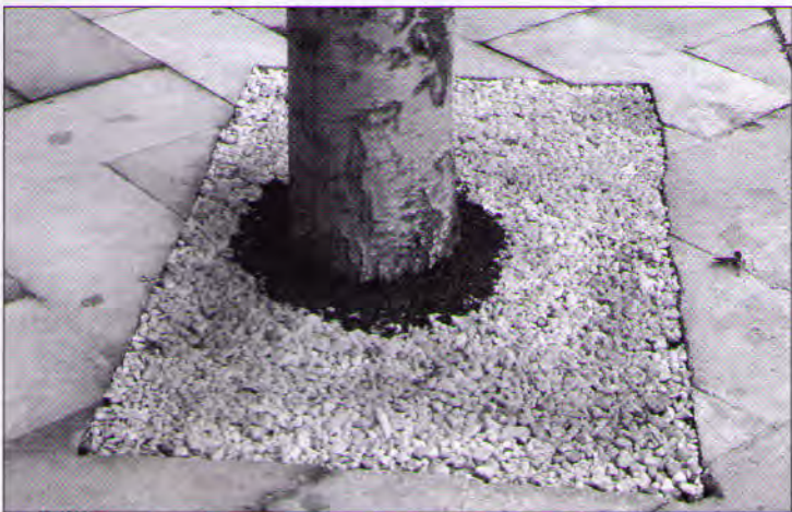
Aspecte de les noves alcorques en Avda. Comunitat Valenciana
