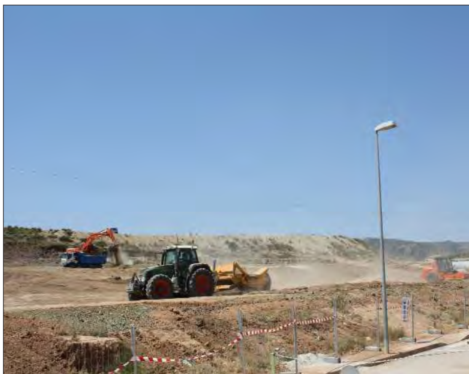
Las obras han comenzado con movimientos de desmonte.
