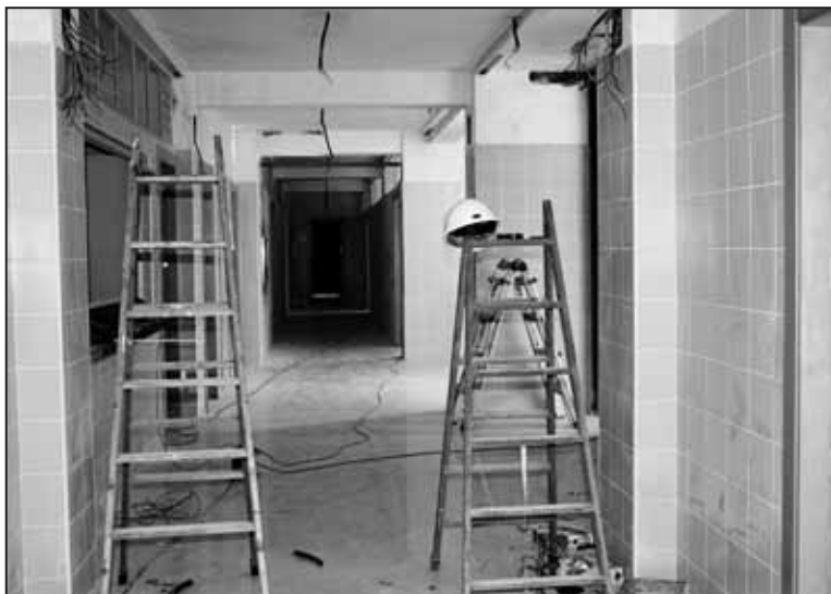
A lo largo del último mes se han acelerado las obras en el centro.
