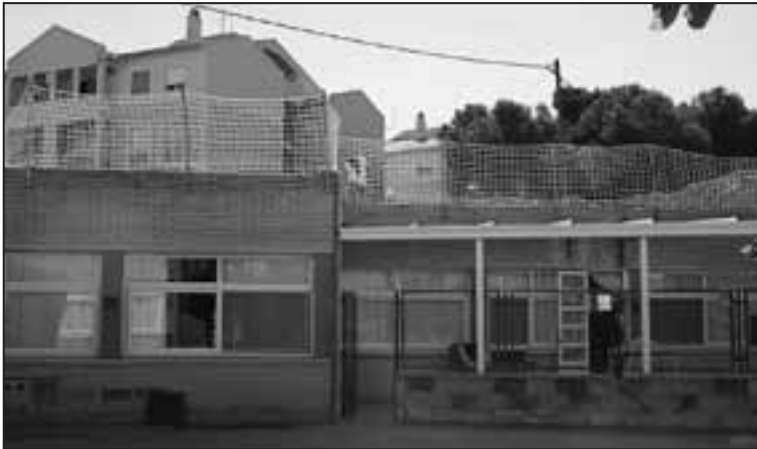
Els treballs s'han iniciat en la coberta de l'edifici.
