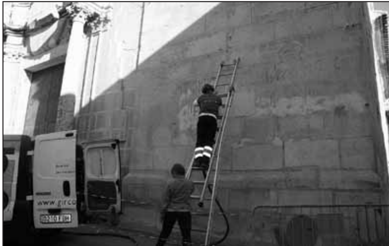
Los trabajos de limpieza se realizaron por una empresa especializada.
