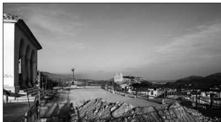
Estado actual de las obras. Foto: Arnau Sabater Díez.
