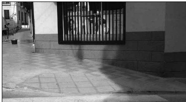
Uno de los puntos en los que se ha llevado a cabo esta actuación.
