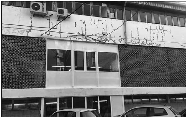
Ventanal instalado durante la reforma del mercado.
