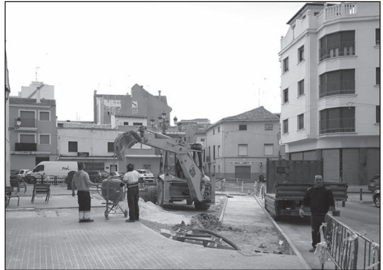
Hace unas semanas se iniciaron los trabajos de adecuación.
