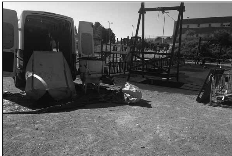
Trabajos de adecuación en el parque del Salitre.
