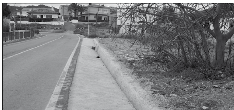
Obras realizadas en el acceso a Monóvar desde Novelda.
