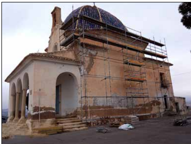
Obres de millora a la coberta de la cúpula de l'Ermita de Santa Bàrbara.
