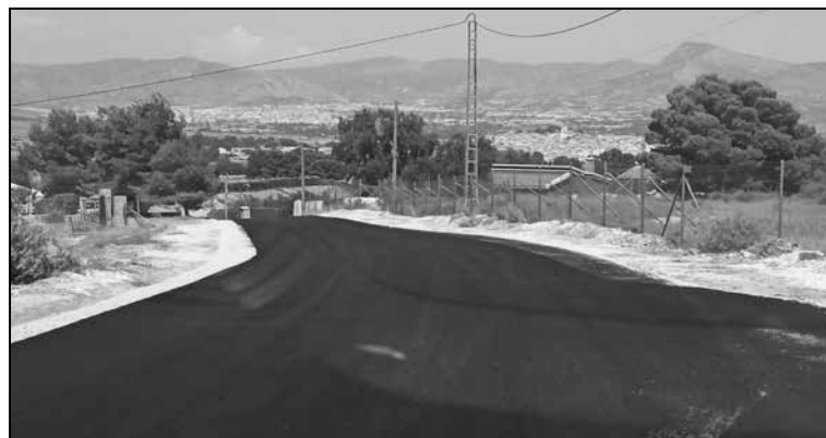
Estado del Camino de Matamoros una vez finalizadas las obras.
