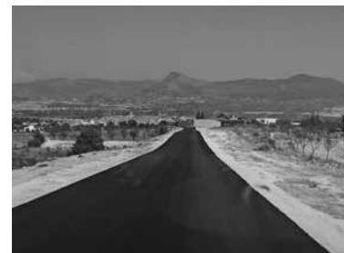
Otro tramo del camino ya reparado.
