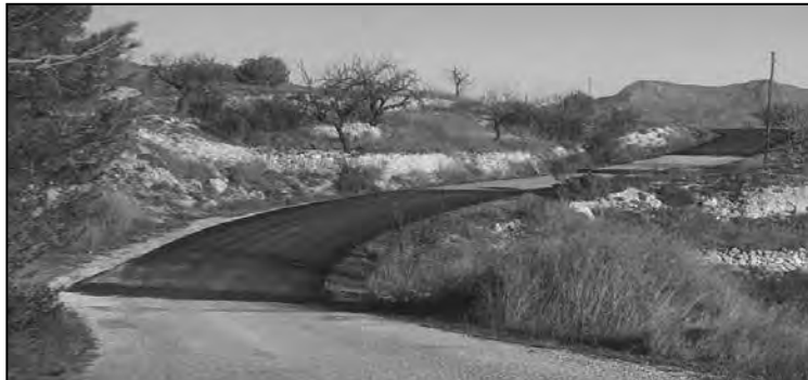
Obras finalizadas en el camino de L'Alquebla.
