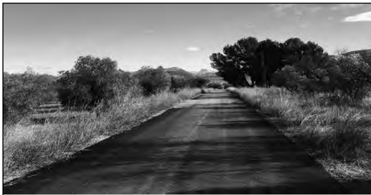
Adecuación del camino que une las Casas del Señor y La Romana.
