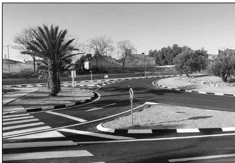
Les obres de la rotonda de la Venta de Blai, pràcticament acabades.
