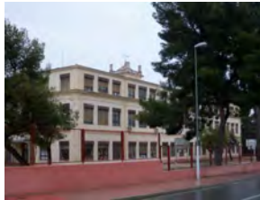
INSTALACIÓN 1: Colegio Cervantes
