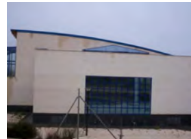
INSTALACIÓN 3: Piscina Municipal
