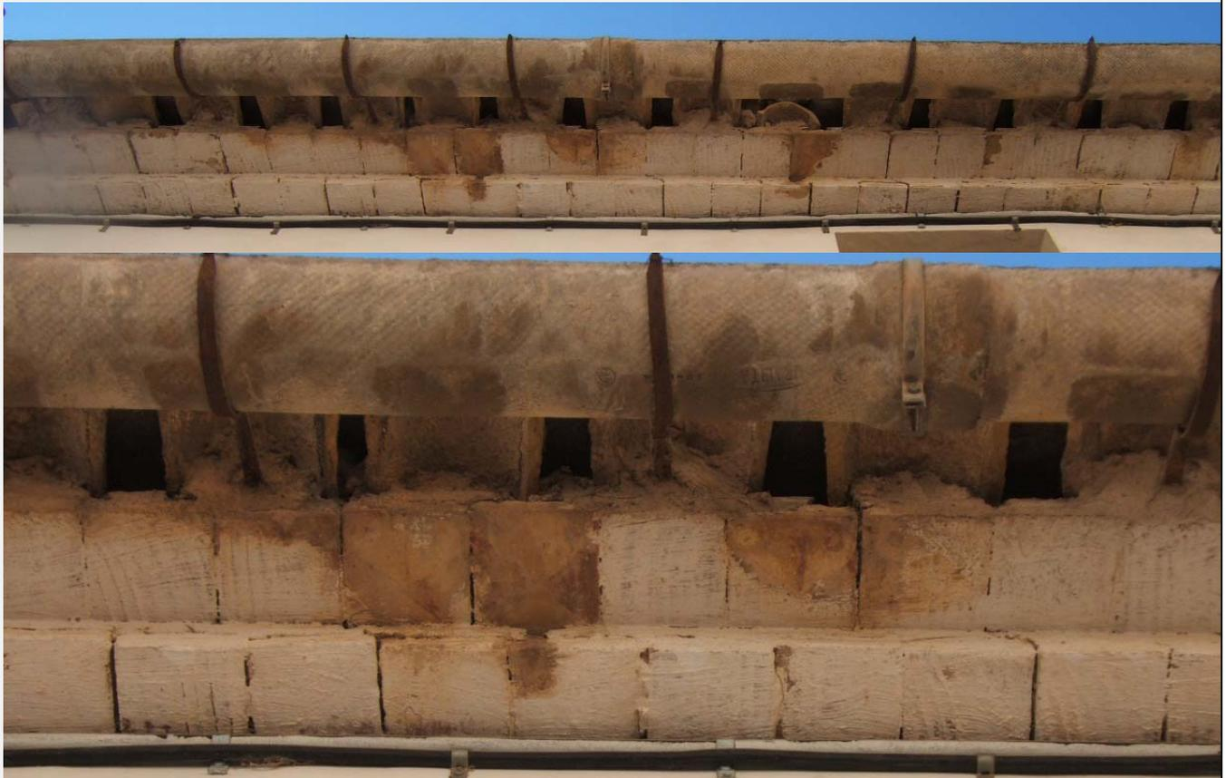
Detalle del alero enjalbegado, en el que se puede apreciar la existencia de decoración en los ladrillos del alero, allí donde la cal ha saltado
