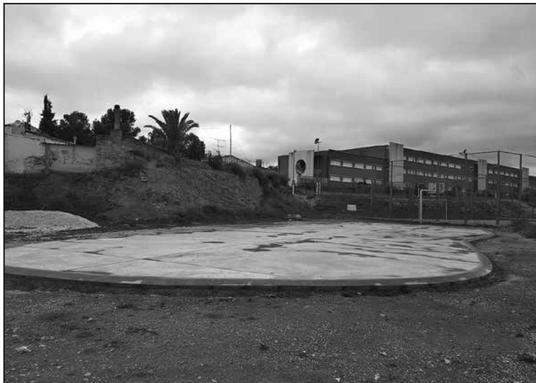
Estado actual de las obras en el parque del Salitre.
