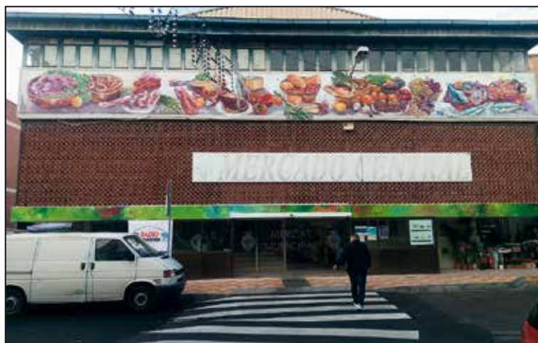
Nou aspecte de la façana del Mercat.
