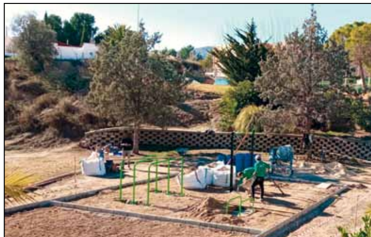
Trabajos de instalación de la zona de calistenia al Salitre.
