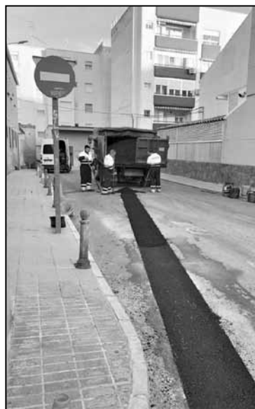
Actuación en el Barrio Cuartel.
