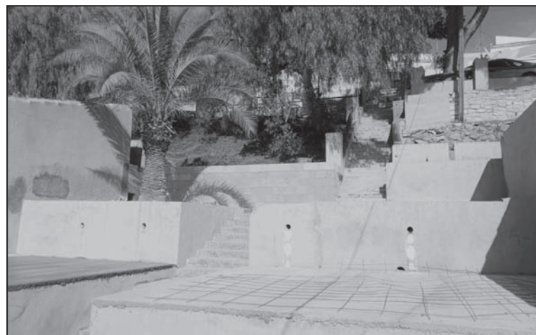
Imagen de las obras finalizadas en el barrio de la Goletja.
