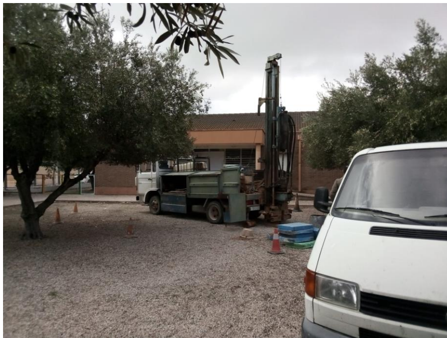
Fotografía 1: Vista del emplazamiento del sondeo SR-1
