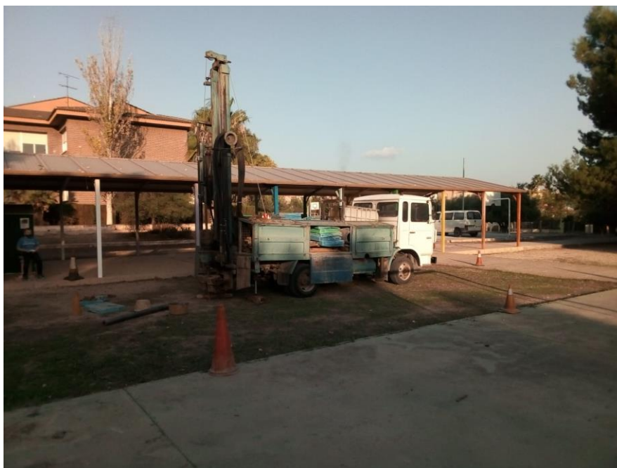
Fotografía 2: Vista del emplazamiento del sondeo SR-2
