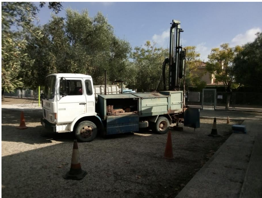
Fotografía 3: Vista del emplazamiento de la DPSH-1
