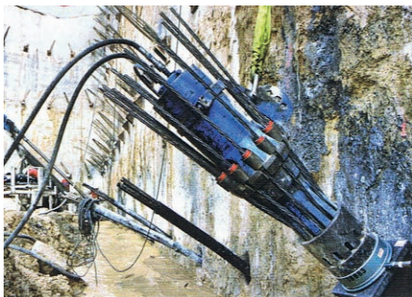
Gato de tesado multifilar.
