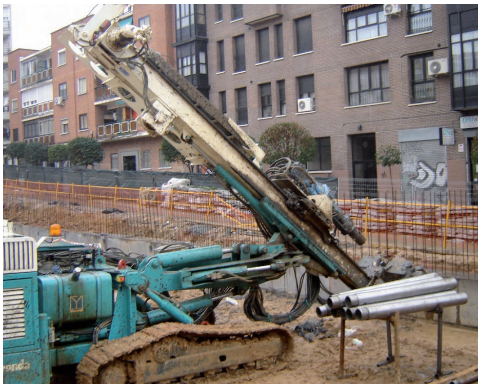
Equipo de perforación y utillaje en borriquetas.
