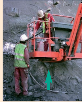
Para la comprobación de la inyección de lechada en altura utiliza la plataforma.
