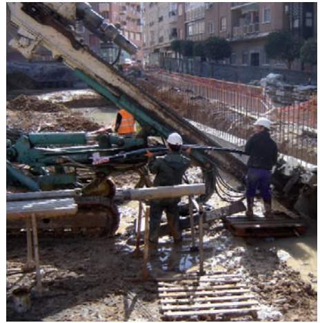
Perforación de anclajes.
