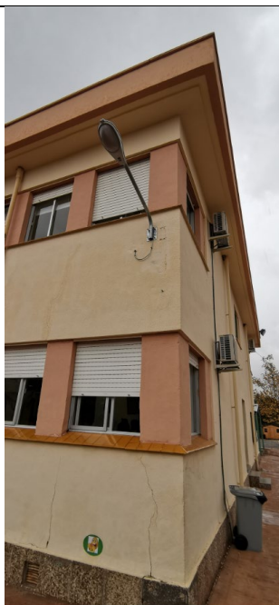
Figura 8. Vista grietas esquina fachada este.
