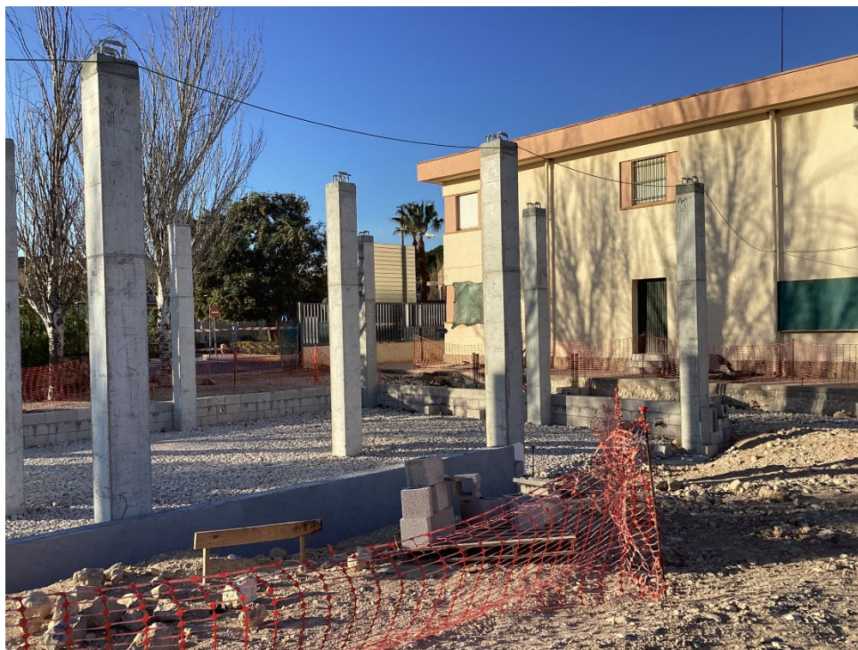
Cimentación y pilares comedor-cocina vestuarios ejecutado
