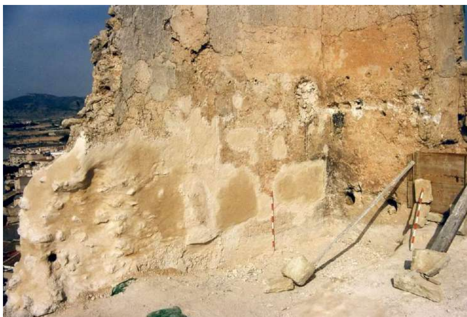
Fig. 71: Trabajos de consolidación en el interior de la torre del castillo.
