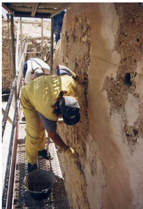
Fig. 80: Recuperación de enfoscados y sellado de huecos en la fachada noreste de la torre.
