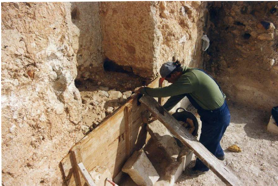
Fig. 72: Se encofró con tablas un área deteriorada del tapial del interior de la torre.
