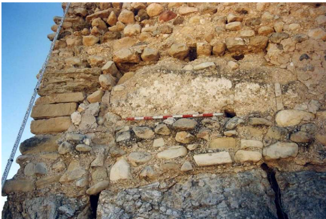
Fig.67: Detalle restos encofrado de tapial de la fachada noroeste de la torre del castillo. Se observa la esquina noreste con sillería encadenada, posiblemente de la etapa bajomedieval.
