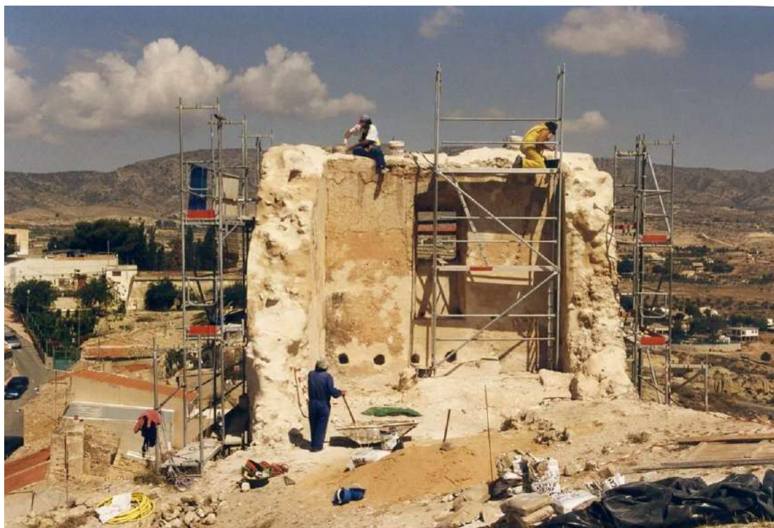
Fig. 78: Detalle de los trabajos para consolidar la coronación de los muros de la torre.
