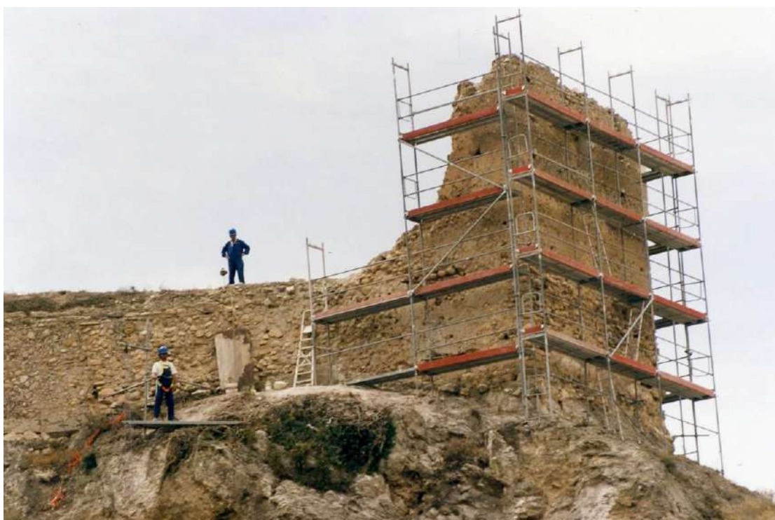
Fig. 74: Se instaló un andamiaje modular con seguridad, perfecto para actuar sobre la torre.
