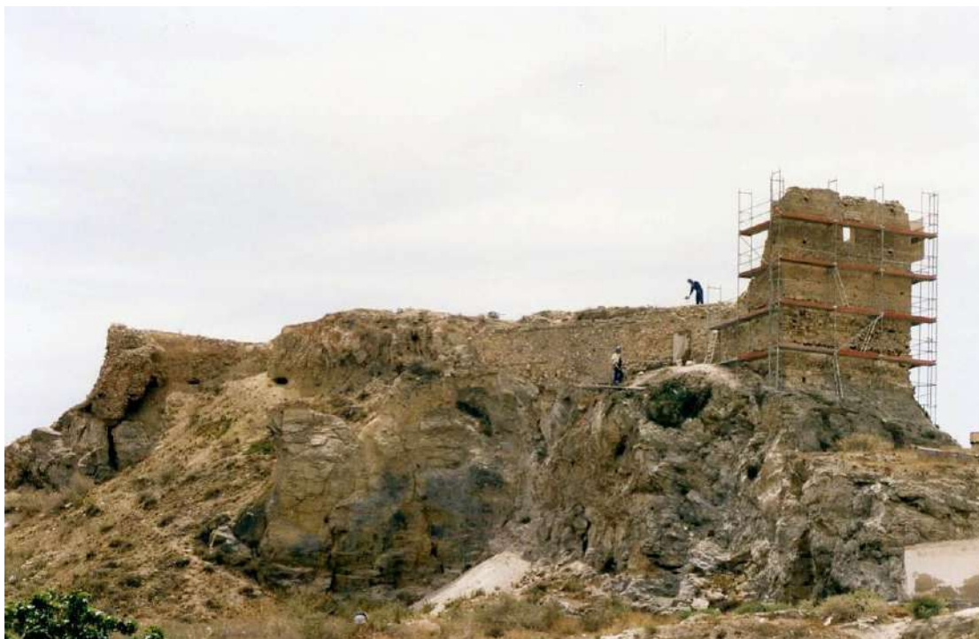
Fig. 73: El andamiaje nos permitió actuar con celeridad en los trabajos de consolidación.
