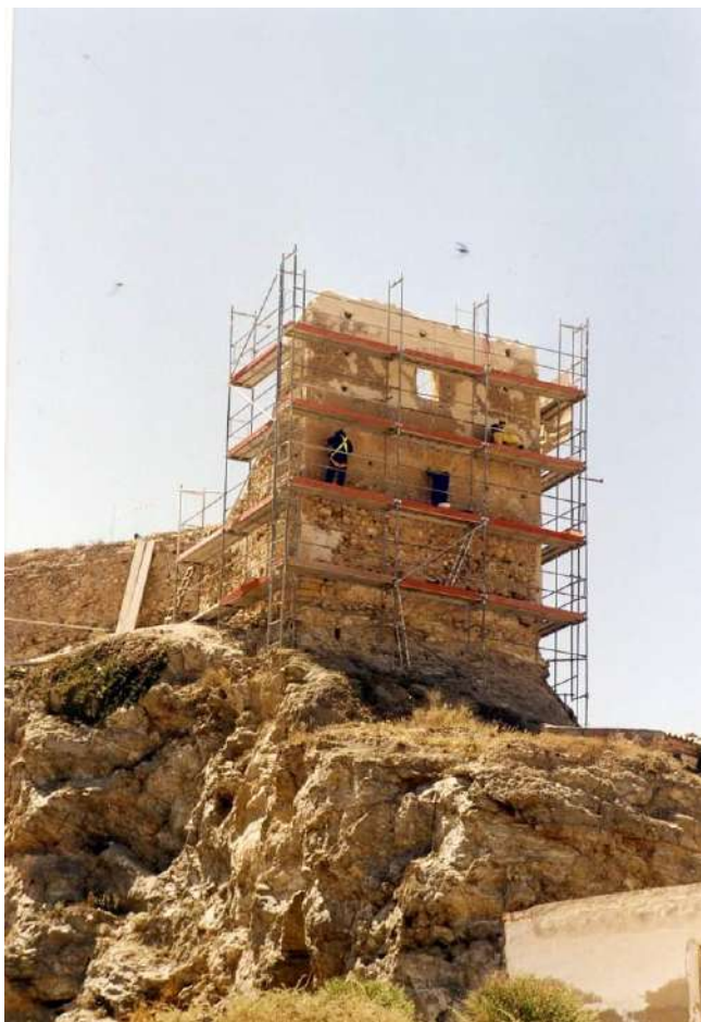
Fig. 79: Trabajos para consolidar la fachada norte de la torre.
