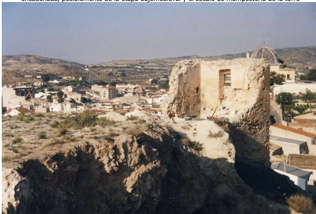
Fig.68: Vista de la fachada noroeste y suroeste de la torre del castillo. Se observa la esquina con sillería encadenada, posiblemente de la etapa bajomedieval y el zócalo de mampostería de la torre
