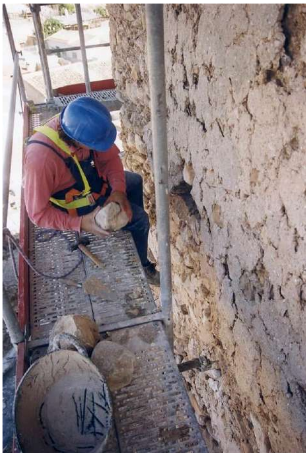
Fig. 82: Trabajos de consolidación de la torre, introducción de bolos en los huecos de la torre para su sellamiento y saneamiento.
