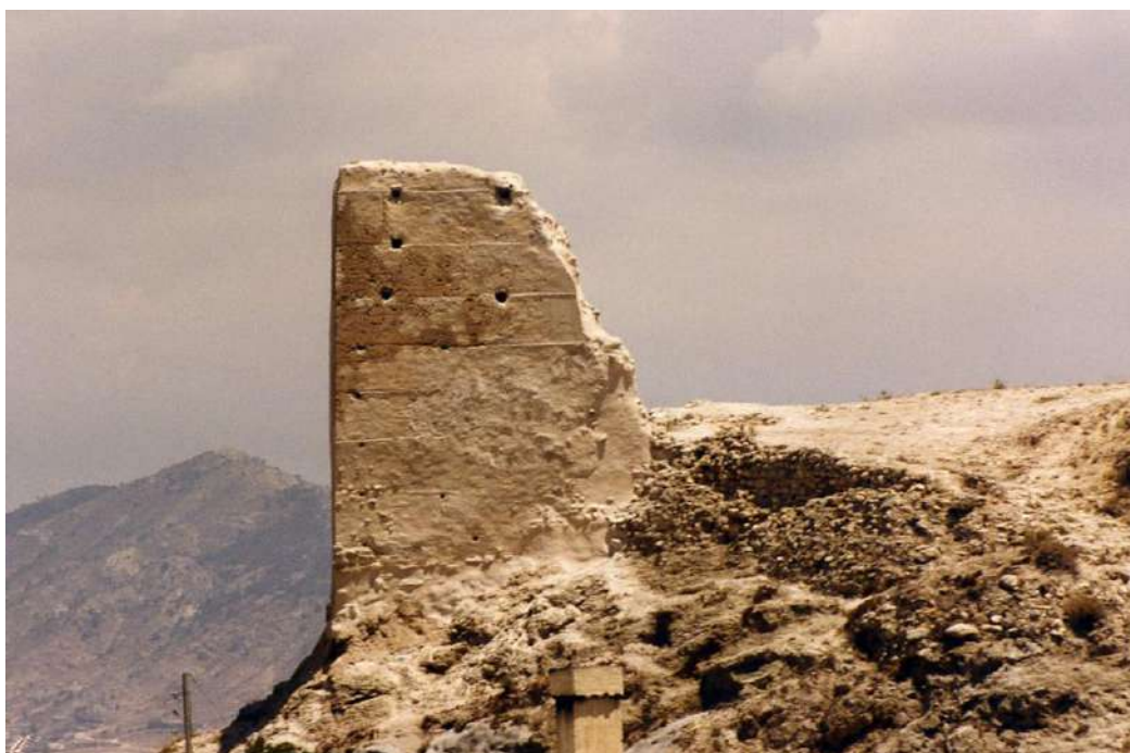
Fig. 96: Vista del castillo desde su ala suroeste, con el aspecto final de la torre tras su consolidación. Se observa el marcado de las líneas de los cajones del tapial de la torre, elemento que se quiso poner en valor para resaltar su fábrica de tapial original.
