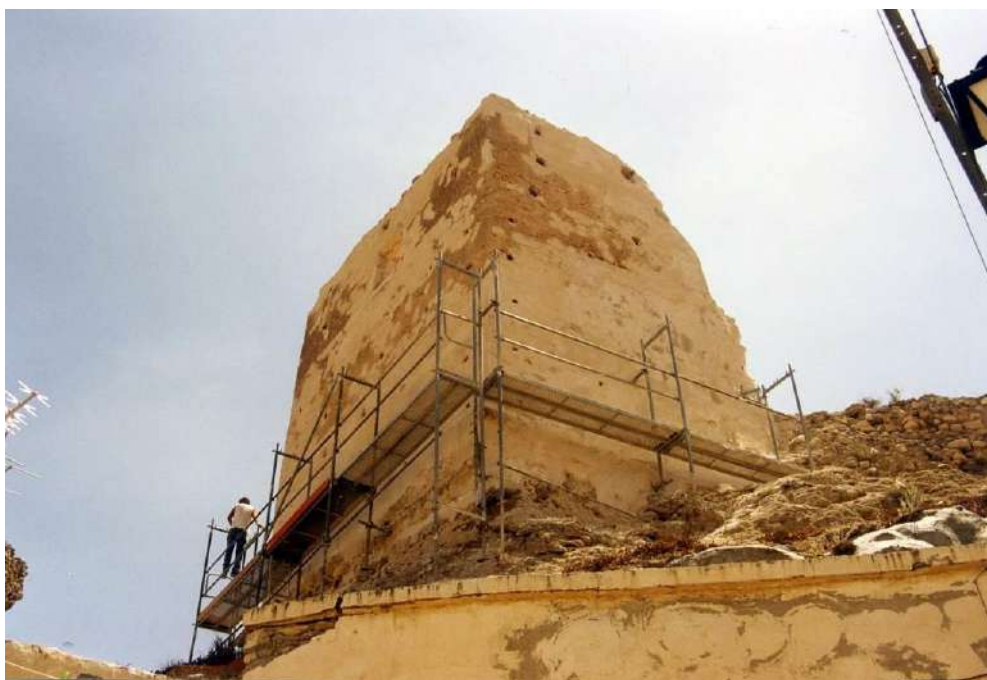
Fig. 84: Otra imagen del proceso de desmontaje de los andamios una vez ya se había actuado sobre la torre.
