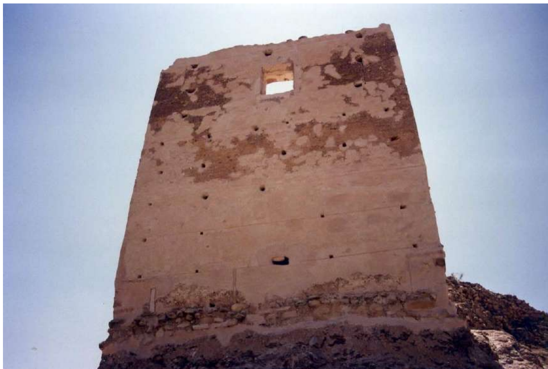
Fig. 89: Aspecto del exterior norte de la torre tras su consolidación. Se marcó adecuadamente las líneas de encofrado de los distintos pisos del tapial.
