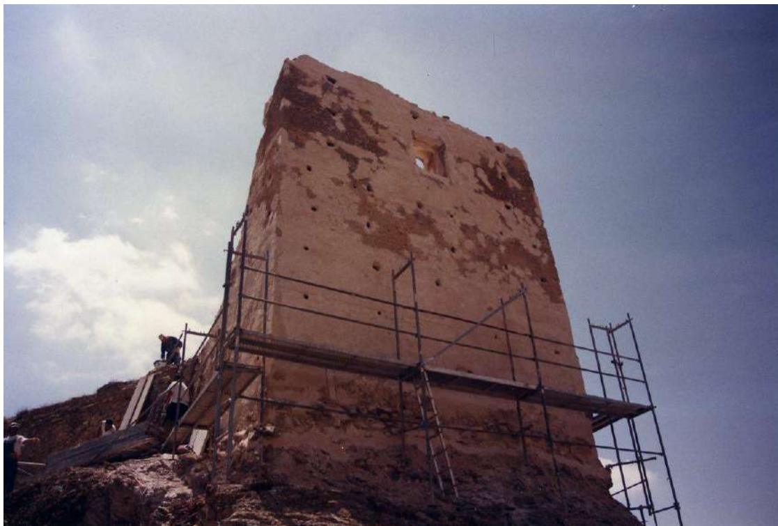
Fig. 83: Proceso de desmontaje de los andamios una vez ya se había actuado sobre la torre.
