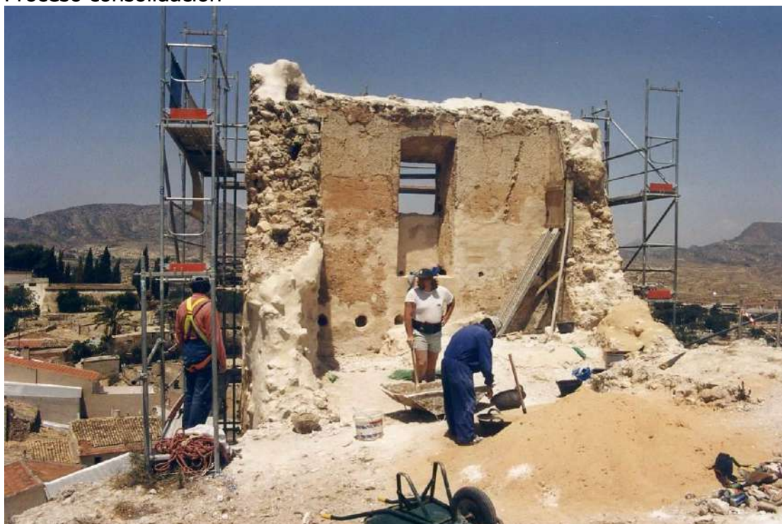
Fig. 77: Proceso de intervención de consolidación en la torre del castillo.
