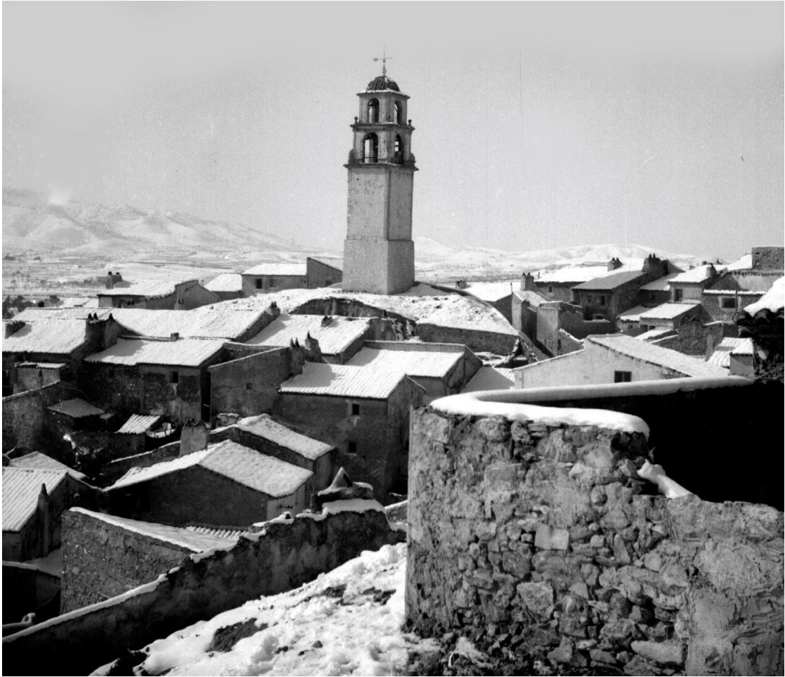
Imagen 14- Fotografía 1955-1960, se aprecia el sillarejo regular de las fachadas norte y este, aun no se ha colocado la capa de ladrillos (fuente: Archivo Municipal de Monóvar)
