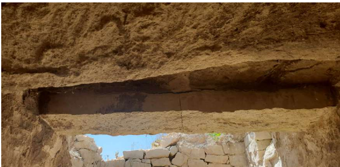
Fig. 16: Vista de la techumbre con vigas de piedra y losas, que ha cedido en parte. Se observa la fisura en la segunda viga, que provocará muy pronto su caída
