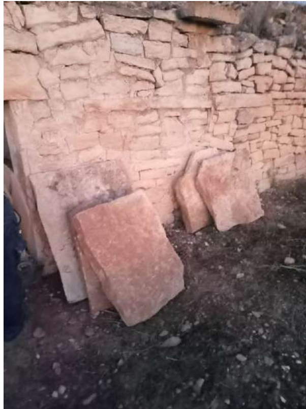
Fig. 37: Losas de piedra de la cubierta caídas, preparadas en el exterior del refugio para reponerse en el proceso de reconstrucción de la cubierta
