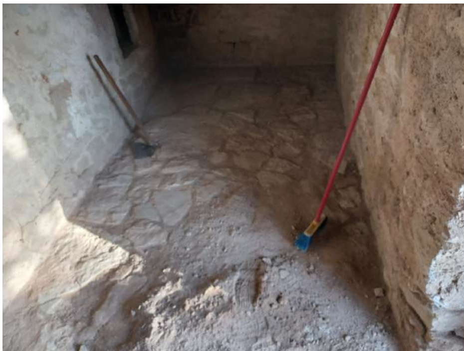
Fig. 68: Proceso de limpieza del pavimento en losetas original de refugio
