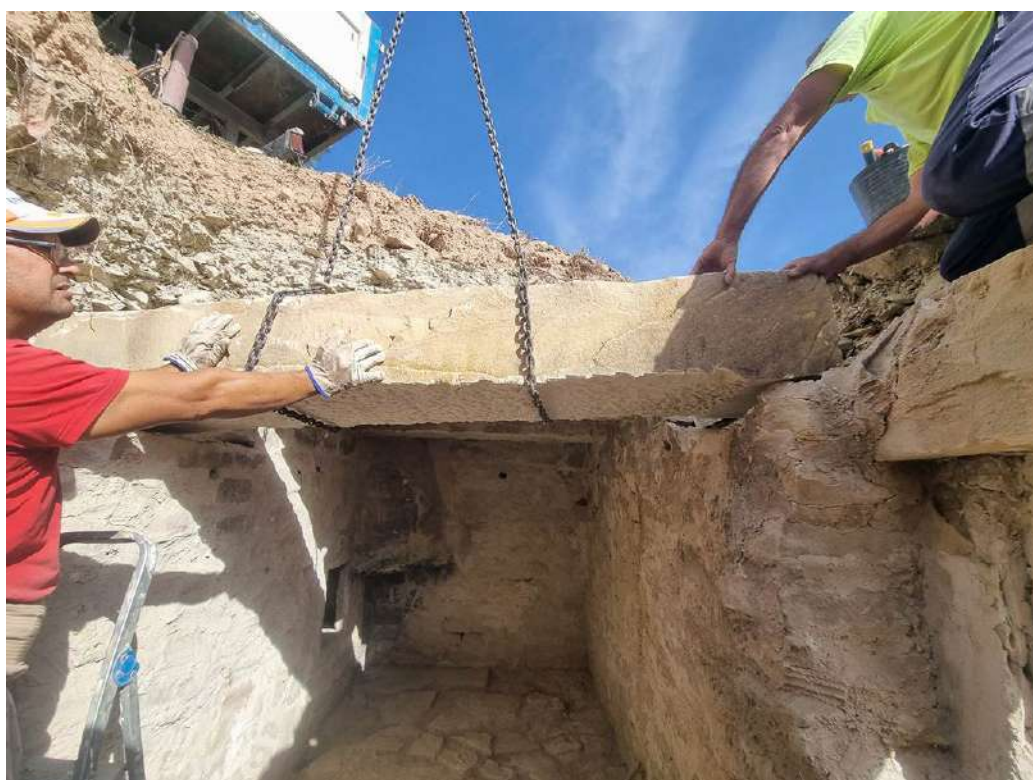
Fig. 50: Colocación primera viga del refugio a reponer
