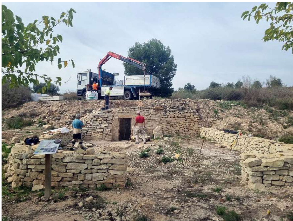
Fig. 54: Inicio colocación de las primeras losas sobre las vigas colocadas
