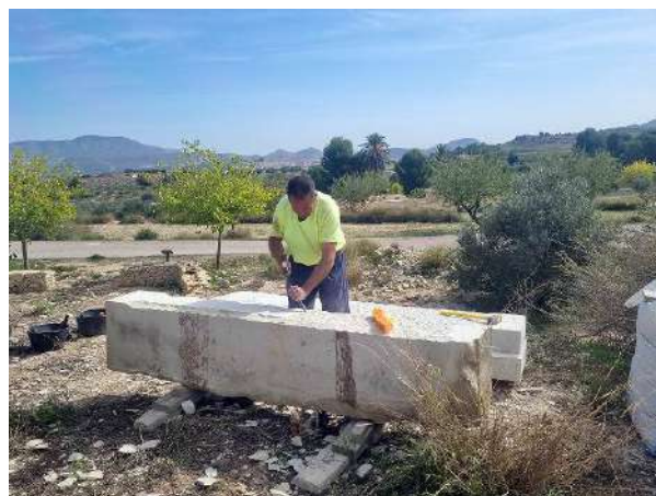
Fig. 48: Otra vista del proceso de repicado sobre las caras lisas de las vigas a colocar
