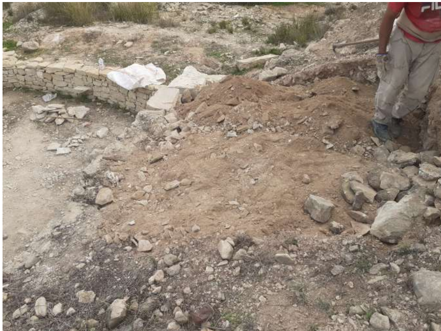
Fig. 64: Proceso de colocación de ripio y tierra sobre las losas de la cubierta
