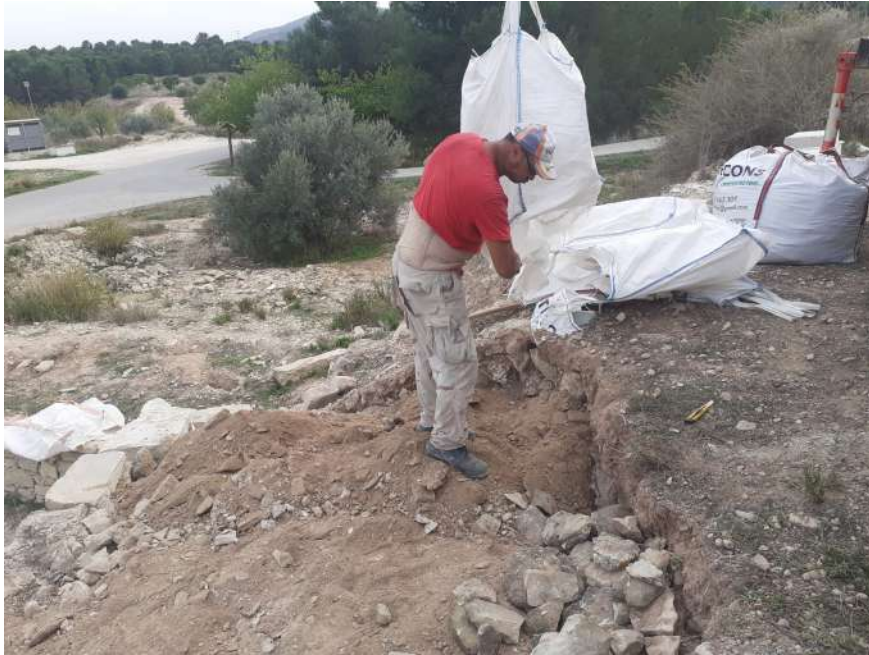
Fig. 64: Proceso de colocación de ripio y tierra sobre las losas de la cubierta
