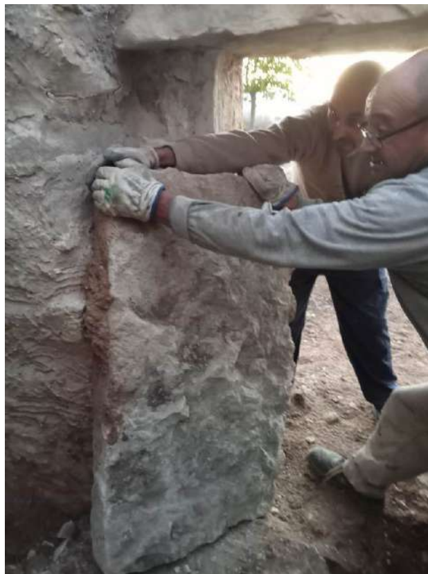
Fig. 36: Extracción de las losas de la cubierta colapsadas al exterior del refugio
