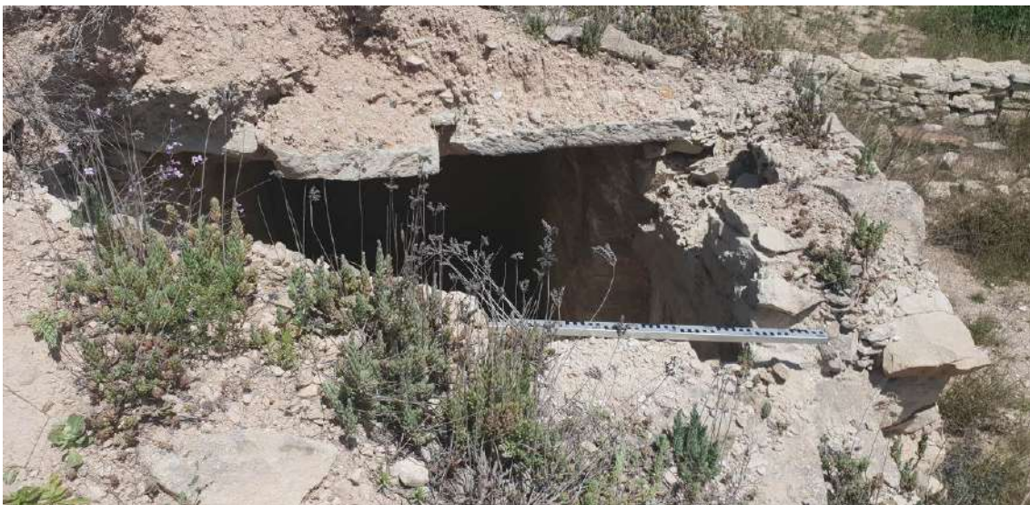
Fig. 9: Vista del hueco en la techumbre del refugio tras el colapso de una de sus vigas de piedra
