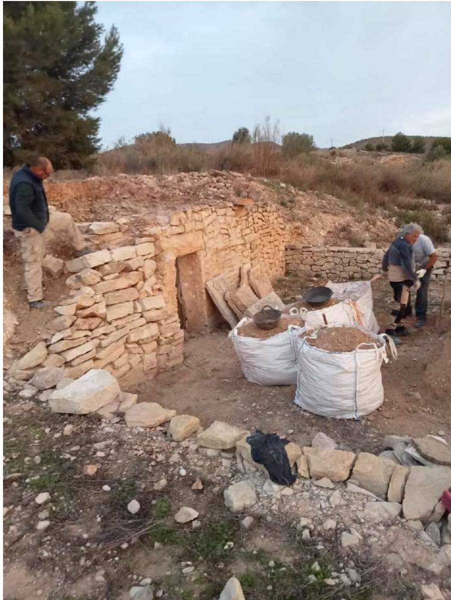
Fig. 46: Recuperación muro fachada meridional del refugio y acopio escombros de la demolición de la cubierta introducidas en sacas para su reaprovechamiento
