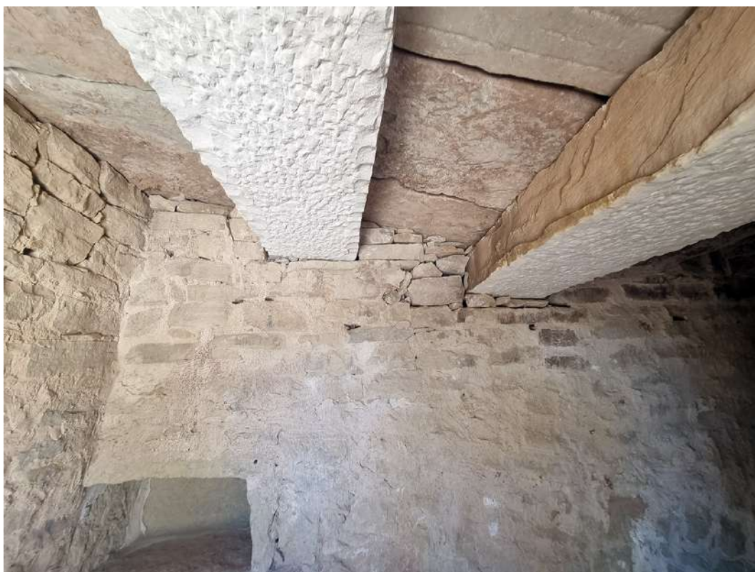
Fig. 93: Aspecto final tras recuperación de techo del refugio con las vigas y losetas colocadas
