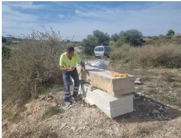
Fig. 47: Repicado de las caras lisas de las vigas de Almorqui, que se iban a utilizar en la nueva cubierta del refugio
