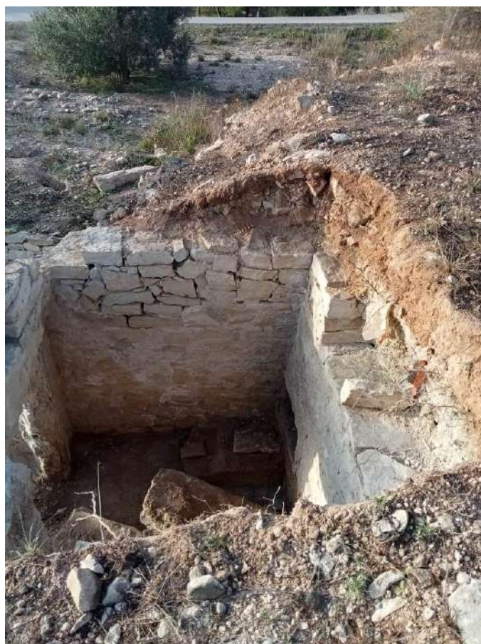
Fig. 39: Otra vista de la cubierta cedida, una vez saneada para su reconstrucción
