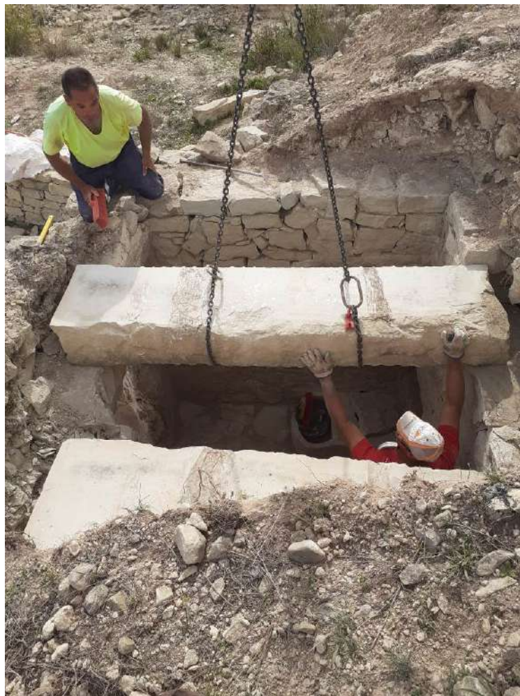
Fig. 52: Colocación de la segunda viga sobre el refugio
