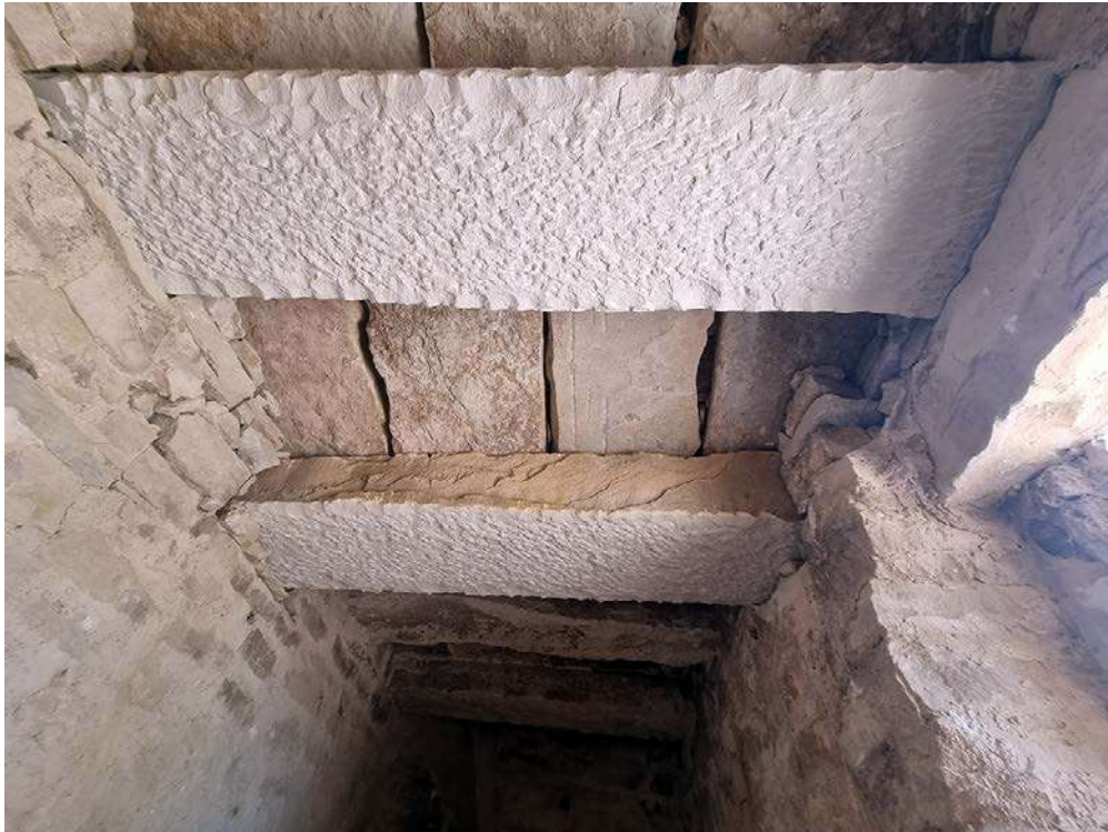
Fig. 90: Aspecto techo refugio, con las dos vigas nuevas y losetas sobre las mismas
