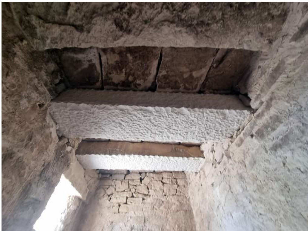
Fig. 91: Otra vista del techo refugio, con las dos vigas nuevas y losetas sobre las mismas
