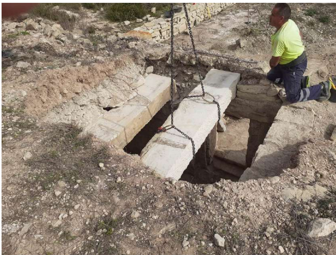
Fig. 53: Encaje segunda viga sobre el dintel del refugio
