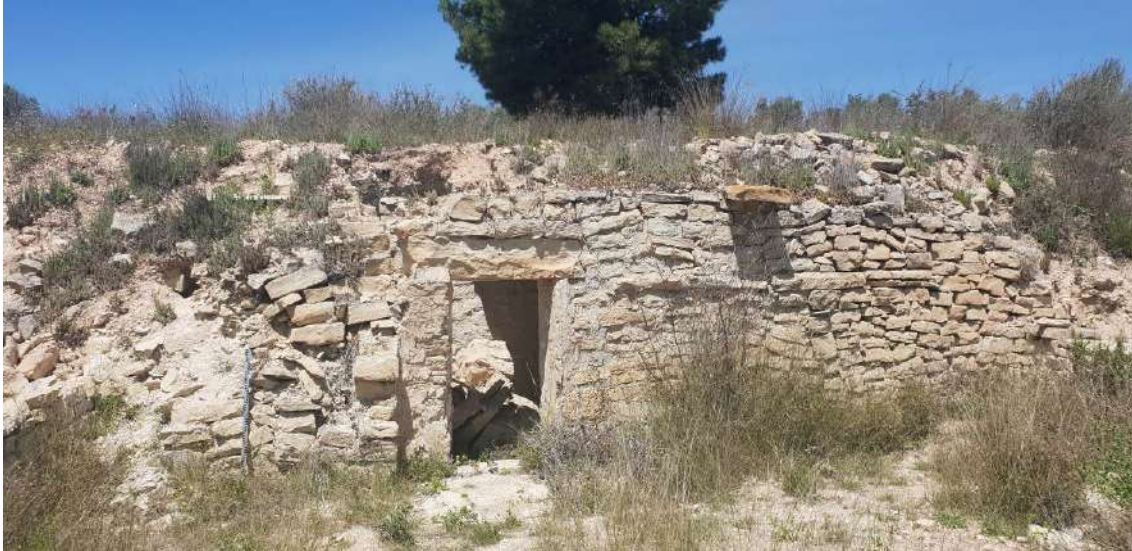
Fig. 12: Vista del refugio desde su frente oriental. Se ve tanto la zona desmantelada de su fachada y el techo cedido en el acceso al edificio
