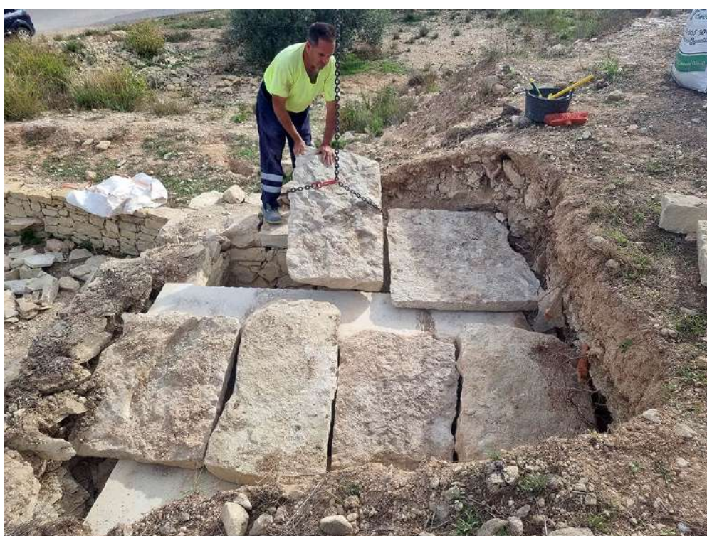
Fig. 58: Vista del proceso de colocación de todas las losas sobre las vigas repuestas
