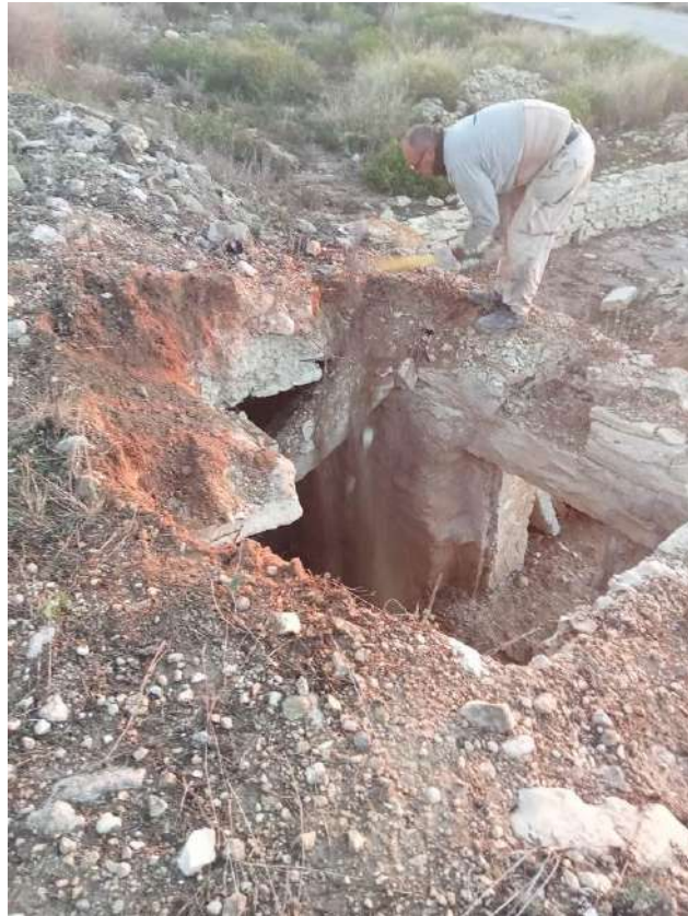
Fig. 33: Proceso de limpieza y saneado de la cubierta cedida
