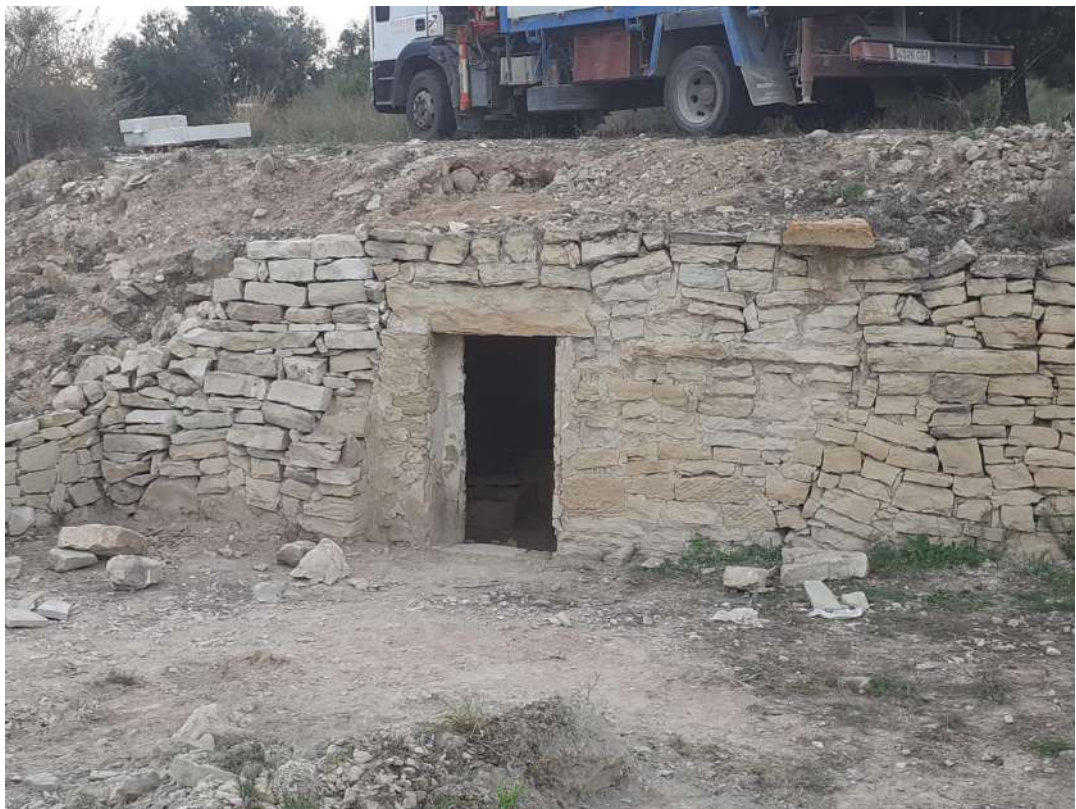
Fig. 66: Aspecto casi final tras rellenar de ripio y tierra la parte superior del refugio
