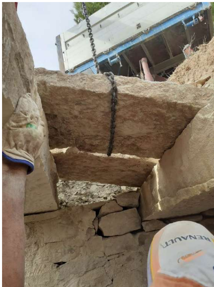
Fig. 56: Vista de la colocación de una de las losas sobre las vigas
