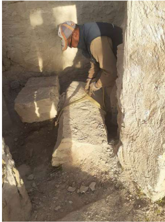
Fig. 41: Extracción viga fracturada por medios mecánicos
