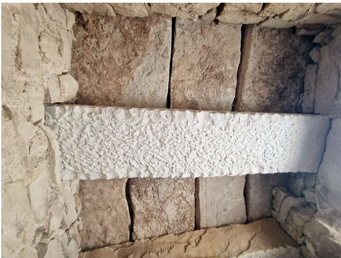
Fig. 91: Detalle aspecto final de parte del techo recuperado
