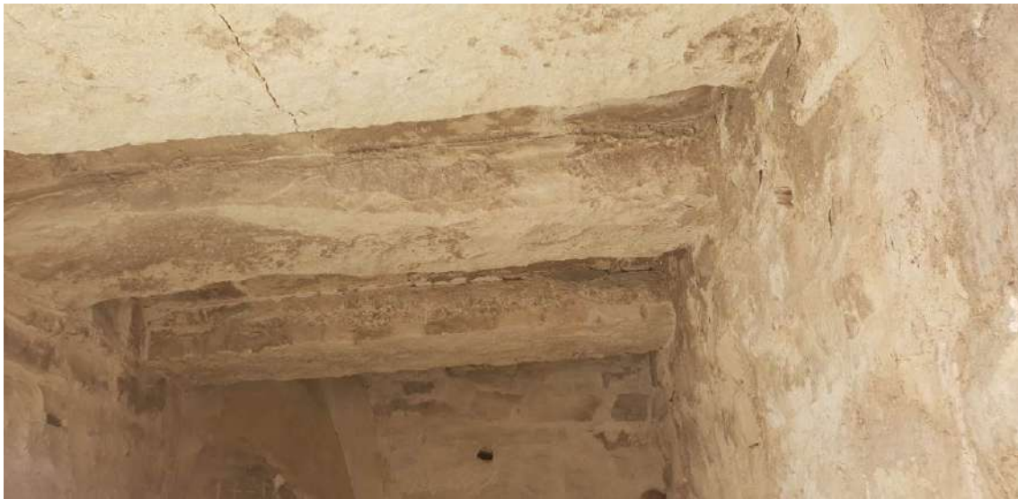
Fig. 23: Vista del interior del refugio en la actualidad, con sus grandes vigas de sujeción del techo
