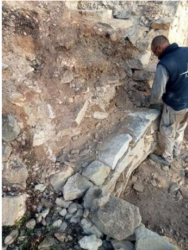
Fig. 44: Proceso de reconstrucción fachada sur del refugio
