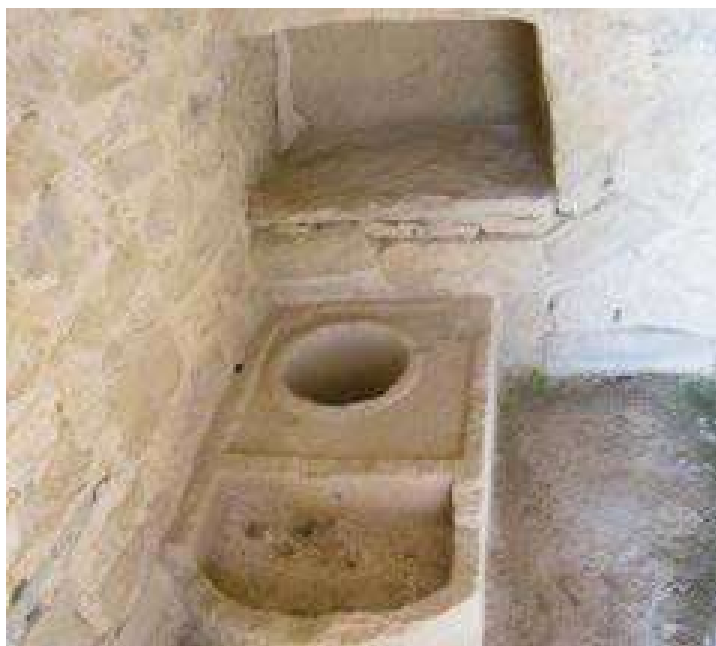
Fig. 27: Depósito de agua, pileta y alacena lateral antes del derrumbe de parte de la techumbre. Foto Ayuntamiento de Monóvar
