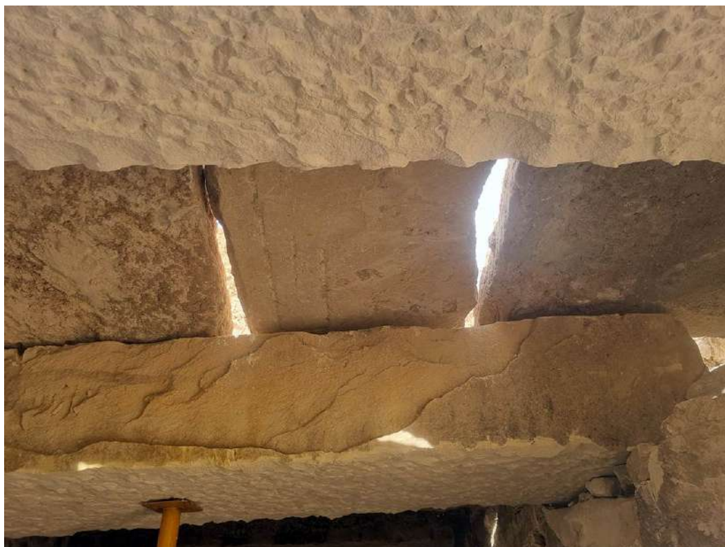
Fig. 60: Vista desde el interior de las grandes vigas y las losas colocadas sobre las mismas
