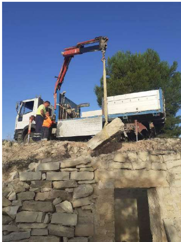
Fig. 42: Proceso extracción vigas rotas del refugio por medio de un camión grúa
