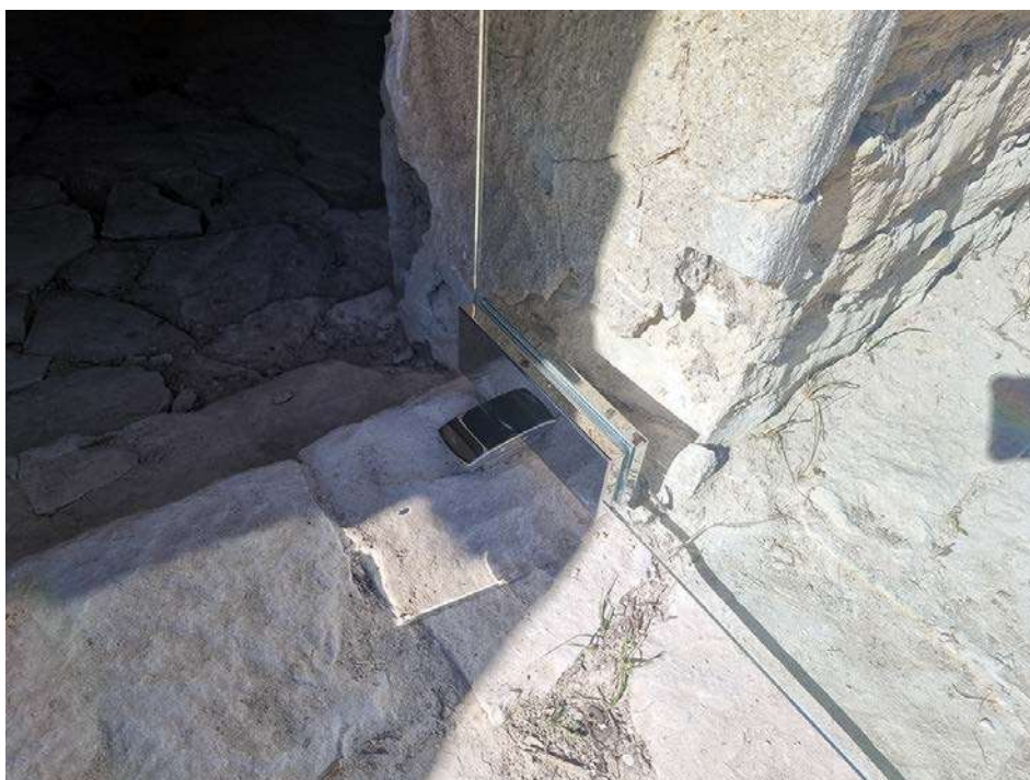
Fig. 78: Parte inferior de la puerta de vidrio con su inserción al umbral de acceso al refugio
