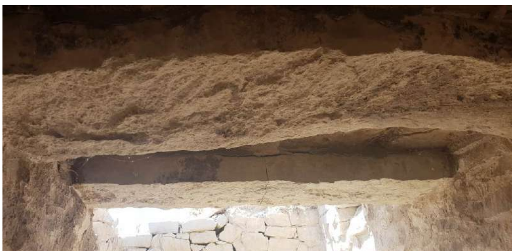
Fig. 22: Vista del interior del refugio en la actualidad, con la zona derruida en el acceso al refugio. Se observan las importantes vigas de piedra que aguantan el techo
