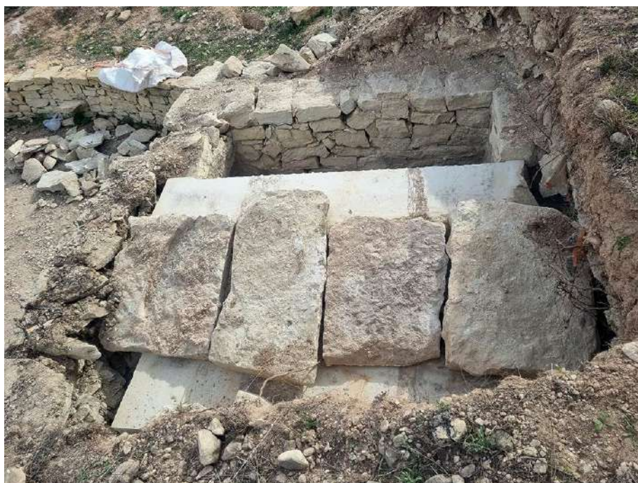
Fig. 57: Colocación de varias losas sobre las vigas instaladas
