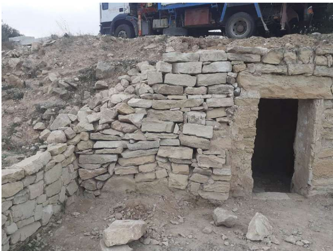
Fig. 61: Aspecto final, tras recuperación fachada sur del refugio con la técnica de la piedra seca
