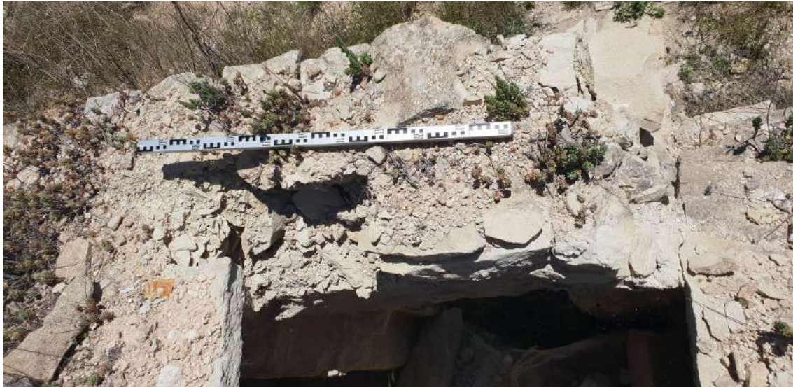
Fig. 10: Vista del hueco en la techumbre del refugio tras el colapso de una de sus vigas de piedra. Área de acceso al refugio
