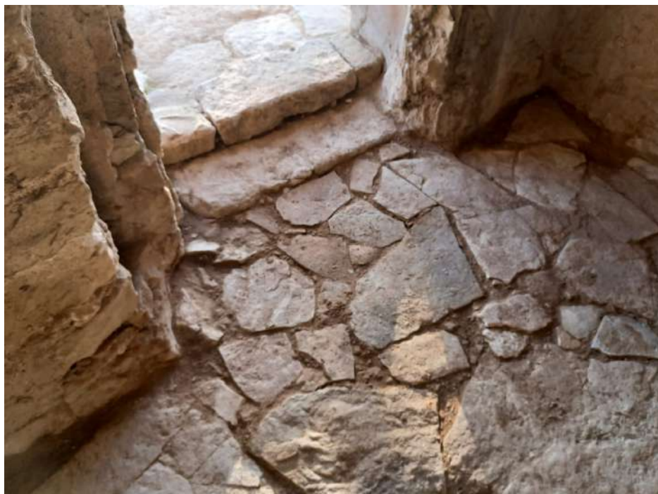
Fig. 71: Aspecto del pavimento en el acceso al refugio, una vez recuperado
