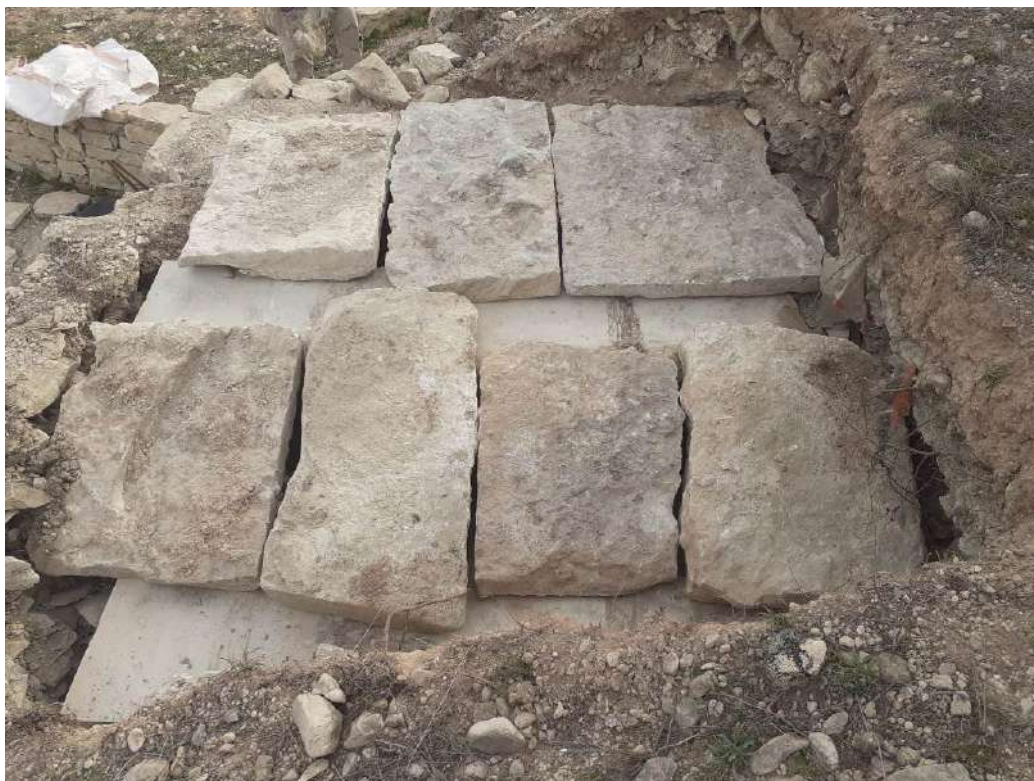
Fig. 59: Vista de las losas colocadas sobre las vigas repuestas
