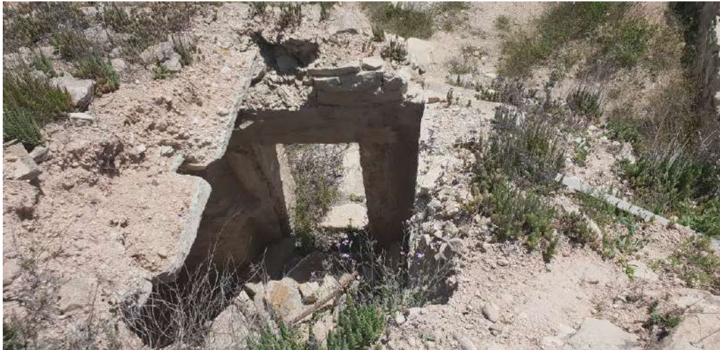
Fig. 25: Vista del importante hueco provocado por la rotura de la primera viga del entablamento de la techumbre del refugio
