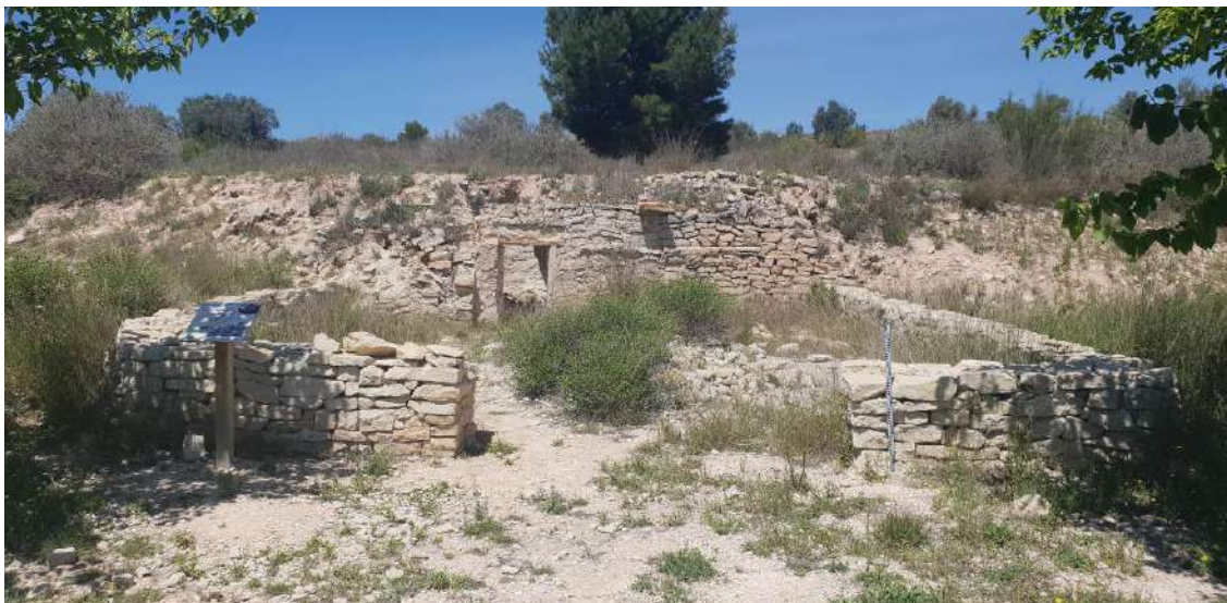
Fig.6: Refugio y muros previos contruidos como antesala al refugio, para enmarcar su situación. Estos muros no son originales y se construyeron como experiencia práctica de realización de muros de piedra seca
