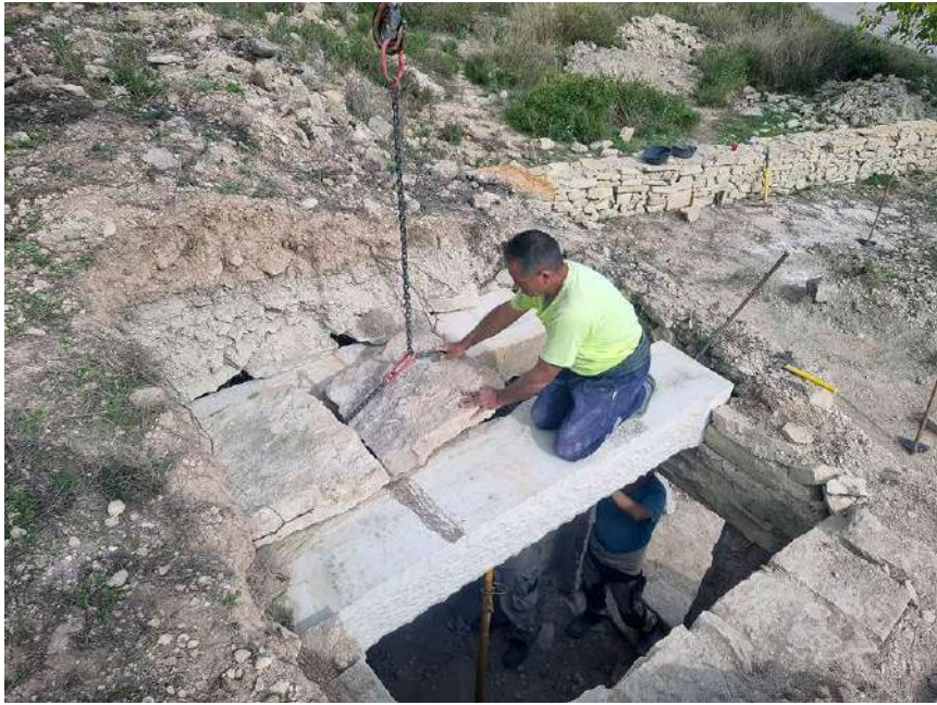
Fig. 55: Proceso colocación primeras losas sobre las vigas
