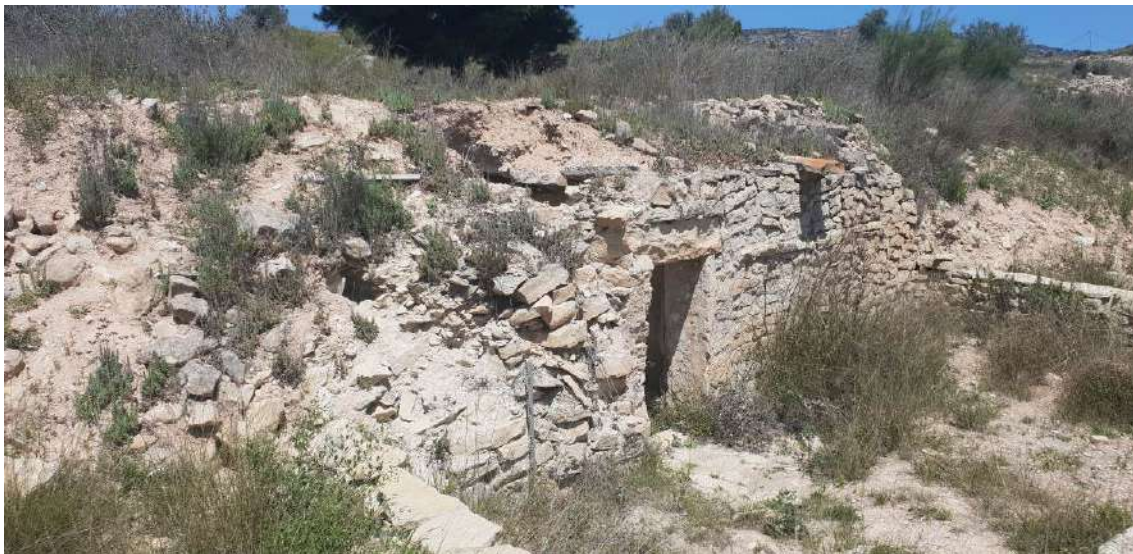
Fig. 11: Vista del refugio desde el sur, con la zona desmantela de su fachada y el techo cedido en el acceso al edificio
