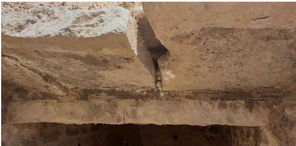
Fig. 24: Vista de las losas apoyadas sobre las vigas de la techumbre, que están en peligro de derrumbe, por la fisura de la segunda viga del refugio
