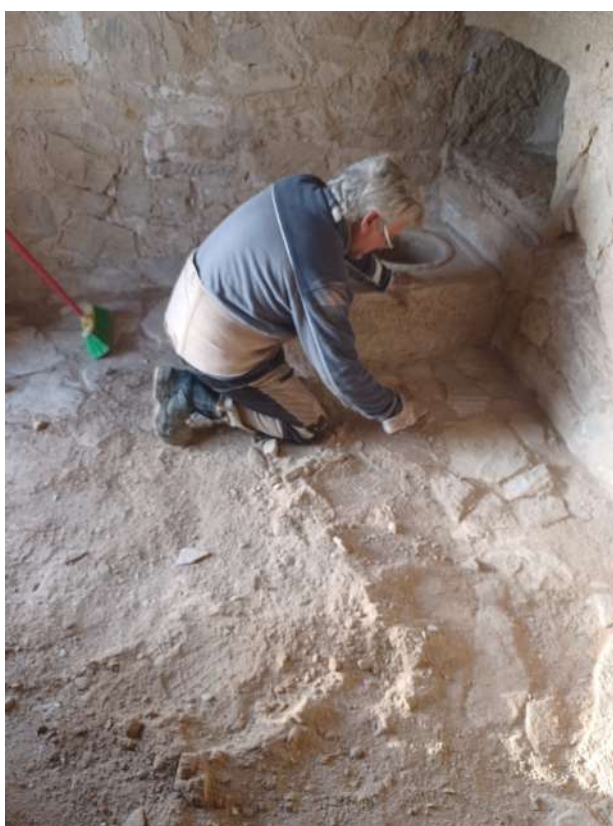
Fig. 69: Limpieza y saneado del pavimento de losetas en el interior del refugio
