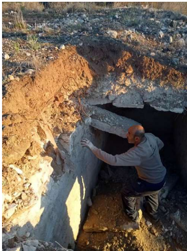
Fig. 34: Proceso de saneado de la cubierta cedida
