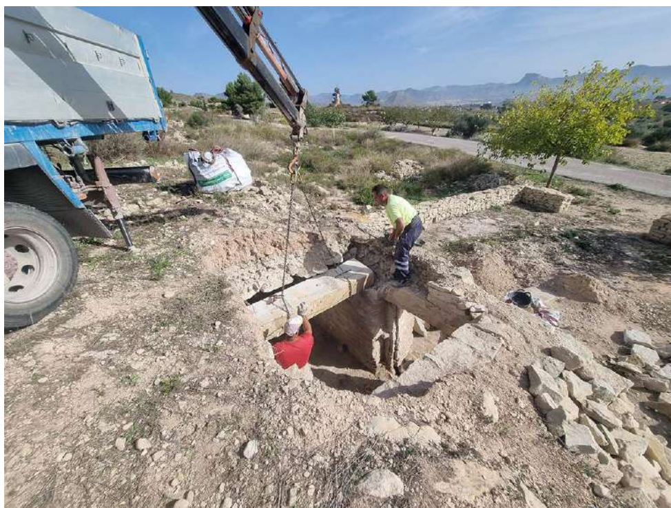
Fig. 49: Proceso de colocación de gran viga nueva sobre el refugio
