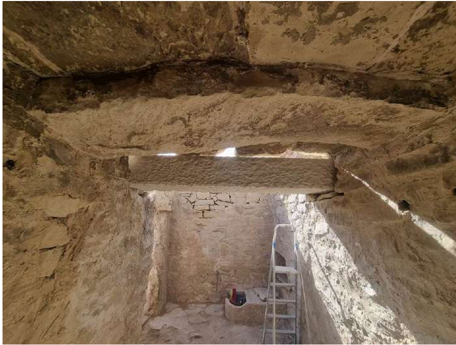
Fig. 51: Vista del interior una vez colocada la primera viga repuesta
