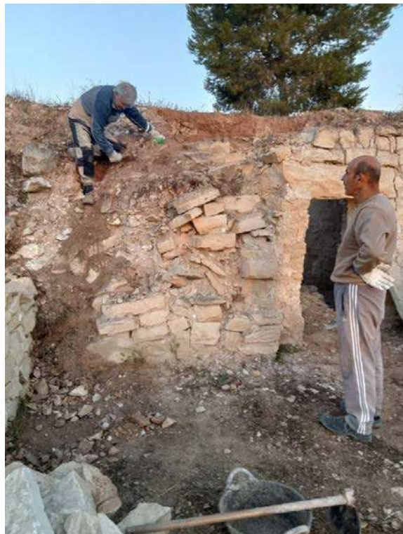
Fig. 43: Limpieza y saneado de la fachada sur del refugio
