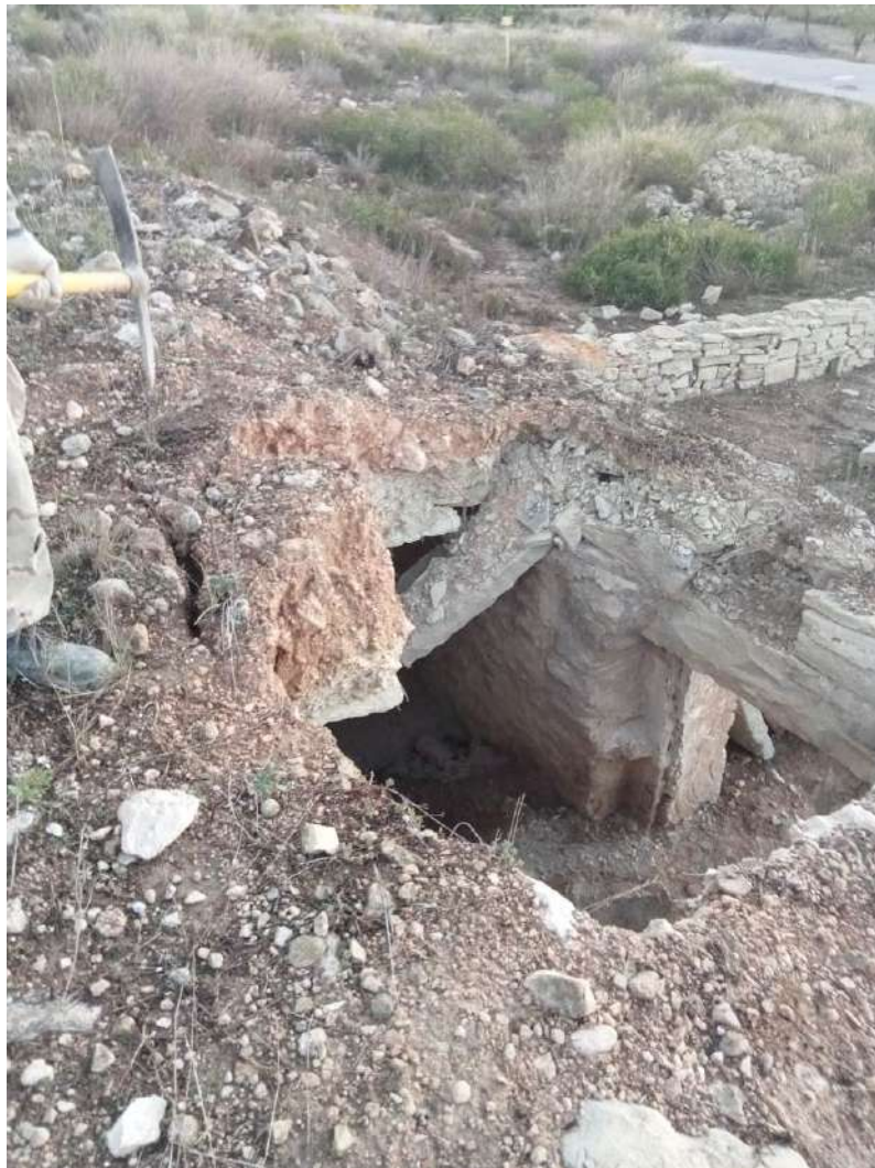
Fig. 32: Inicio proceso saneado cubierta cedida
