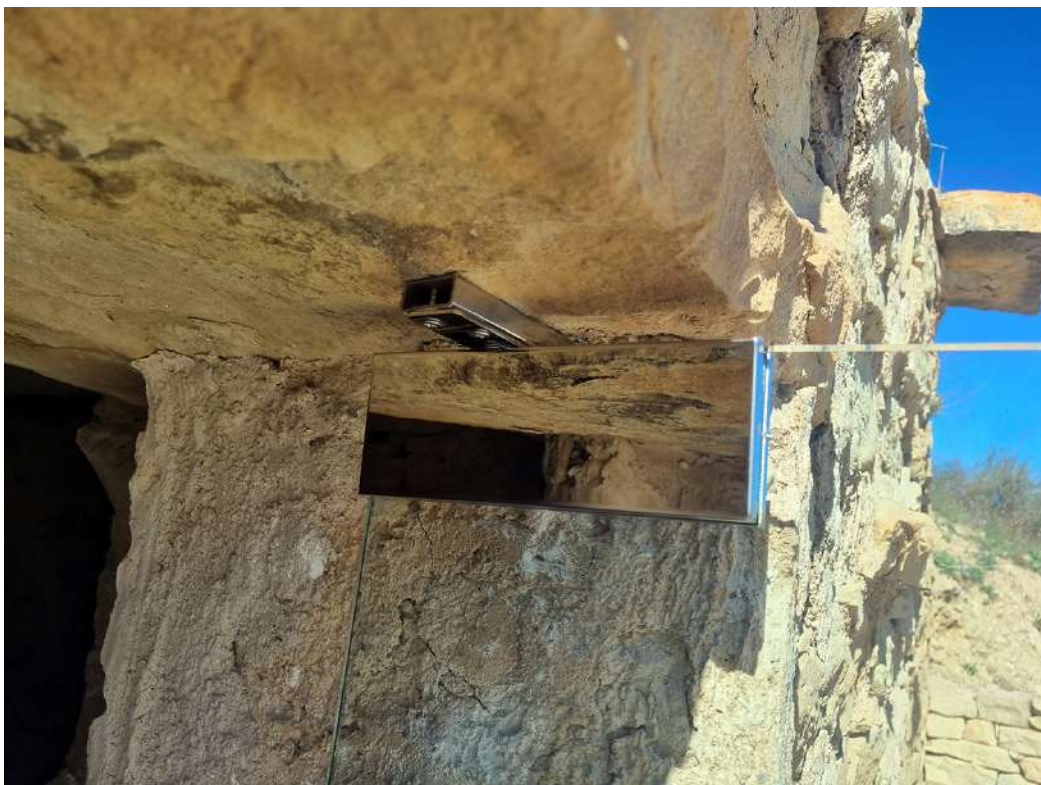
Fig. 77: Detalle de parte de los enganches de la puerta de vidrio en el dintel de acceso al refugio
