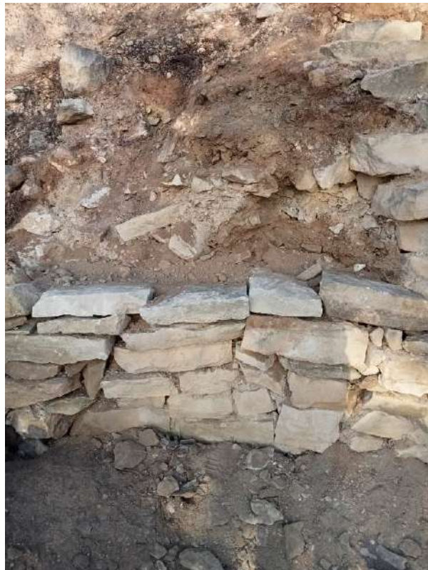
Fig. 45: Proceso reconstrucción muro del refugio, su lateral meridional
