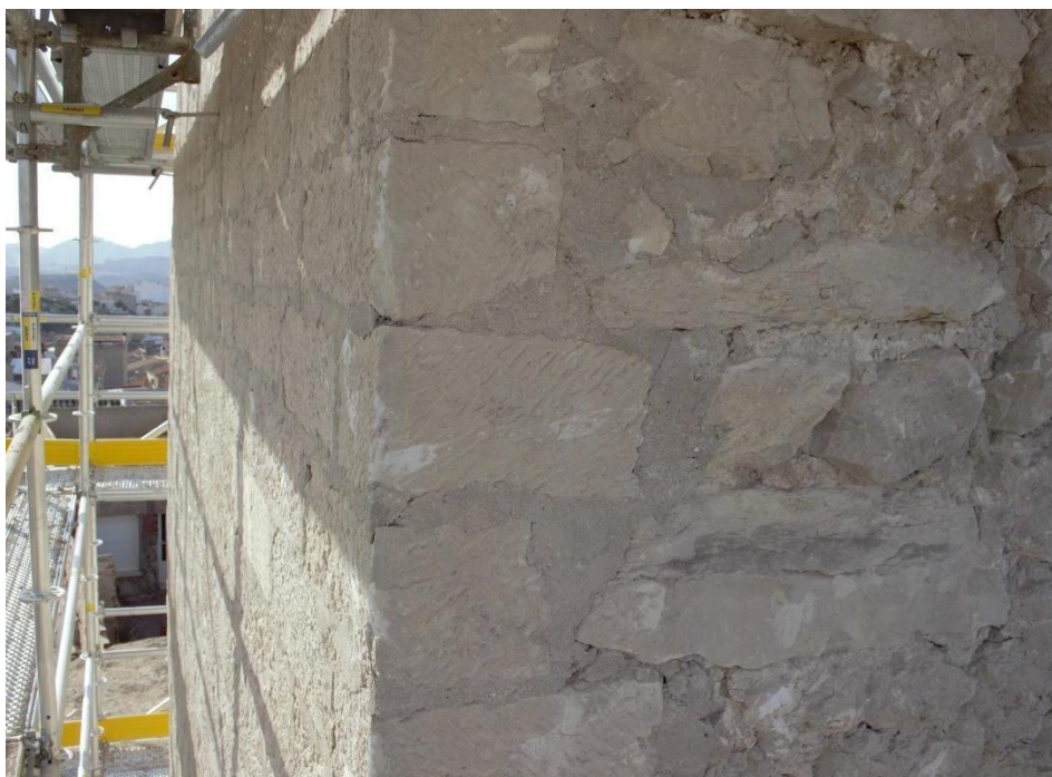
Imagen 12- Fachada oeste, esquina con fachada norte, se observa los dos tipos de mampostería cosidos
