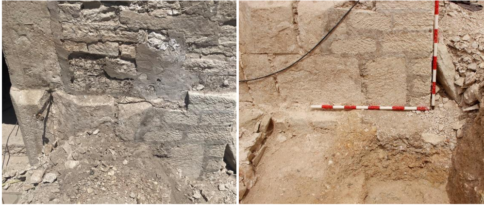
Imagen 8- Zócalo de piedra tras la retiradas de varias unidades de escombros en la fachada sur de la torre
