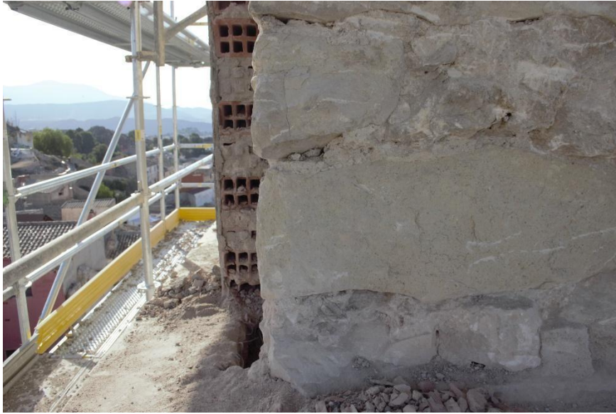
Imagen 10- Detalle de la capa de ladrillos en el segundo cuerpo, se observan los ladrillos apoyados sobre la cornisa en la esquina noroeste
