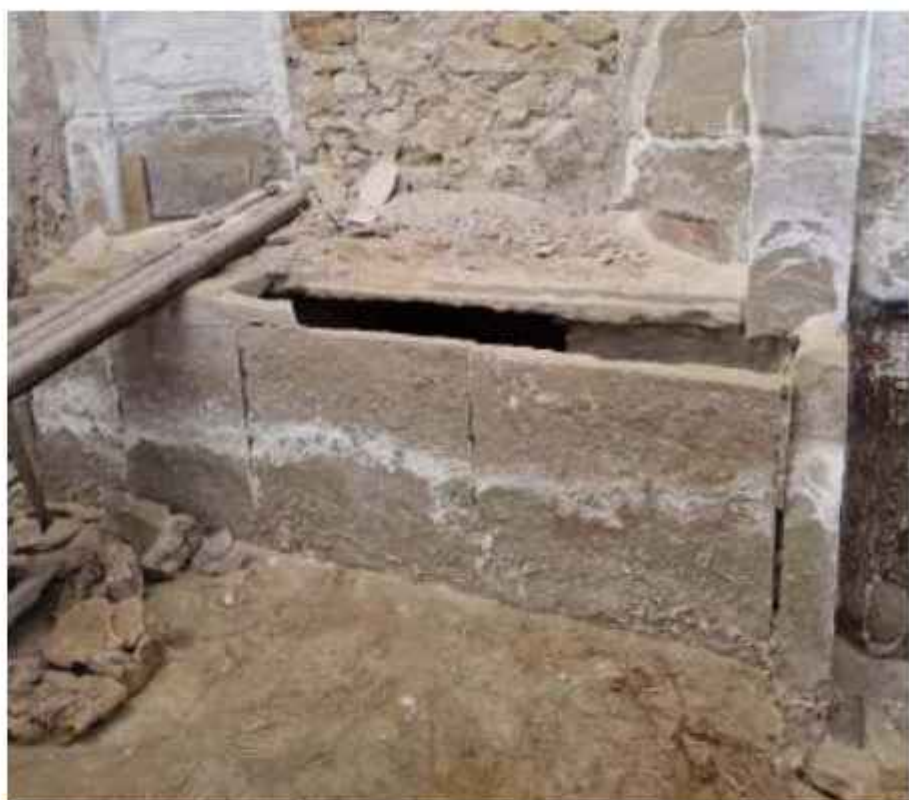
Fig. 124_Detalle de la construcción de la mesa del altar oeste, donde vemos cómo se ensamblaron grandes losas de piedra, hasta constituir una caja, de la que desconocemos el objetivo o el uso
