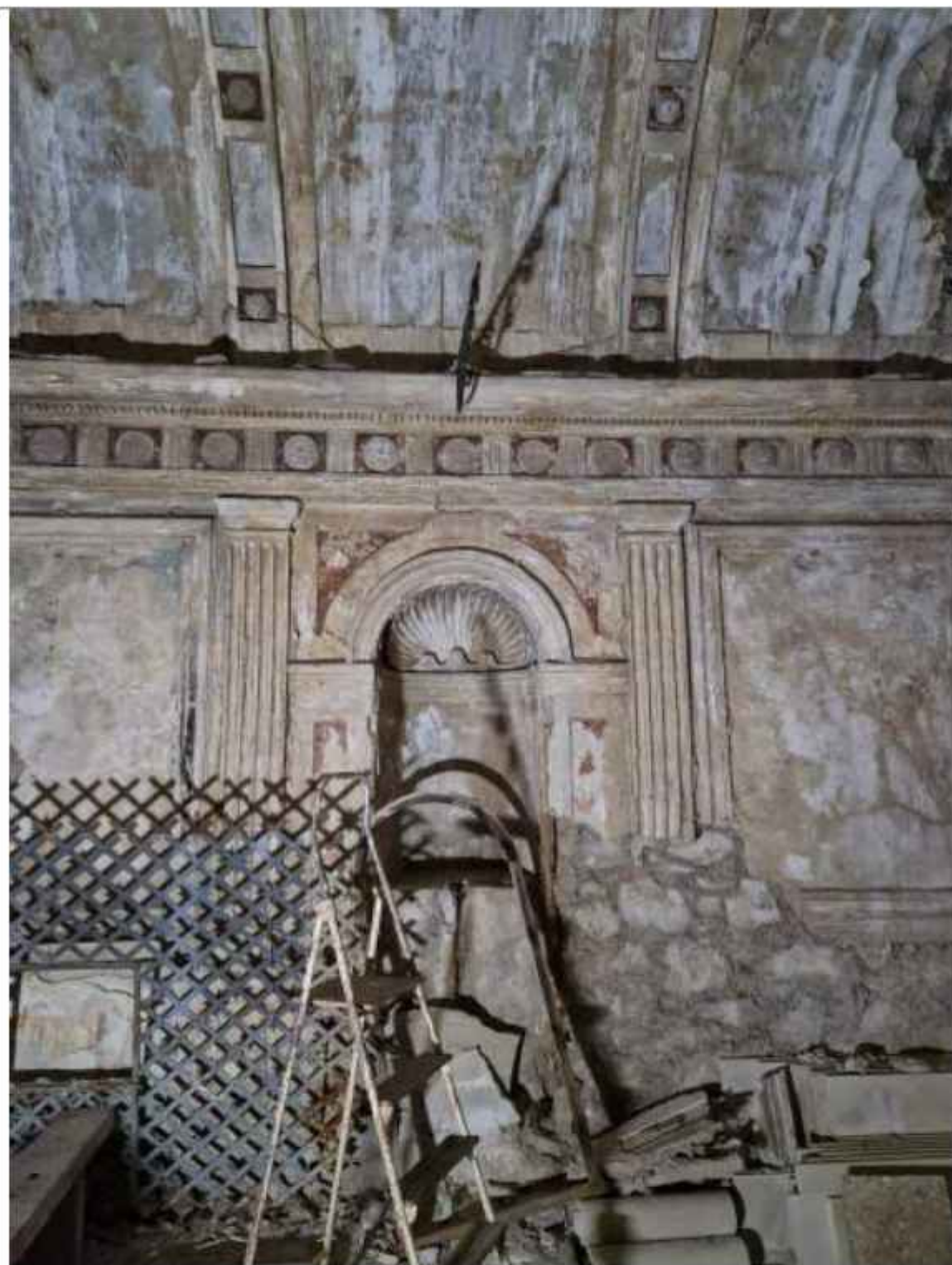
Vista del nicho lateral, con la ordenación arquitectónica de la decoración. Se aprecia el altísimo grado de deterioro
