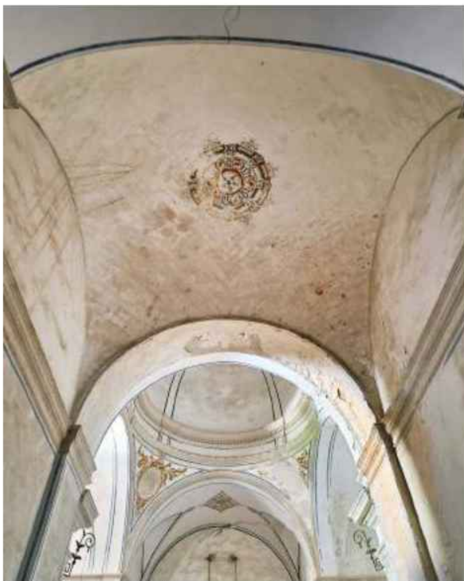
Fig. 193_Vista de la cúpula de la nave que conecta la iglesia con la Capilla de San José. La humedad ha afectado al revestimiento, marcando perfectamente la huella de la hoja de ladrillos que conforma la estructura de la cúpula, lo que permite ver su patrón de colocación
