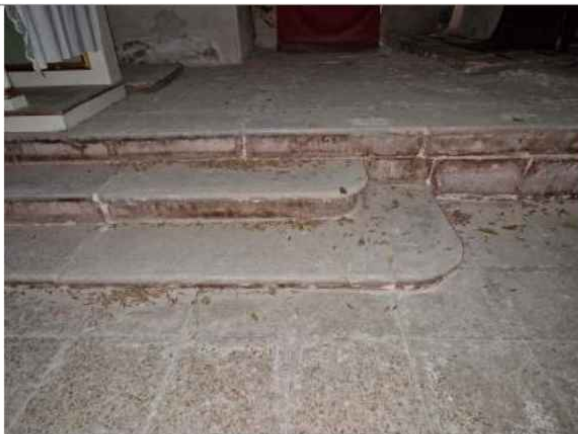
El pavimento de terrazo se superpuso al original, recriendo la cota, recubriendo así parte del primer escalón de acceso al presbiterio
