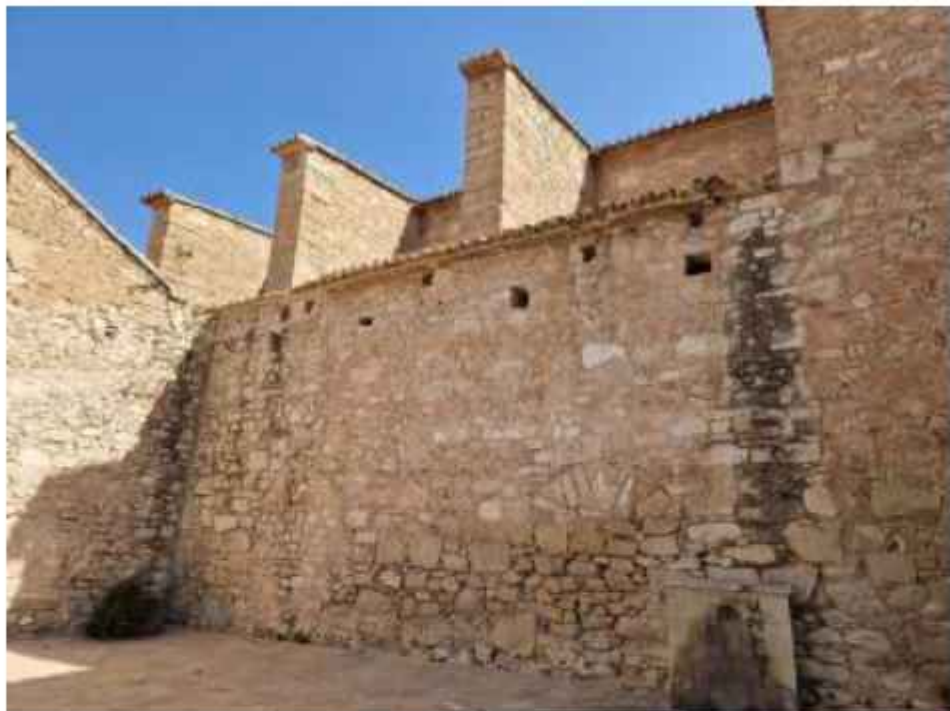
Fig. 197_Vista de la fachada norte de la iglesia, donde vemos también la huella de la antigua cubierta, con los mechinales en los que se apoyaban los pares, y el arco de una puerta de comunicación con las capillas laterales
