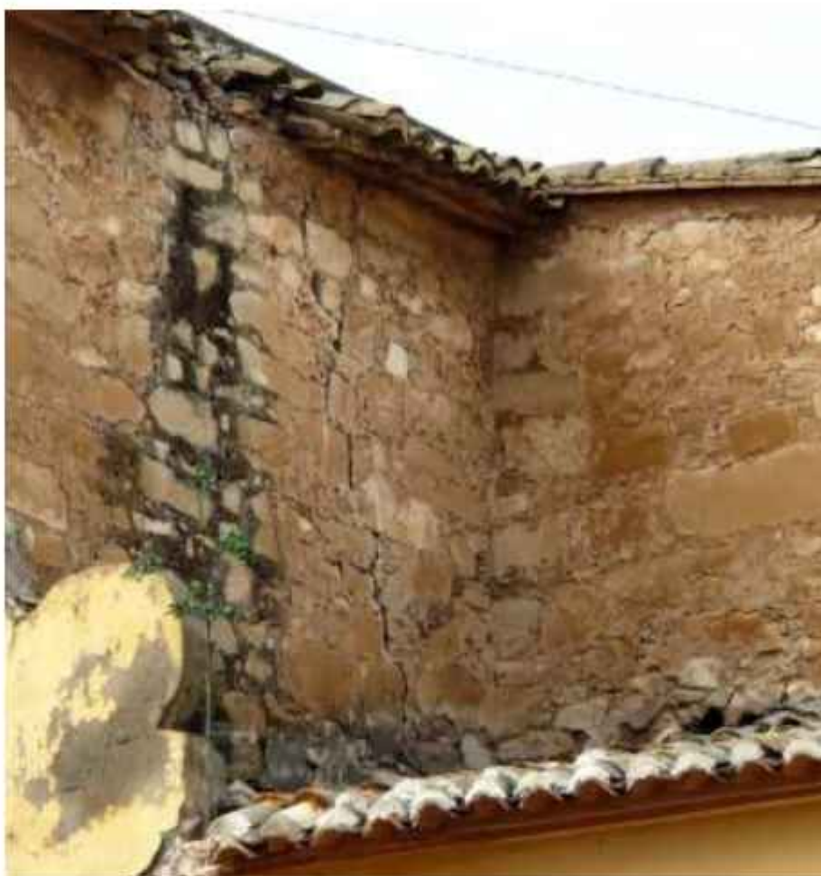
Vistas exteriores de las grietas visibles desde el coro, en los muros sur (arriba) y norte (abajo) de la nave
