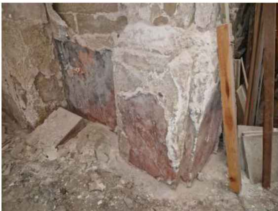
Vista de la base de un pilar de la Capilla de San José, con la presencia masiva de sales y humedad
