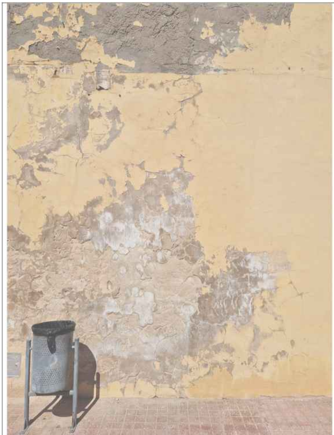
Estado de deterioro del enlucido, con presencia de sales, grietas, pérdida de la capa superficial, y erosión
