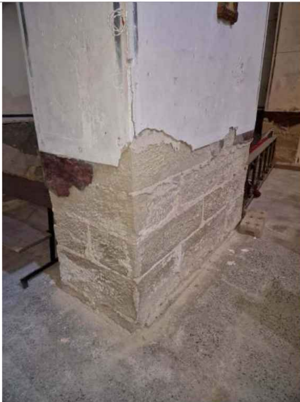
Base de uno de los pilares de la nave central, con la falta del enlucido correspondiente al zócalo
