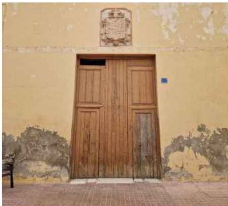
Fig. 108_Cara exterior de la puerta de entrada de la iglesia. Se distinguen las dos hojas originales, con sus puertas de paso y plafones, y la hoja central, añadida posteriormente
