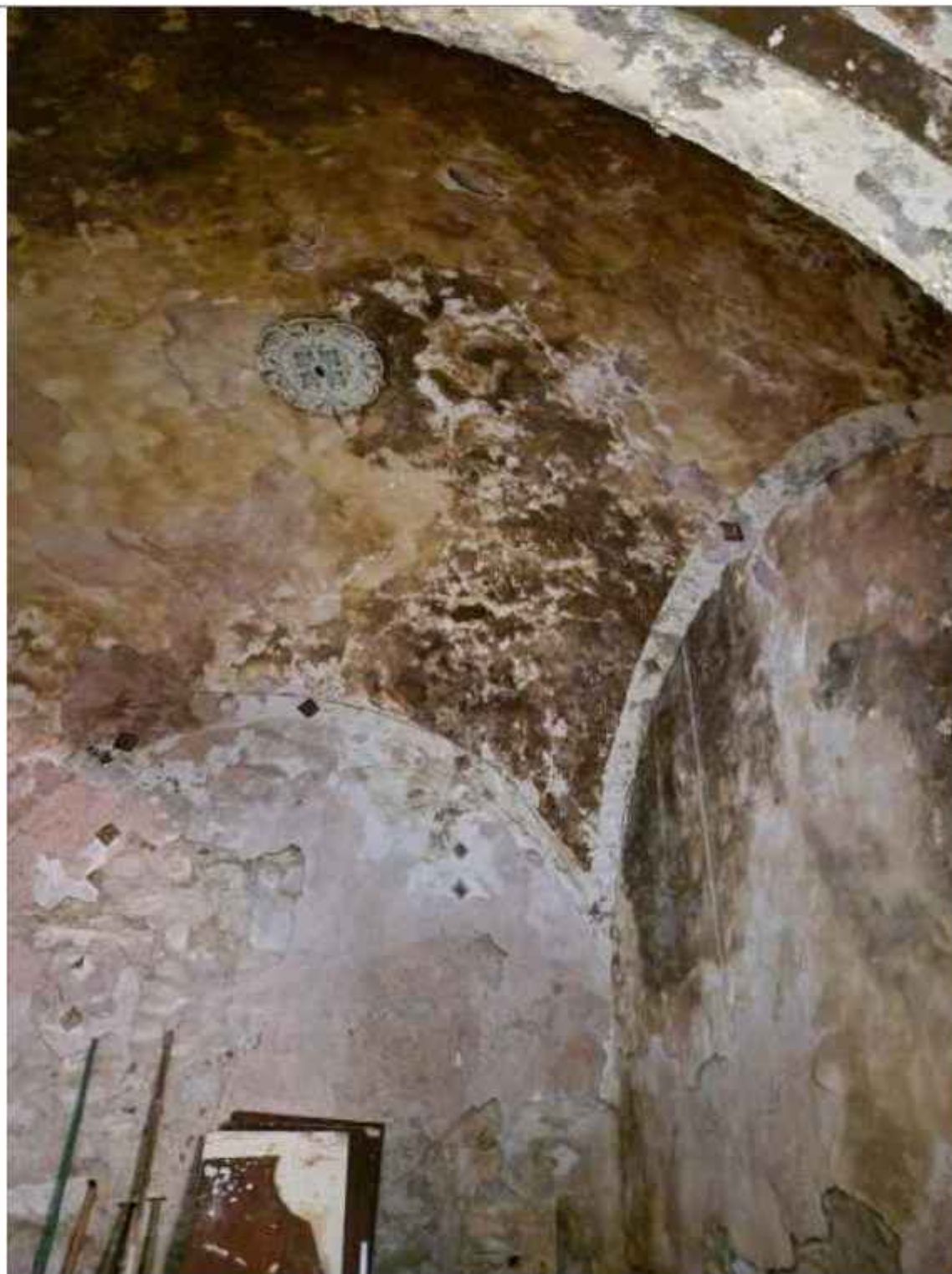
Detalle de las manchas de humedad en una de las esquinas de la sala, con la presencia de microorganismos.
