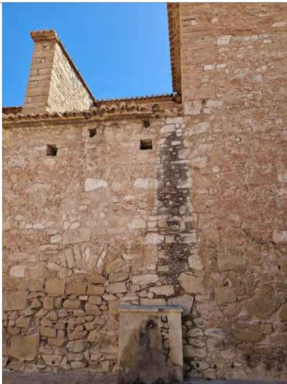
Vista de la fachada norte de la iglesia, con la presencia de musgo y microorganismos que han crecido en la zona húmeda que corresponde a la caída de gua desde la gárgola
