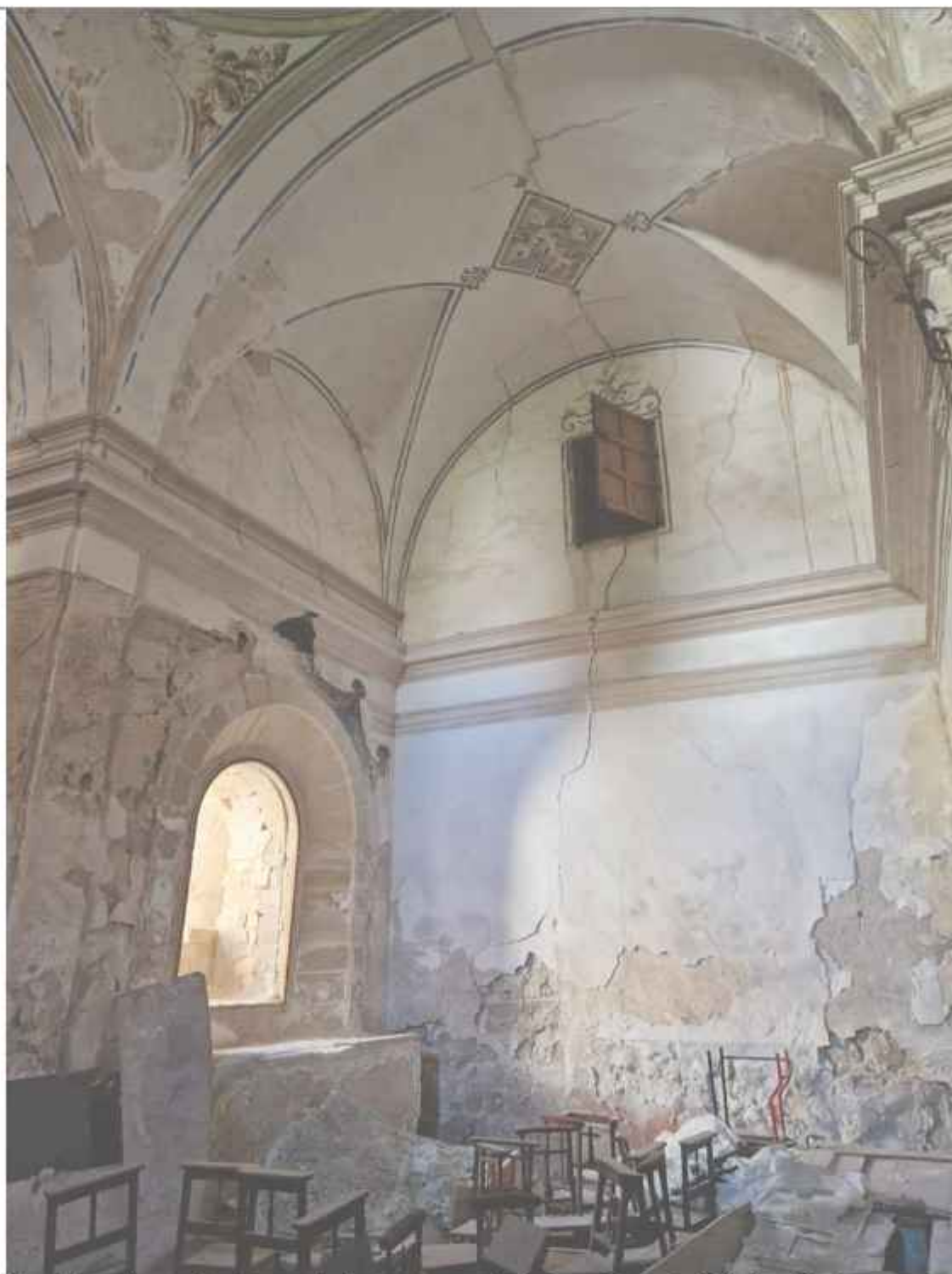
Vista de la capilla este, donde se aprecia la extrema presencia de humedad en toda la fábrica y bóveda
