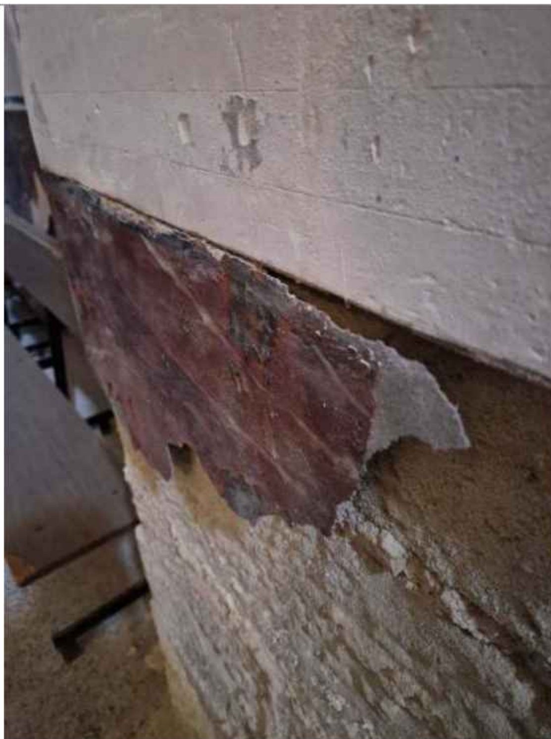
Detalle de uno de los zócalos, donde se ve la fina capa de pintura, sobre su preparación. Se observa cómo se han separado las diferentes capas
