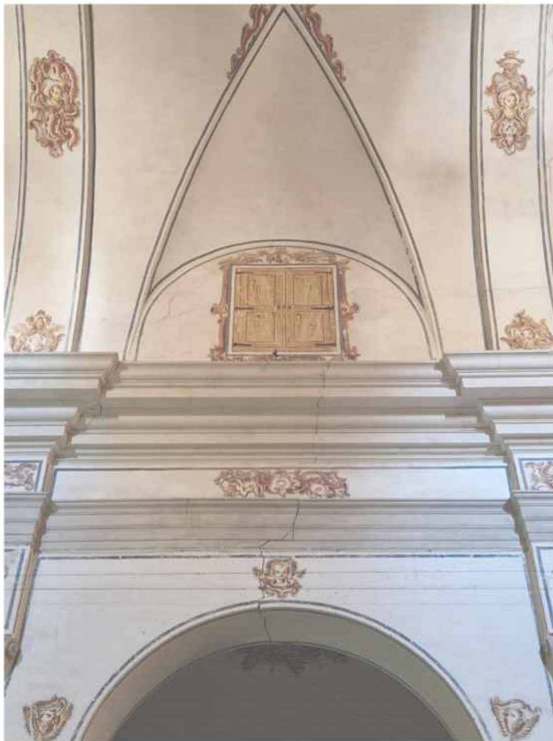
Grieta vertical en el centro de una de las crujeas de la nave central, pasando por la clave del arco de la capilla
