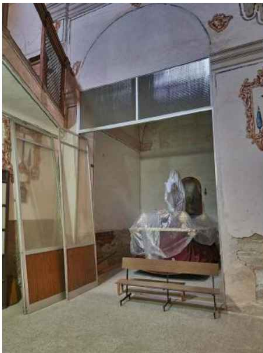
Fig. 117_Carpintería de aluminio colocada como cierre de la Capilla de San Juan Bautista, y que ha necesitado el cegado del arco. Se trata de un elemento impropio, que debe ser retirado
