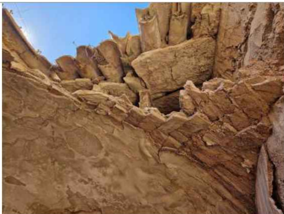
Detalle del sistema constructivo de la bóveda y cúpula de la sala situada detrás del altar este
