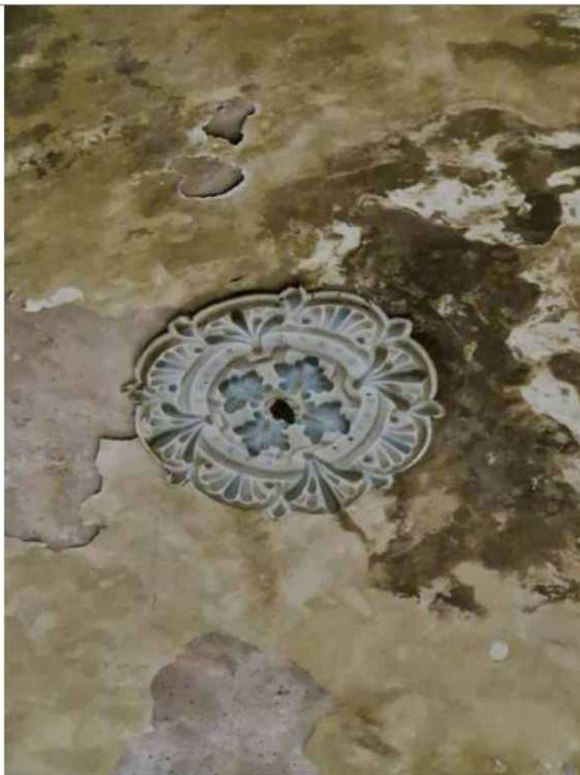
Detalle de la cúspide de la cúpula de la sala situada en el sotocoro, donde se ve la presencia de microorganismos
