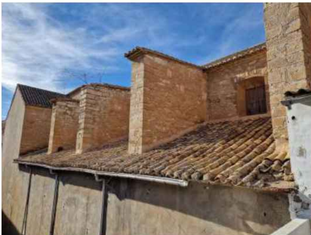
Vista de las cubiertas del colateral sur. Se ve el deterioro de todas las cubiertas, incluso de los contrafuertes
