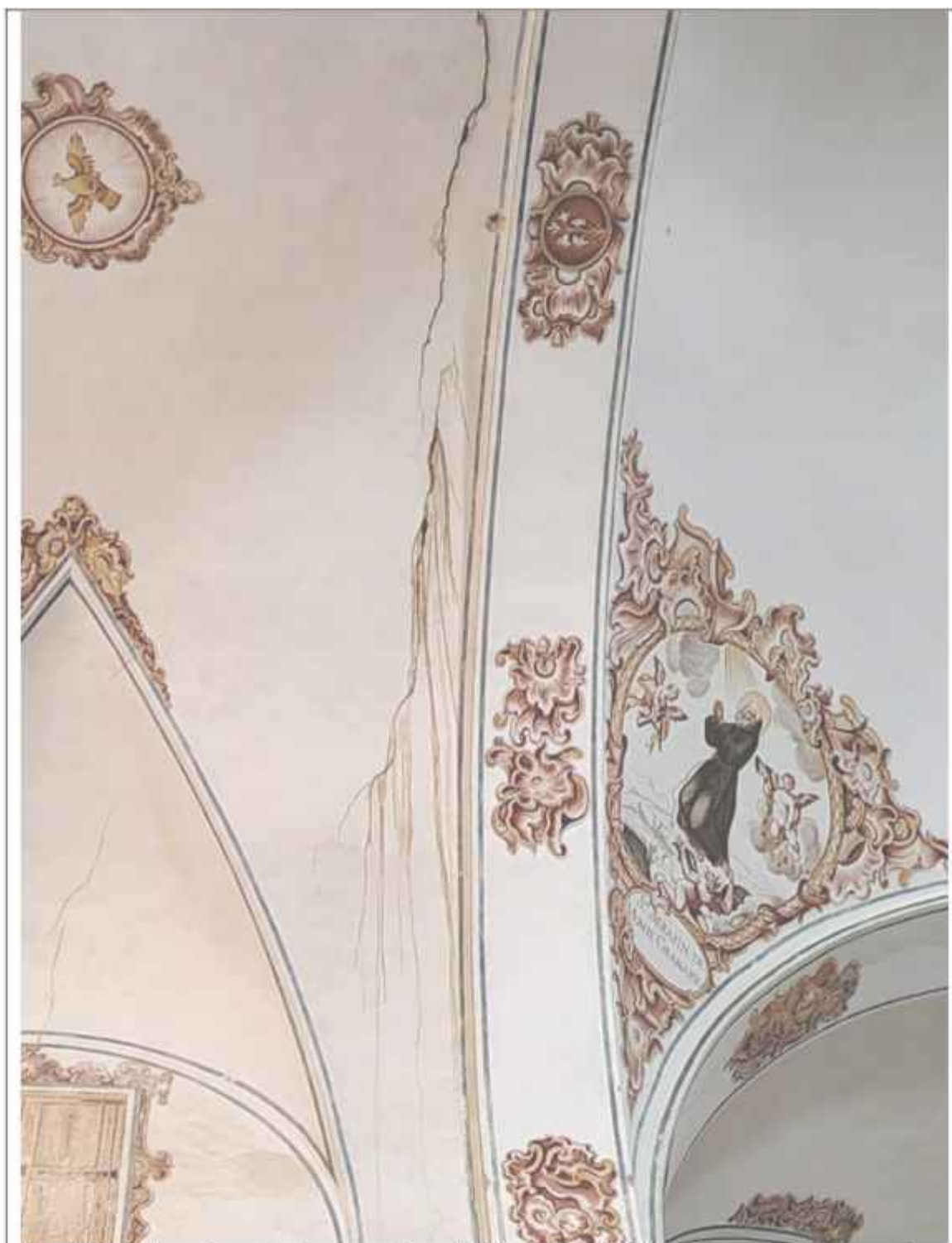
Vista de la bóveda, con la mancha de agua con barro, debido a la filtración de la lluvia por una gotera y una grieta
