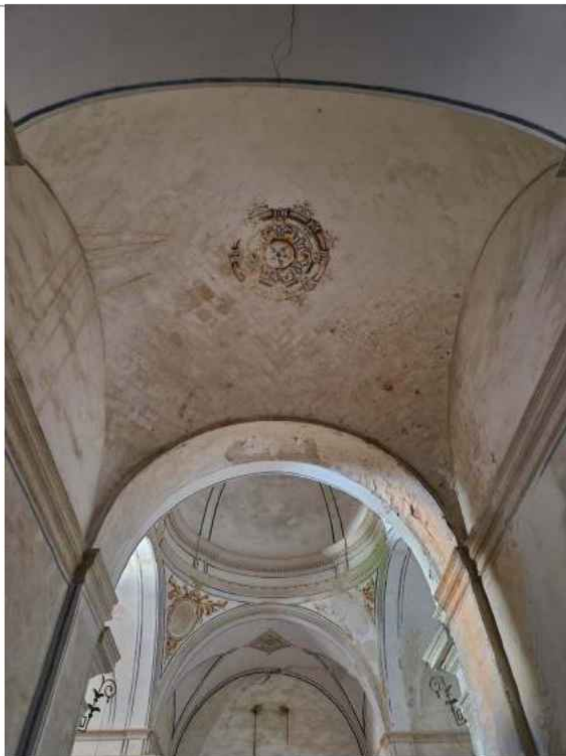
Vista de la zona de paso entre la Capilla de San José y la nave principal, con el deterioro de enlucidos debido a las filtraciones de agua
