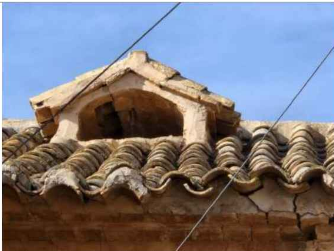
Imagen de un casetón de entrada al espacio bajo-cubierta
