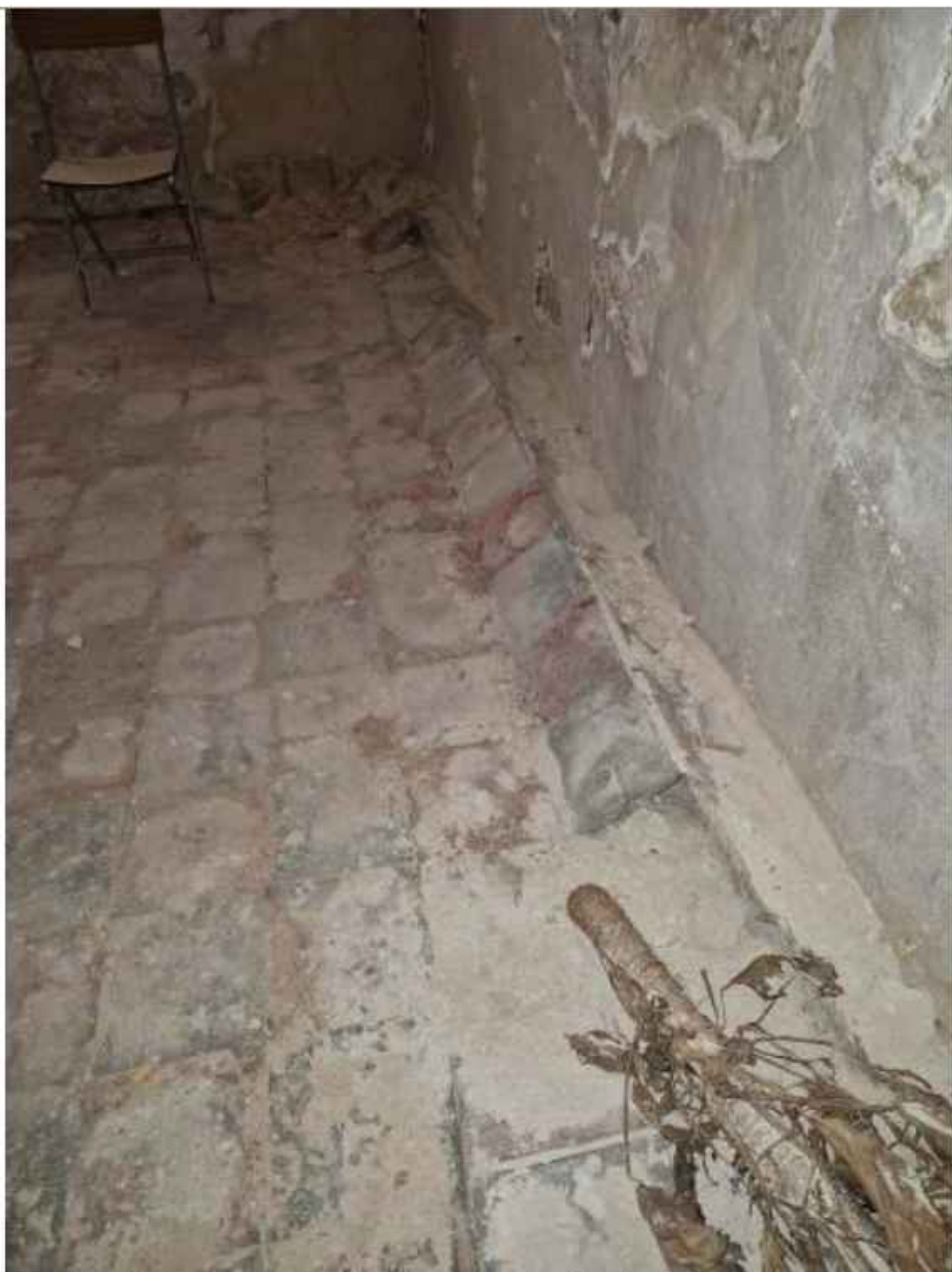
Zona perimetral del pavimento de la sacristía, en la que se ven los efectos de la dilatación, y de la presencia masiva de humedad en el subsuelo, llegando a levantar varias hiladas del pavimento
