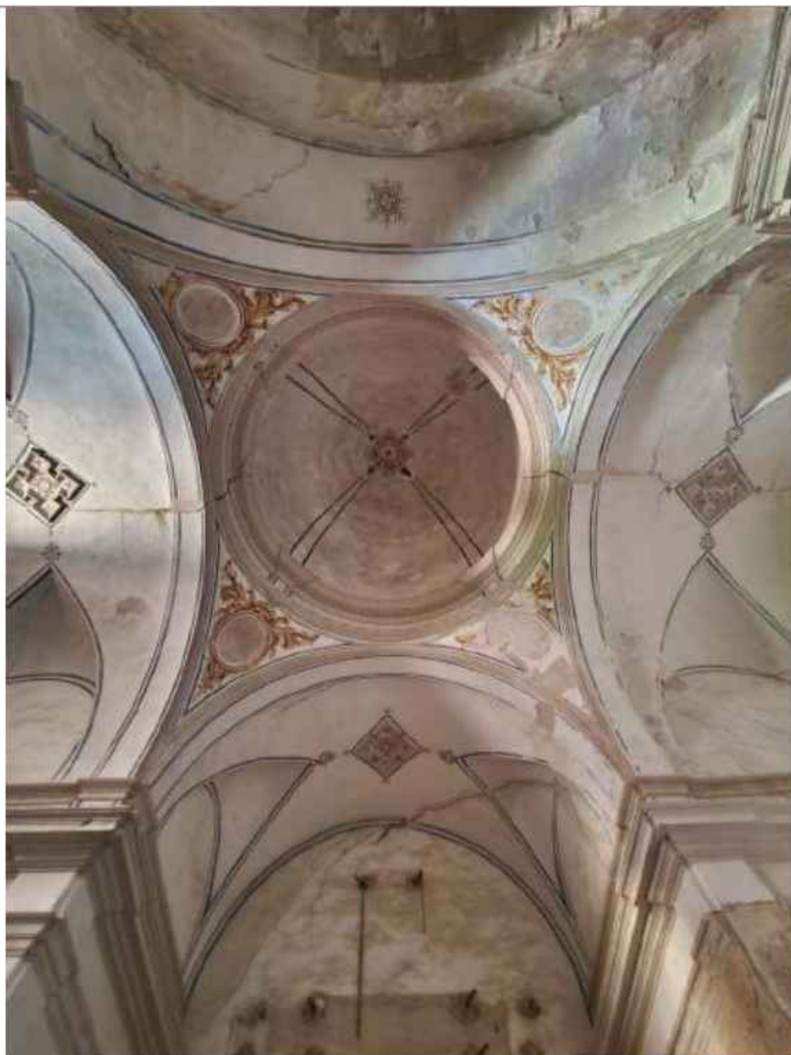
Vista de la cúpula de la Capilla de San José, con la pérdida de policromía, debido a las filtraciones desde las cubiertas
