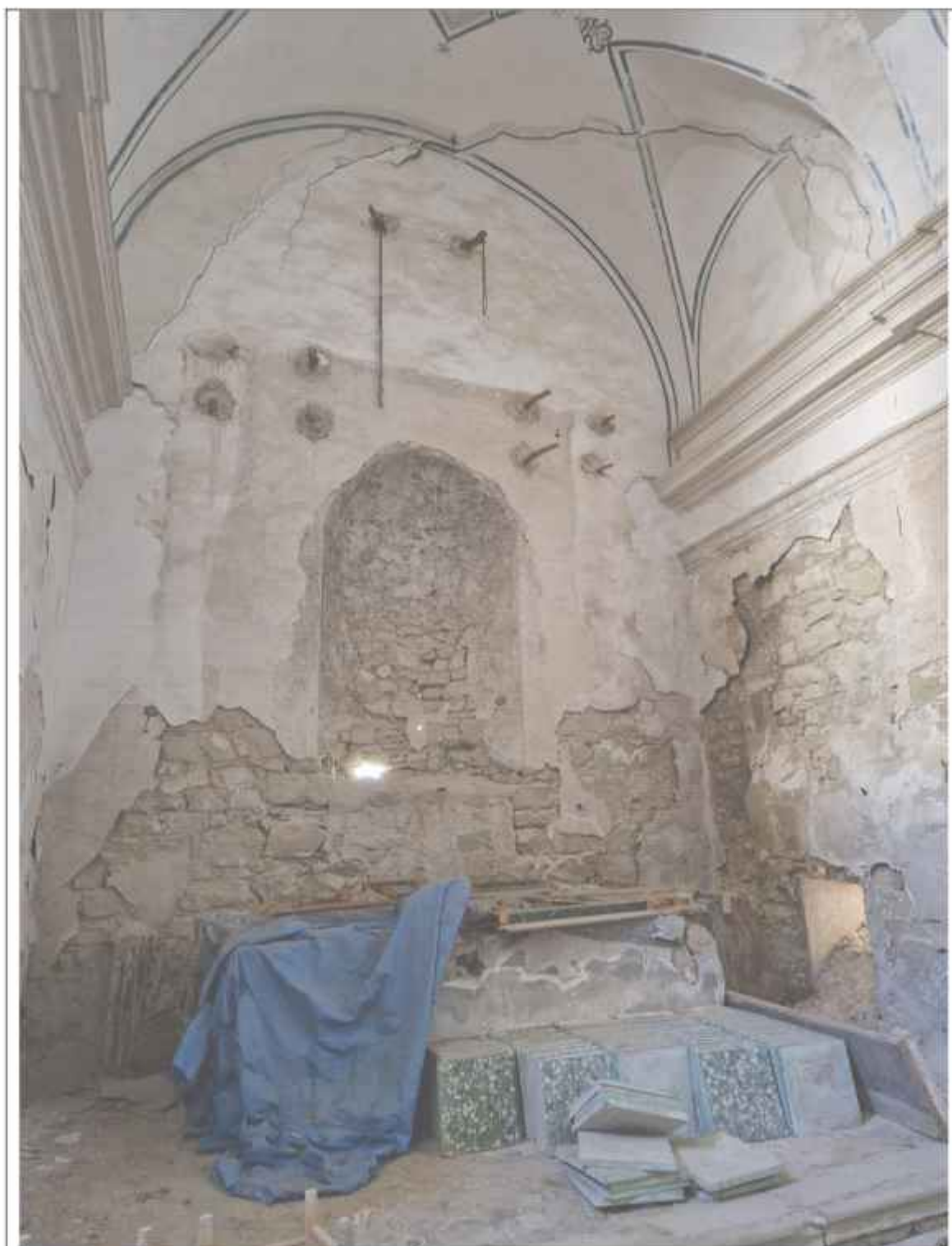
Vista de la Capilla de San José, con la pérdida de los enlucidos en la parte baja de los muros
