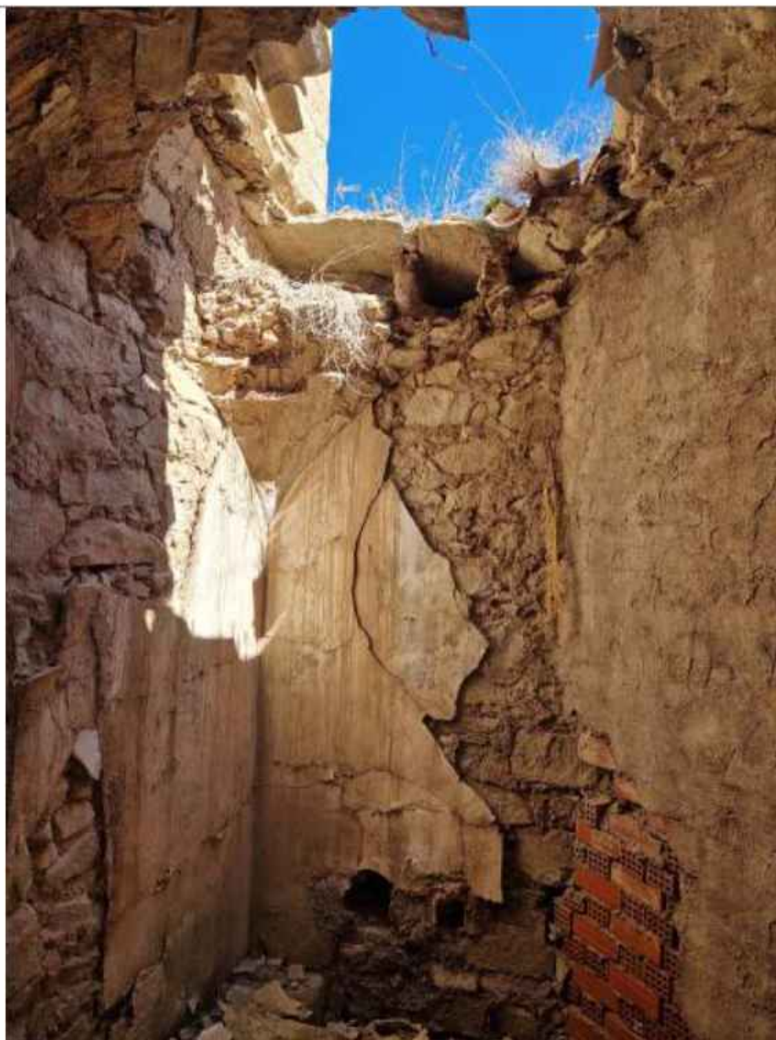
Imagen del agujero en la cubierta del espacio trasero del altar lateral este, con el deterioro de los muros, y la destrucción del enlucido, con el resto de pintura decorativa de la esquina
