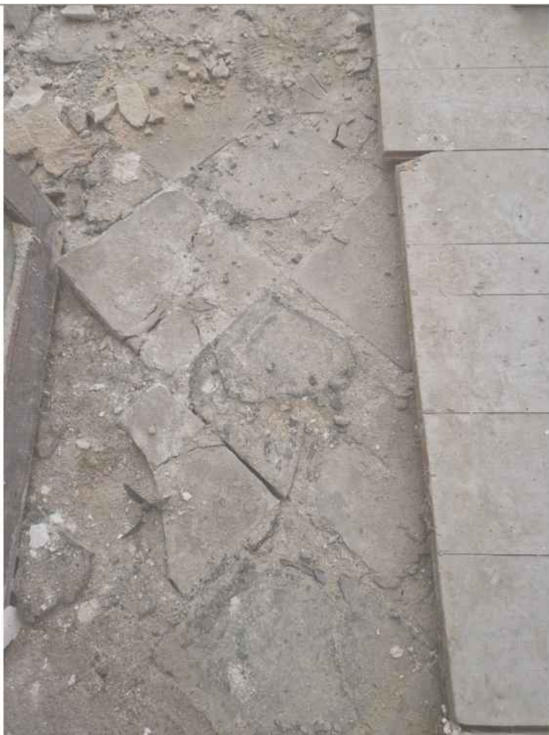
Detalle del pavimento de la Capilla de San José, donde se ven las baldosas rotas, escamadas, erosionadas, faltando trozos o piezas enteras
