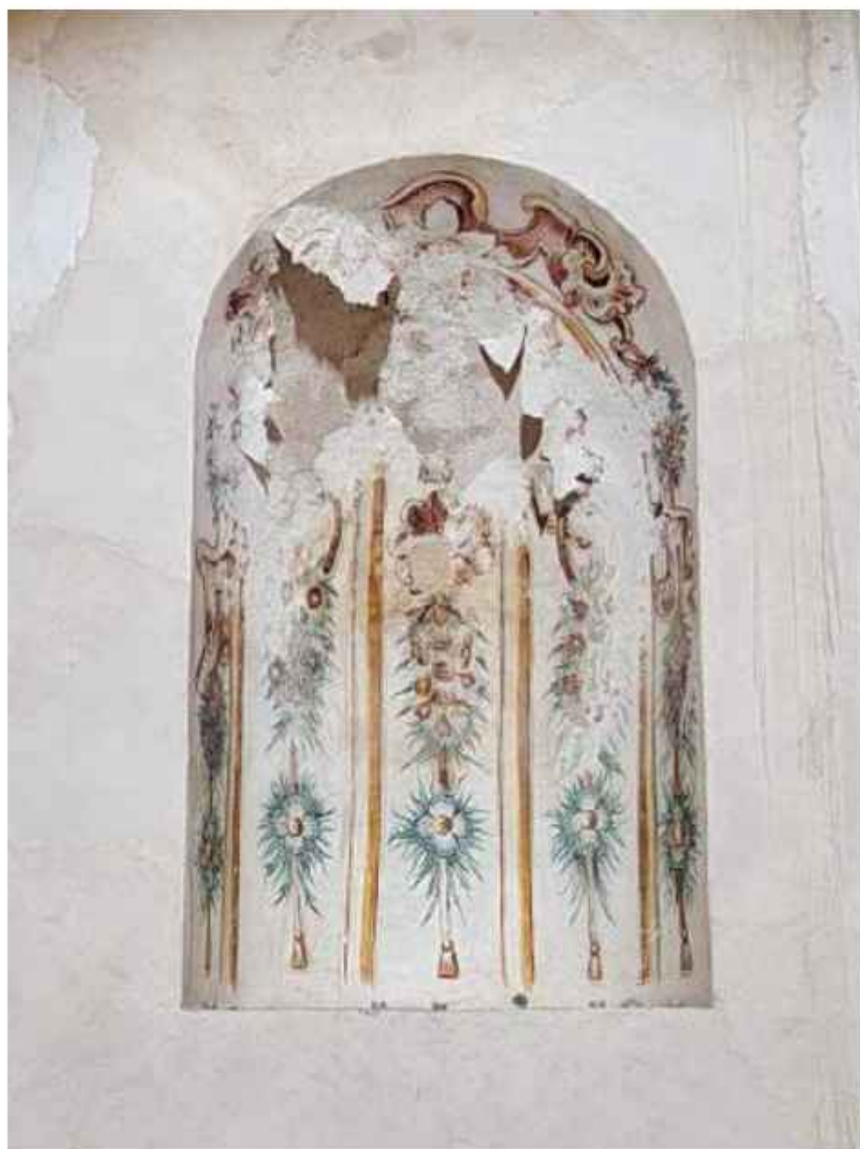
Fig. 189_Detalle de uno de los nichos de las capillas laterales, donde se ve el deterioro de la capa pictórica, que se desprende debido al ataque de las sales y la humedad excesiva
