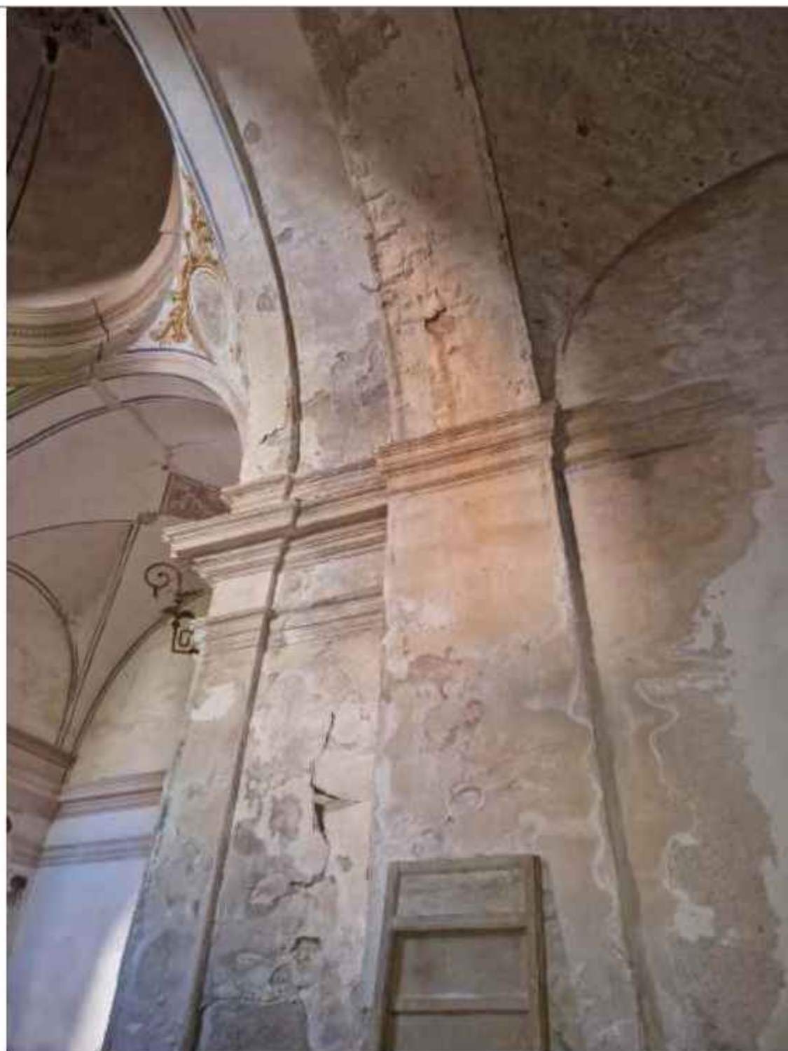
Vista de la zona de paso entre la Capilla de San José y la nave principal, con el deterioro de enlucidos debido a las filtraciones de agua, tanto en arco y cúpula, como en muros. En esta imagen, se llegan a juntar las filtraciones que llegan desde arriba por culpa de filtraciones en cubierta, con las humedades que llegan desde el suelo por subida capilar
