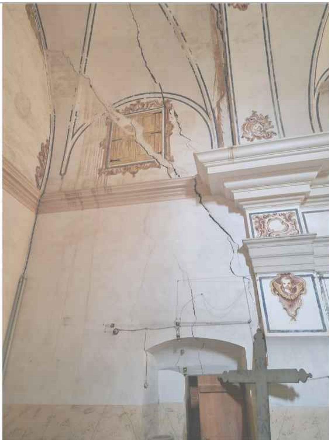
Vista del muro sur de la nave central, en el tramo del coro, donde se observan la grietas oblicuas que muestran el movimiento de vuelco de la fachada
