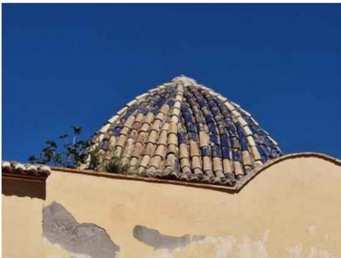
Vista de la cúpula de la Capilla de San José, con las tejas vidriadas picadas, e incluso algunas de ellas fueron sustituidas
