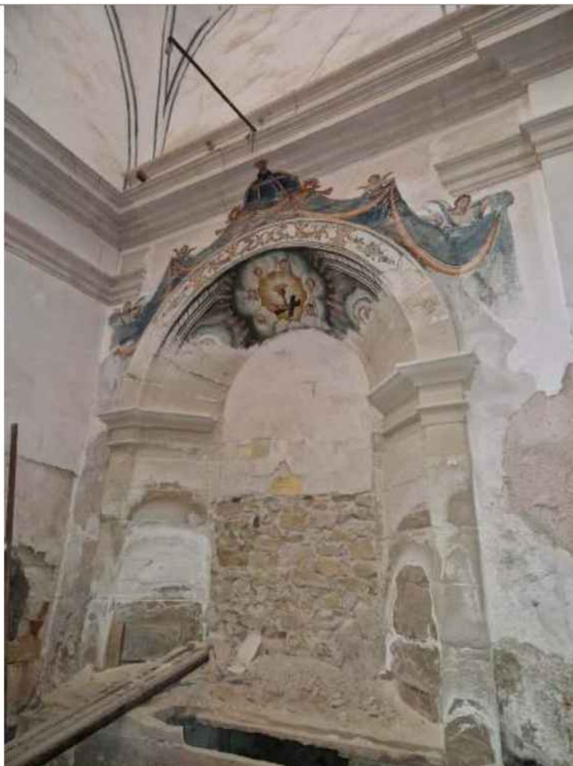
Vista del altar oeste de la Capilla de San José, con pérdida de policromía en las jambas y arranque del arco, por el efecto de la humedad
