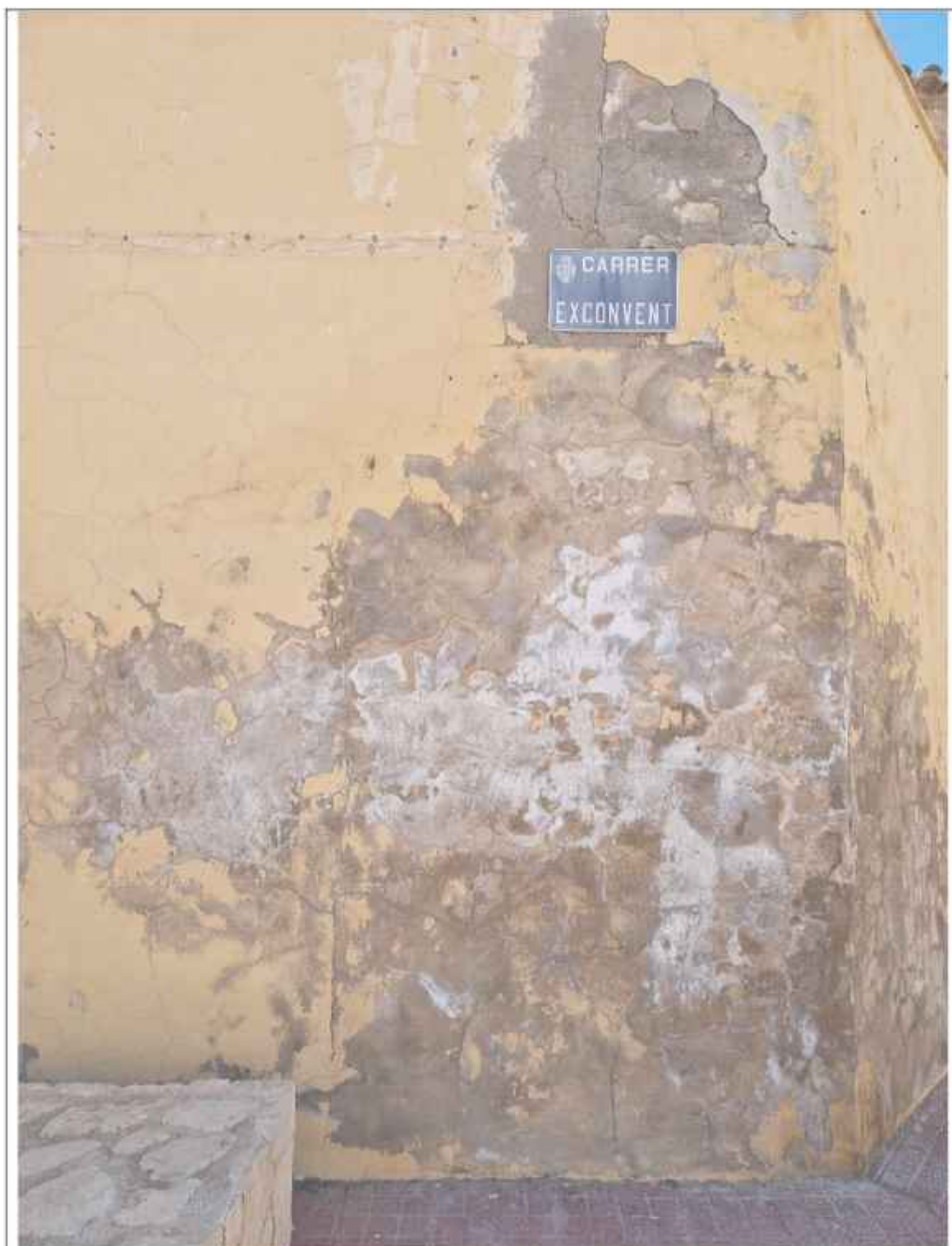
Detalle de la esquina noreste, donde se ve una grave afección por humedad, debido a la ausencia de tejado de la sala correspondiente. Esta zona acumula todas las patologías relacionadas con las filtraciones
