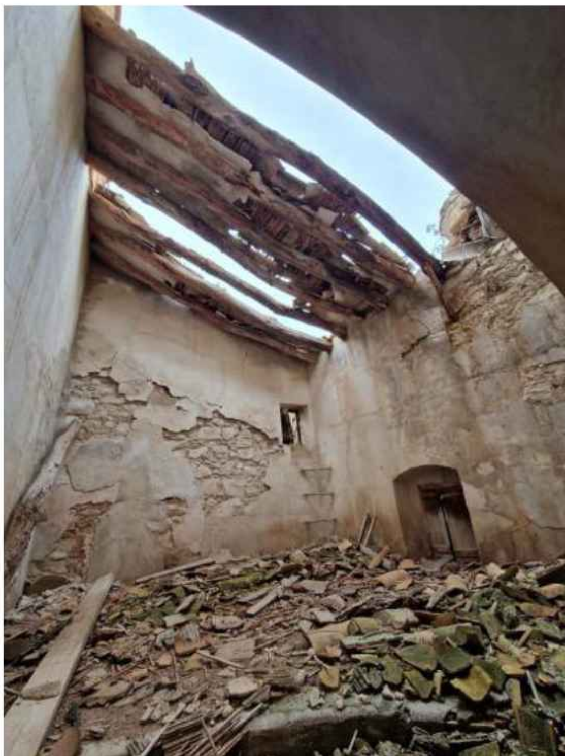
La cubierta de la habitación contigua al coro se encuentra derribada desde hace años, provocando una gran entrada de agua al edificio
