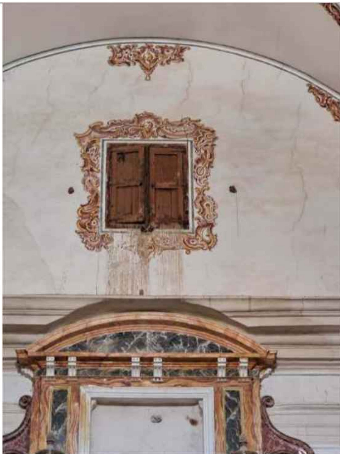
Presencia de múltiples fisuras verticales en la parte superior del muro del brazo sur del crucero
