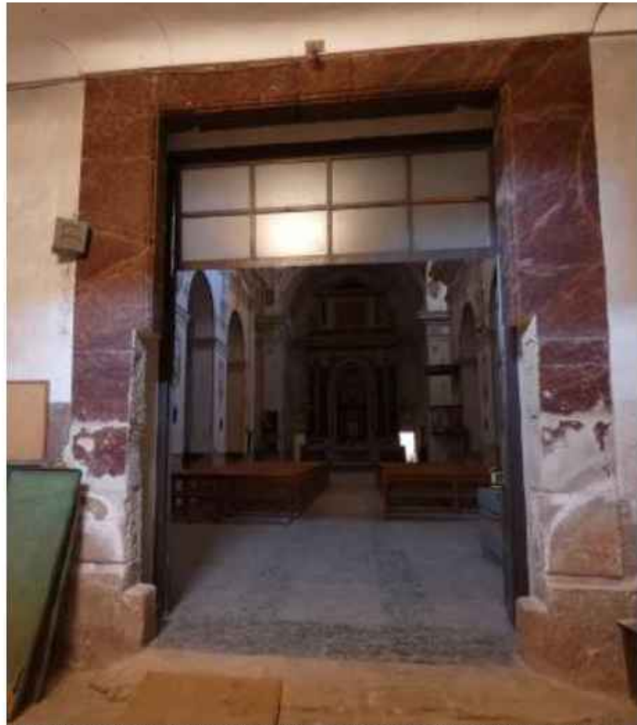
Fig. 91_Puerta de entrada de sillería pintada, con los recortes de las jambas para ampliar su anchura, probablemente destinado a dejar pasar el carro para la procesión
