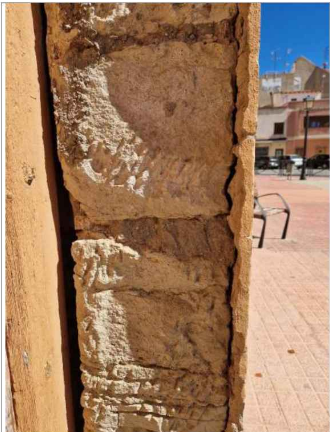
Detalle de la jamba derecha de la puerta de entrada, donde se ve que todo el enlucido se encuentra despegado del soporte, generando el riesgo de fracturación y caída de grandes trozos
