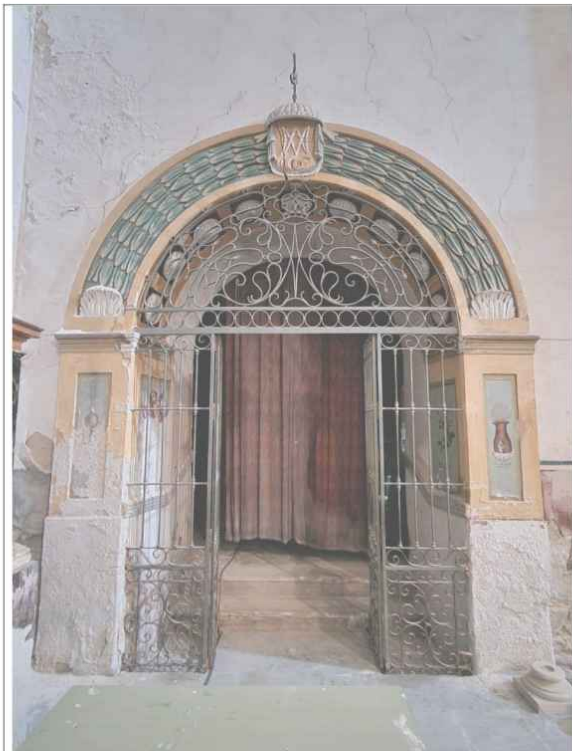
Pérdida de policromía en la portada de la Capilla de San Francisco de Paula, especialmente en la parte inferior, debido a la presencia de humedad por subida capilar.
