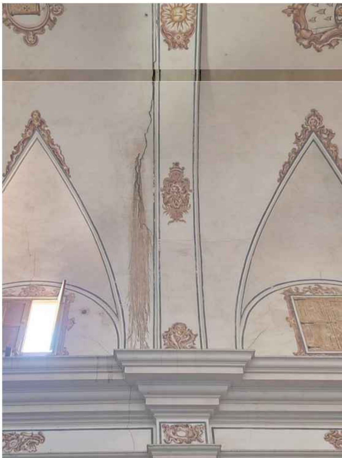
Vista de la bóveda, con la mancha de agua con barro, debido a la filtración de la lluvia por una gotera y una grieta
