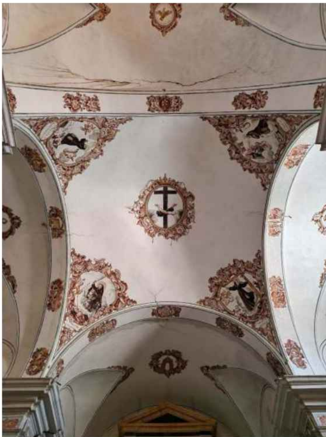
Vista de la cúpula del crucero, donde se observan las grietas en las claves de los cuatro arcos que la sujetan
