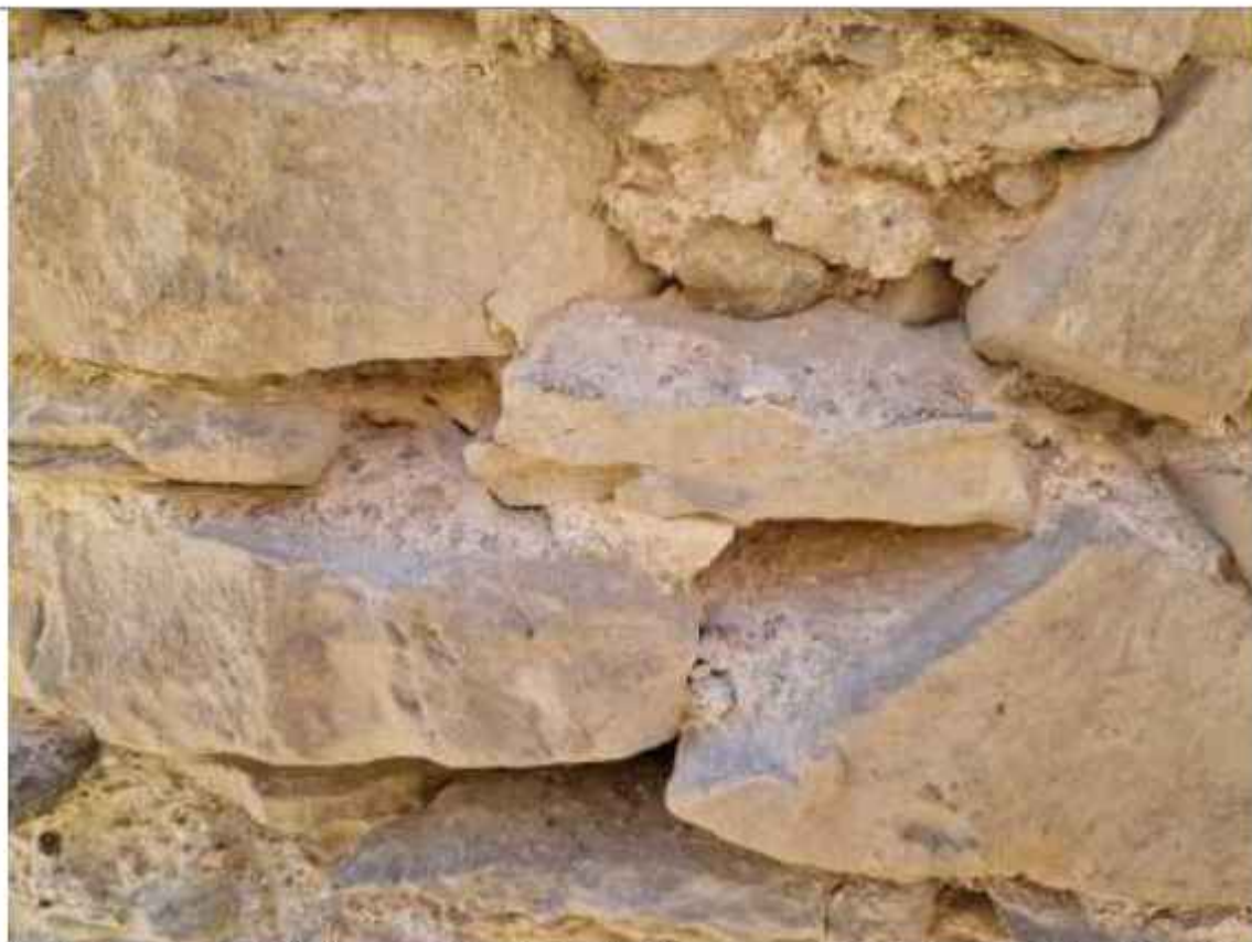
Detalle de mampostería, donde se aprecia la pulverización del mortero, erosionando juntas y debilitando la fábrica
