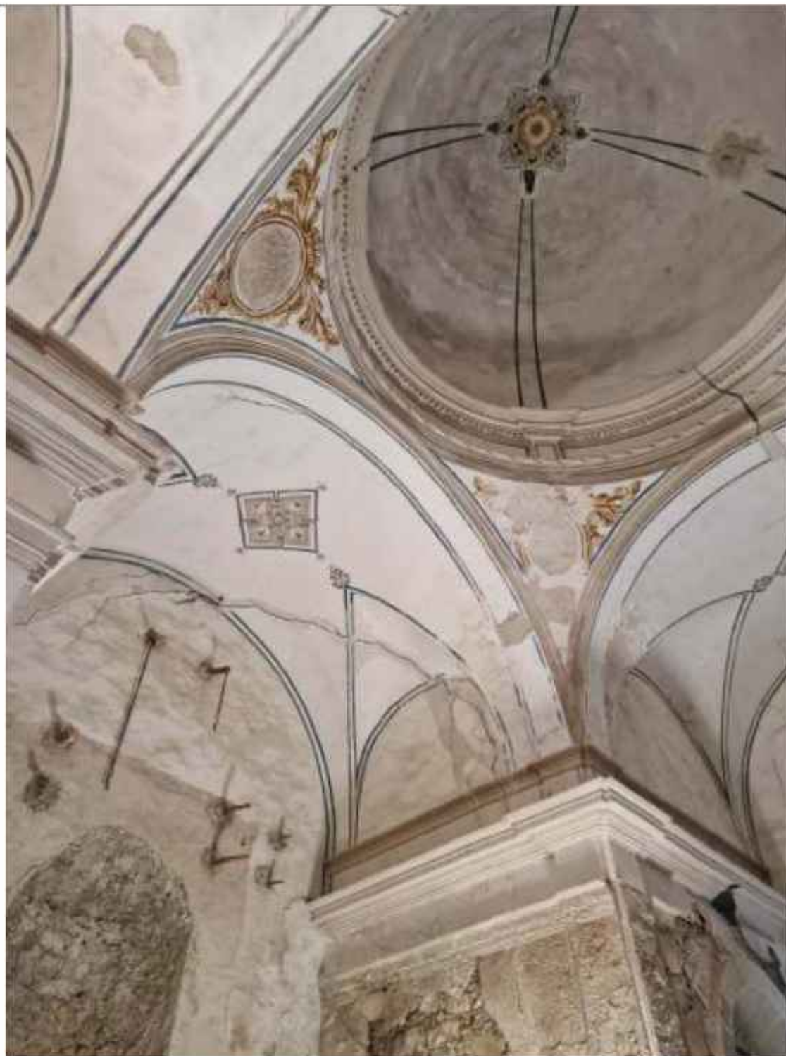
El presbiterio y la cúpula muestran la presencia de grietas preocupantes para la estabilidad del edificio
