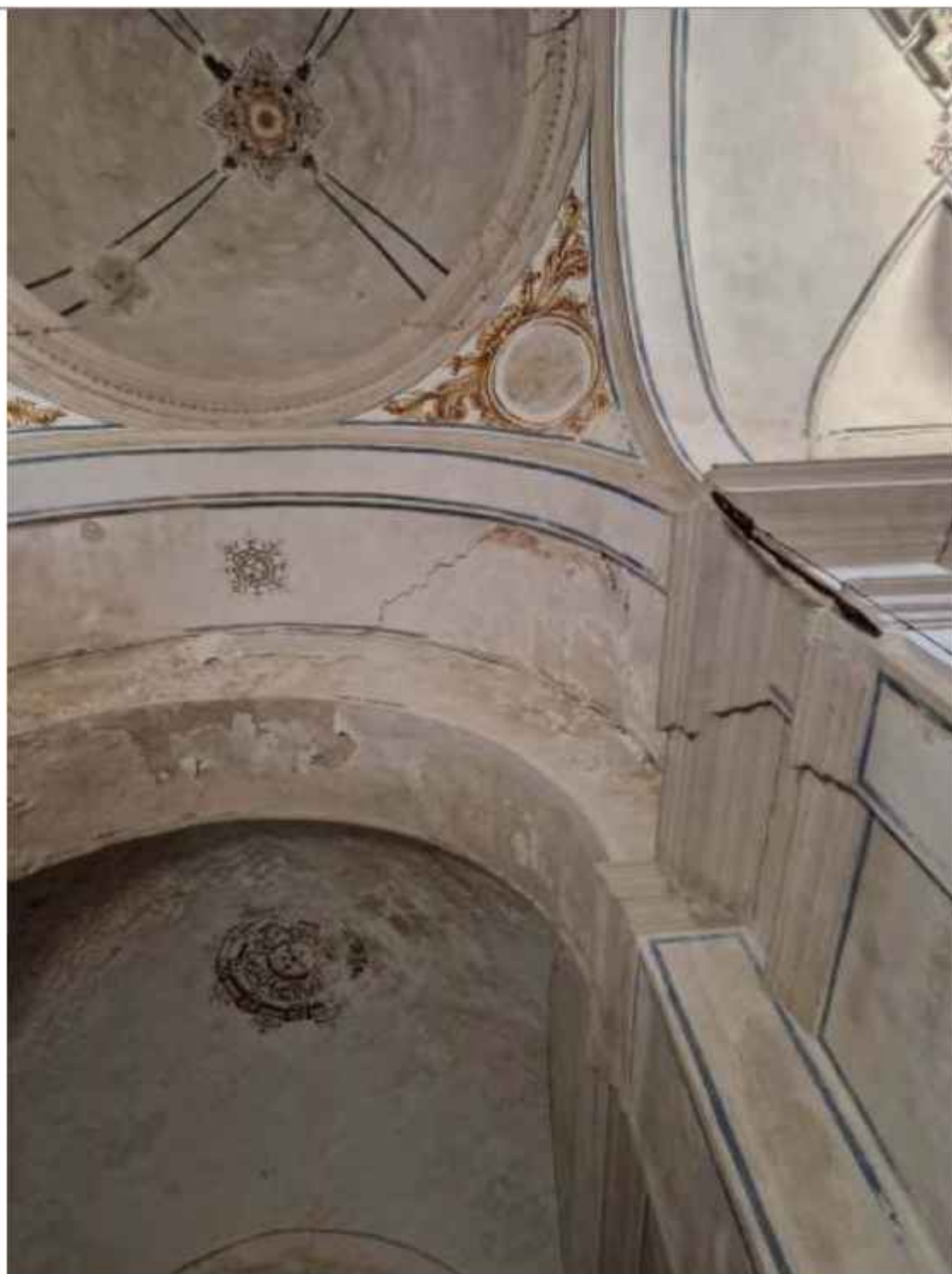
Grieta presente en el arco que separa el crucero con la capilla de acceso desde la nave principal
