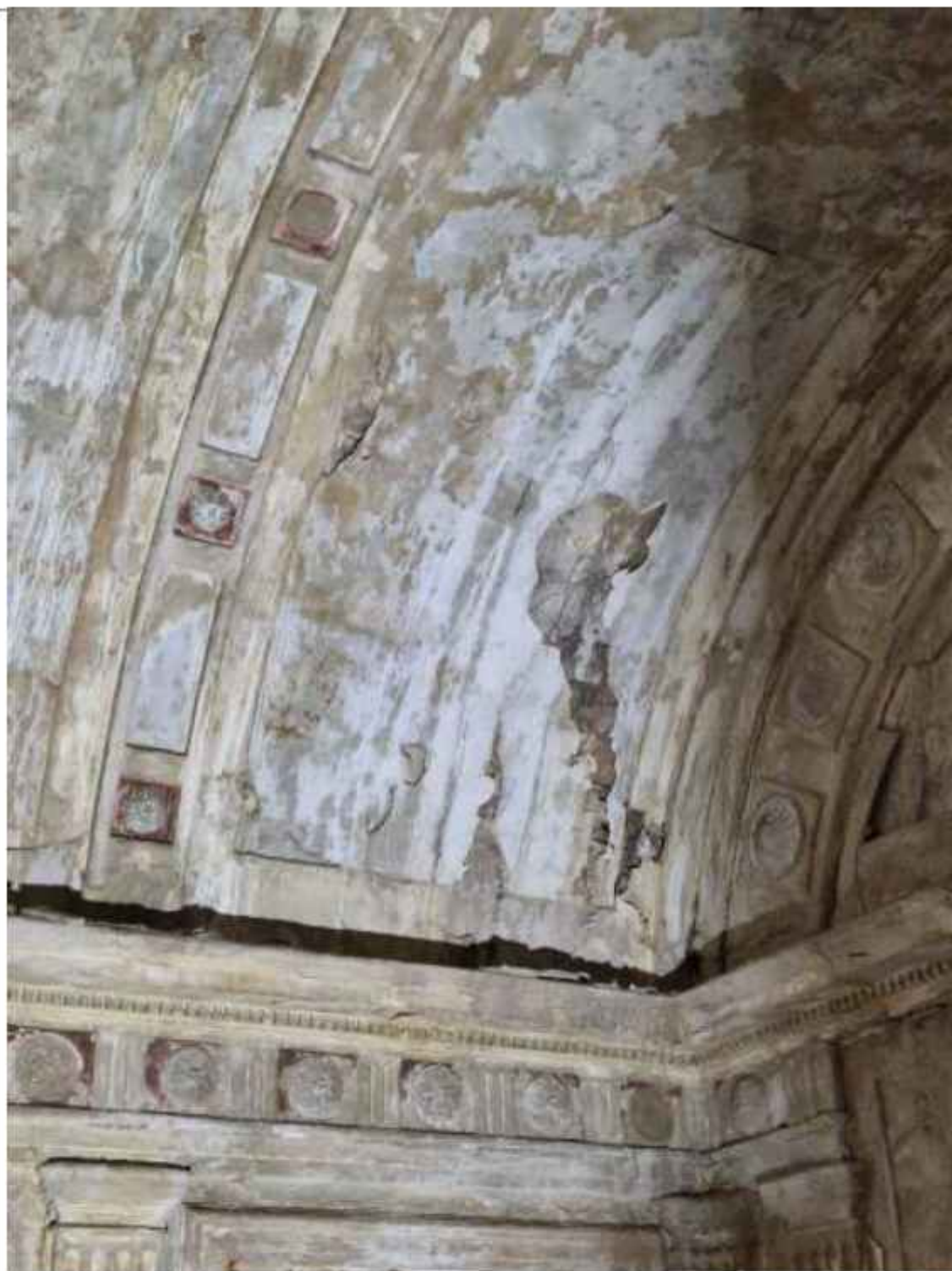
Detalle de la capilla de la Epístola, en el que se aprecian las raíces de la hiedra
