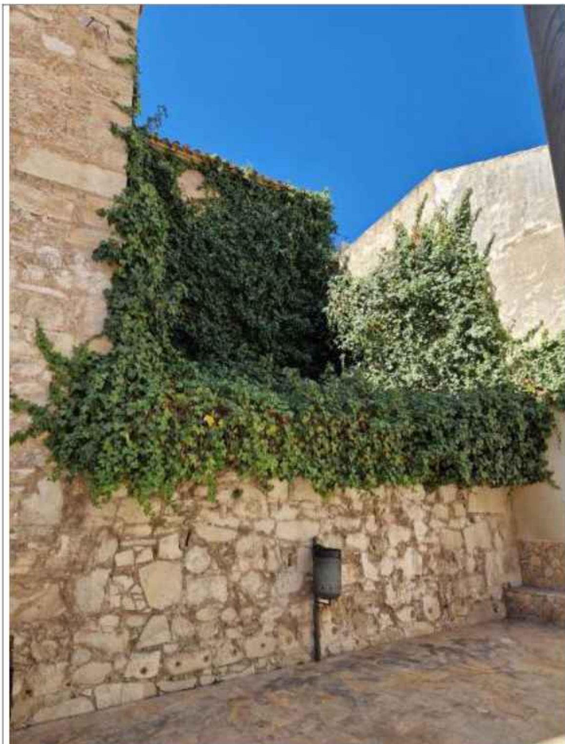
Hiedra en la cubierta de la Capilla de la Epístola, y los muros de la parte noroeste de la iglesia
