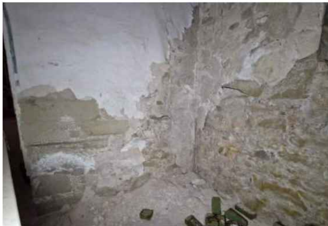
Vista de unan de las capillas laterales, con la masiva pérdida de enlucidos, especialmente en el muro de fachada
