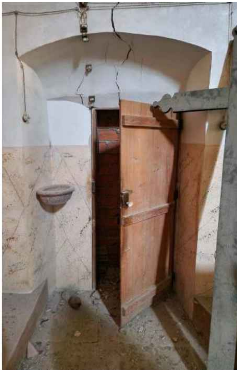
Fig. 104_Puerta de acceso al coro, situada en el muro sur de la nave. Vemos que se encuentra tapiada con un tabique de ladrillo hueco, correspondiente a la caja de escaleras del mercado municipal. A la izquierda, vemos una pila destinada a recibir agua bendita.
