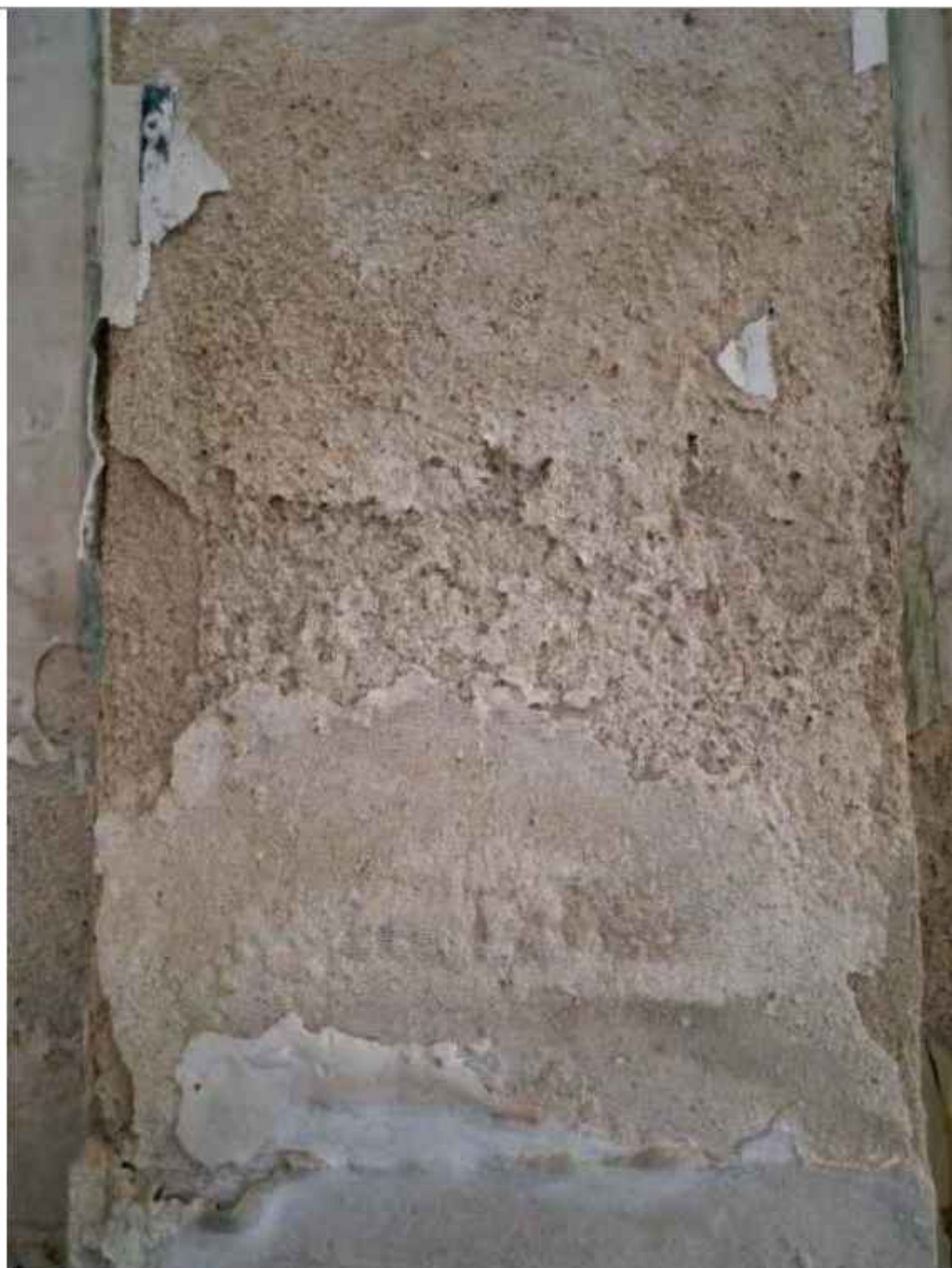
Detalle de un enlucido, donde se ve el escamado de las capas, la presencia de sales, pero también la alveolización y la disgregación del material, hasta que finalmente se pulverice
