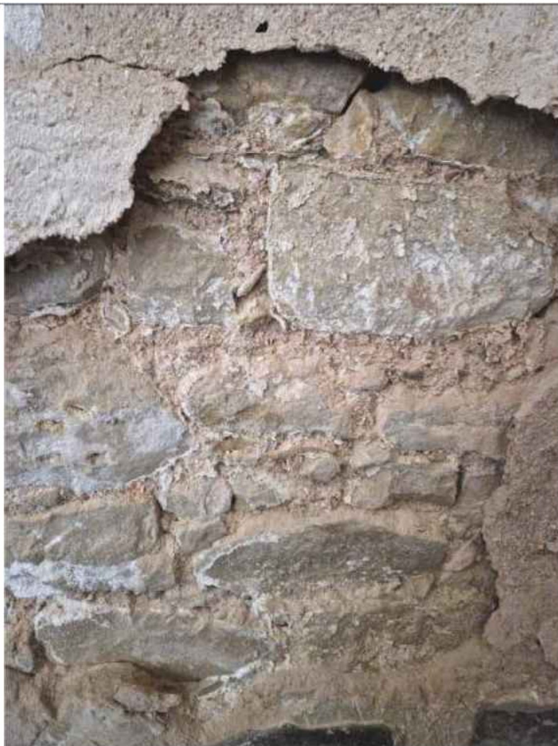
Detalle de una zona con la fábrica desnuda, donde se ve la presencia de sales y disgregación de mortero
