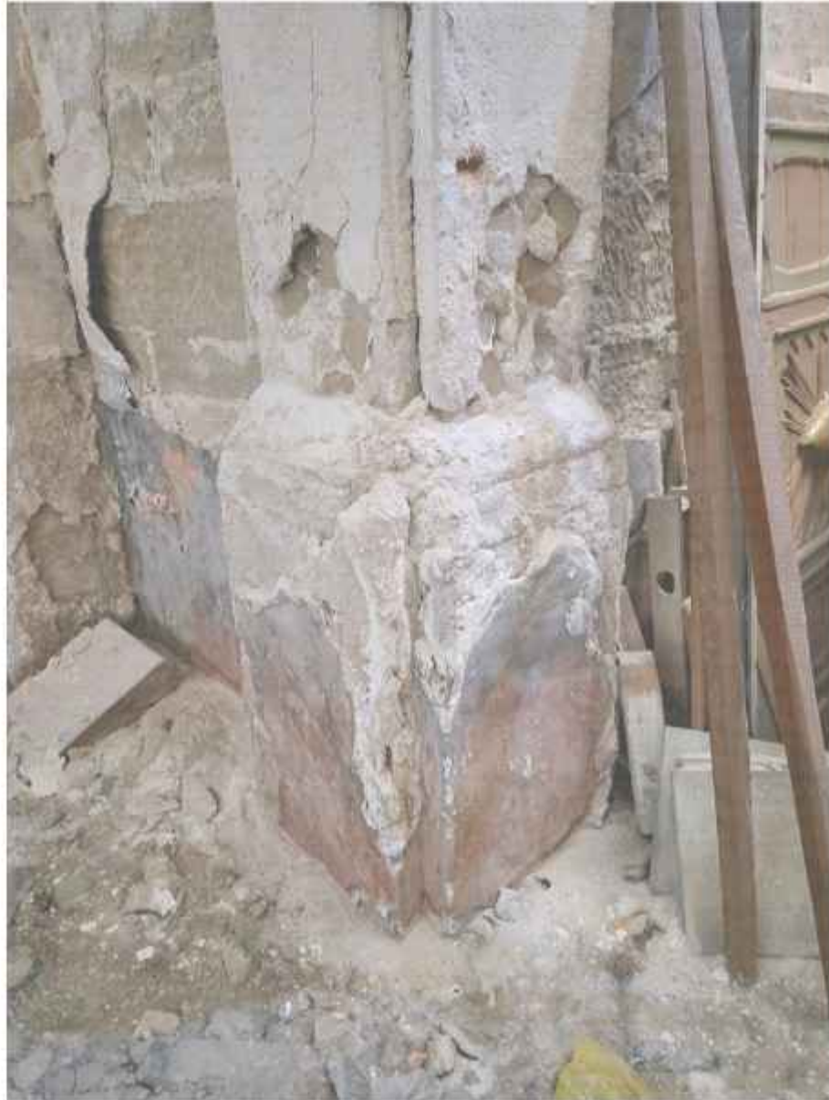
Fig. 61_Restos de zócalo en uno de los pilares de la Capilla de San José. Se aprecian las concreciones de sales, y la disgregación del mortero.
