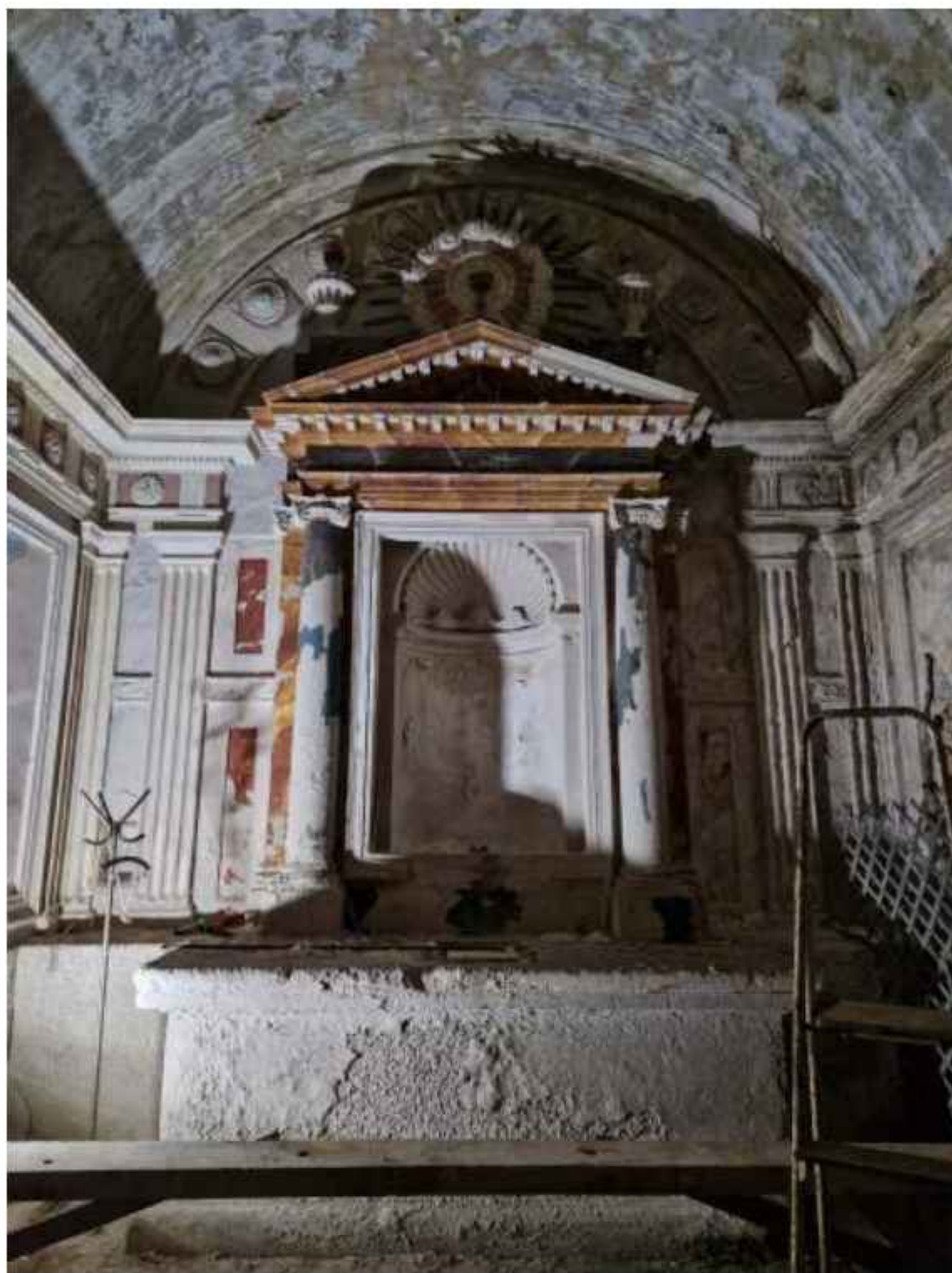
Vista del altar principal de la capilla, construido en yeso policromado. Se ve la afección de la humedad en la mesa, cuyo enlucido está alveolizado y en proceso de pulverización
