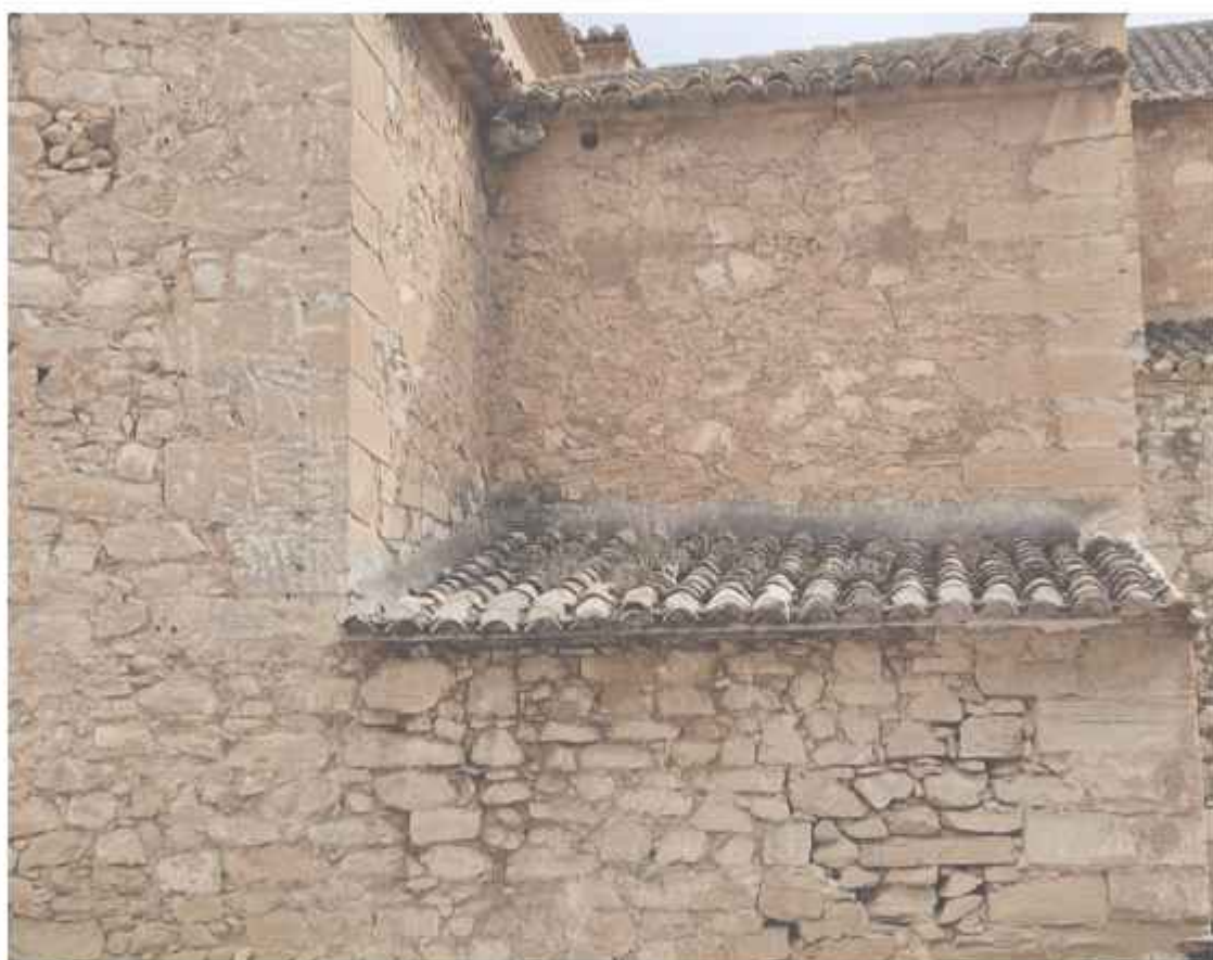
Vista de una de las cubiertas de la Capilla de San José, colonizada por plantas y musgo
