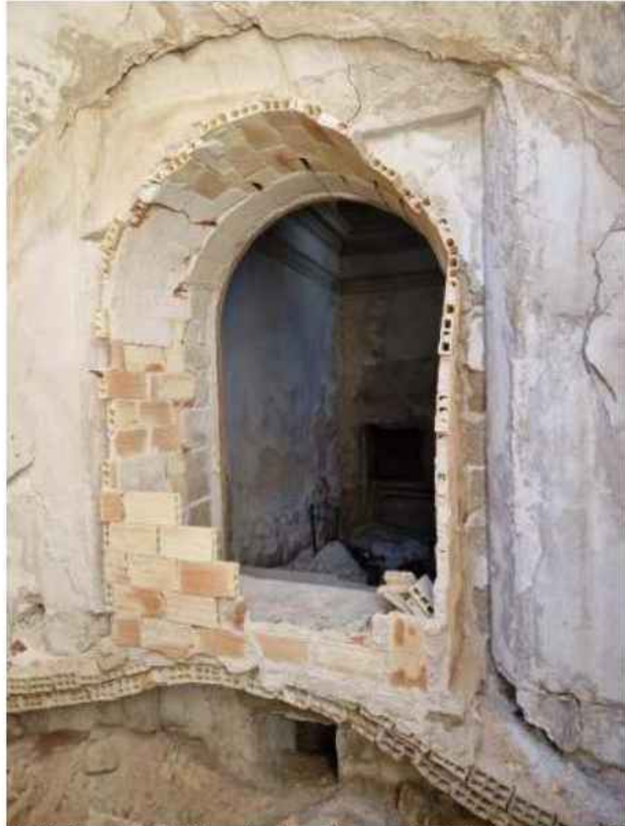
Fig. 122_Parte trasera del nicho realizado en el altar este, vista desde el espacio trasero. En esta imagen se observa, además del arco de ladrillos construido para soportar el nuevo nicho, que vemos haber sido ejecutado como un simple tabicado, la huella de un antiguo recuadre con aristas, cuya función desconocemos. Asimismo podemos ver, en la parte inferior, el paso de reducidas dimensiones que da acceso al volumen interior de la mesa del altar. No sabemos cuál es la función de esta configuración, ni la cronología de la misma.
