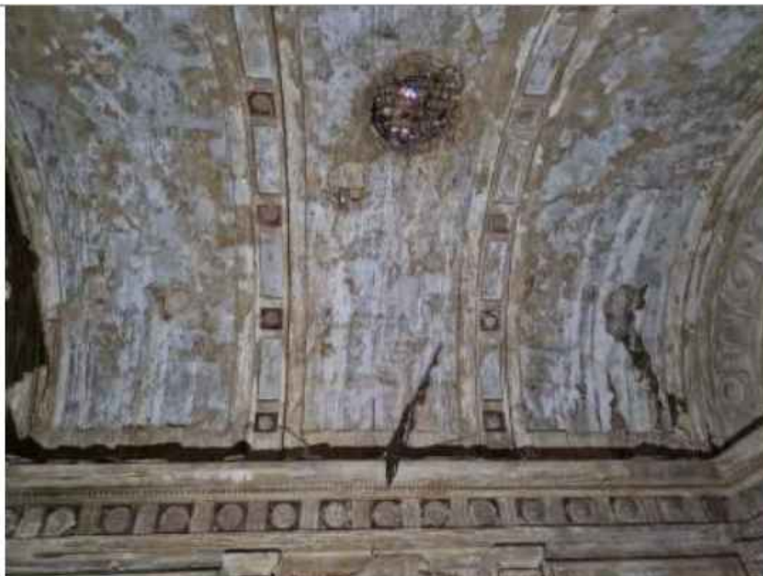
Bóveda de la capilla, con el oculus en el centro. Se aprecia el deterioro debido a las filtraciones y la vegetación
