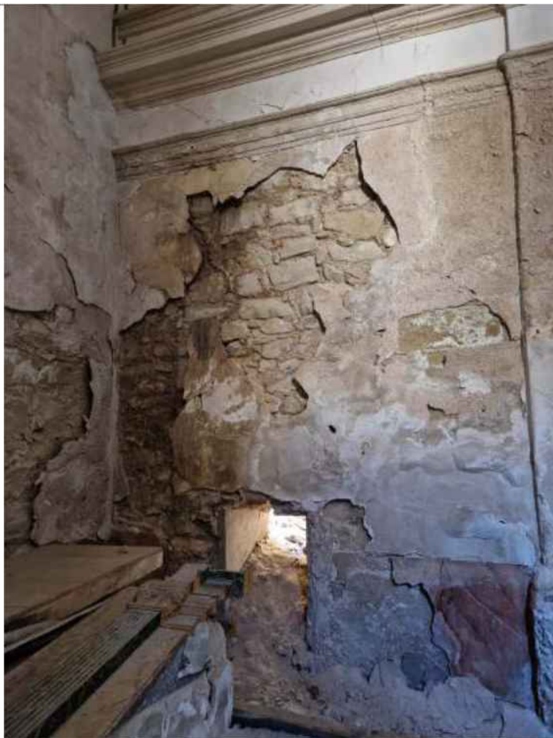
Detalle de un muro del presbiterio de la Capilla de San José. El enlucido se encuentra extremadamente afectado
