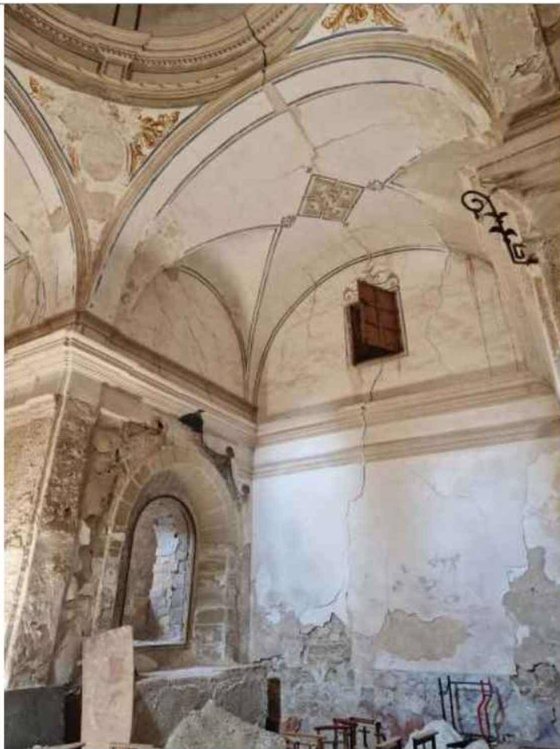
Presencia de una grieta vertical importante en el centro del muro de la capilla, pasando por la ventana del mismo
