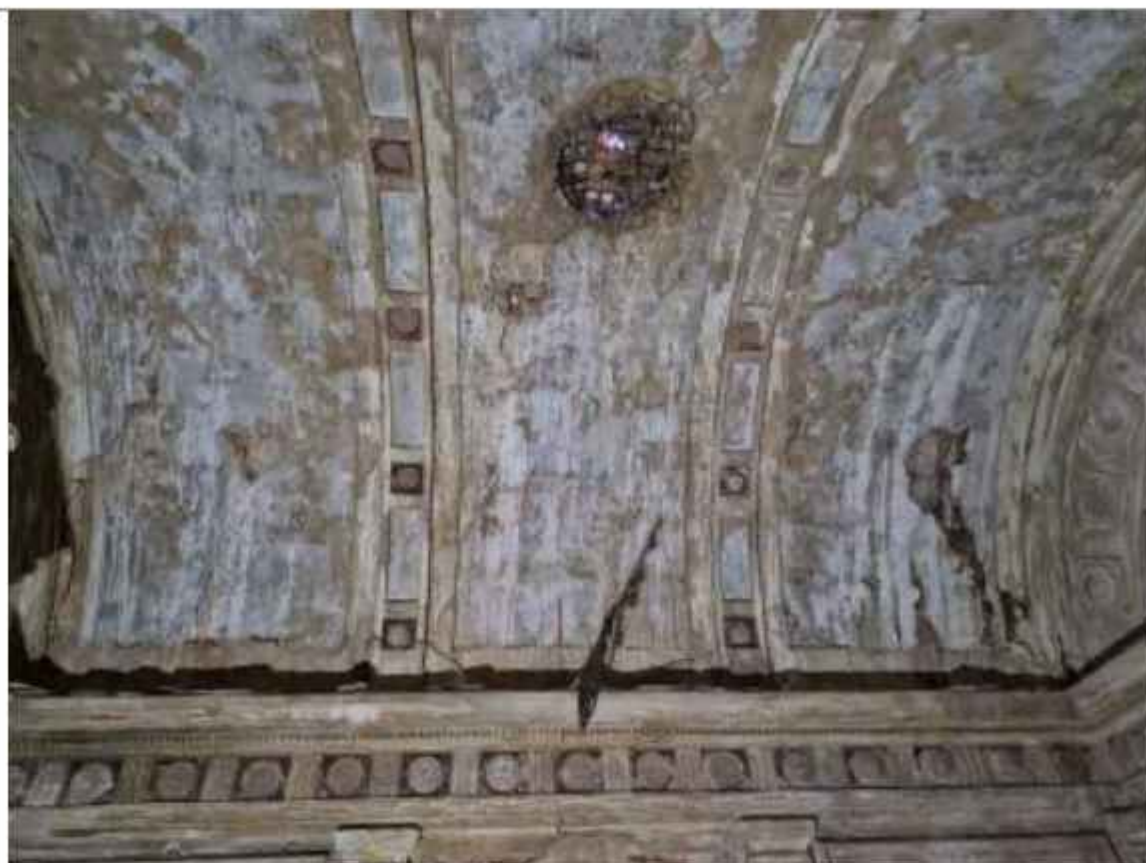
Vista de general de la bóveda, que muestra la afección generalizada por culpa de la humedad generada por la hiedra
