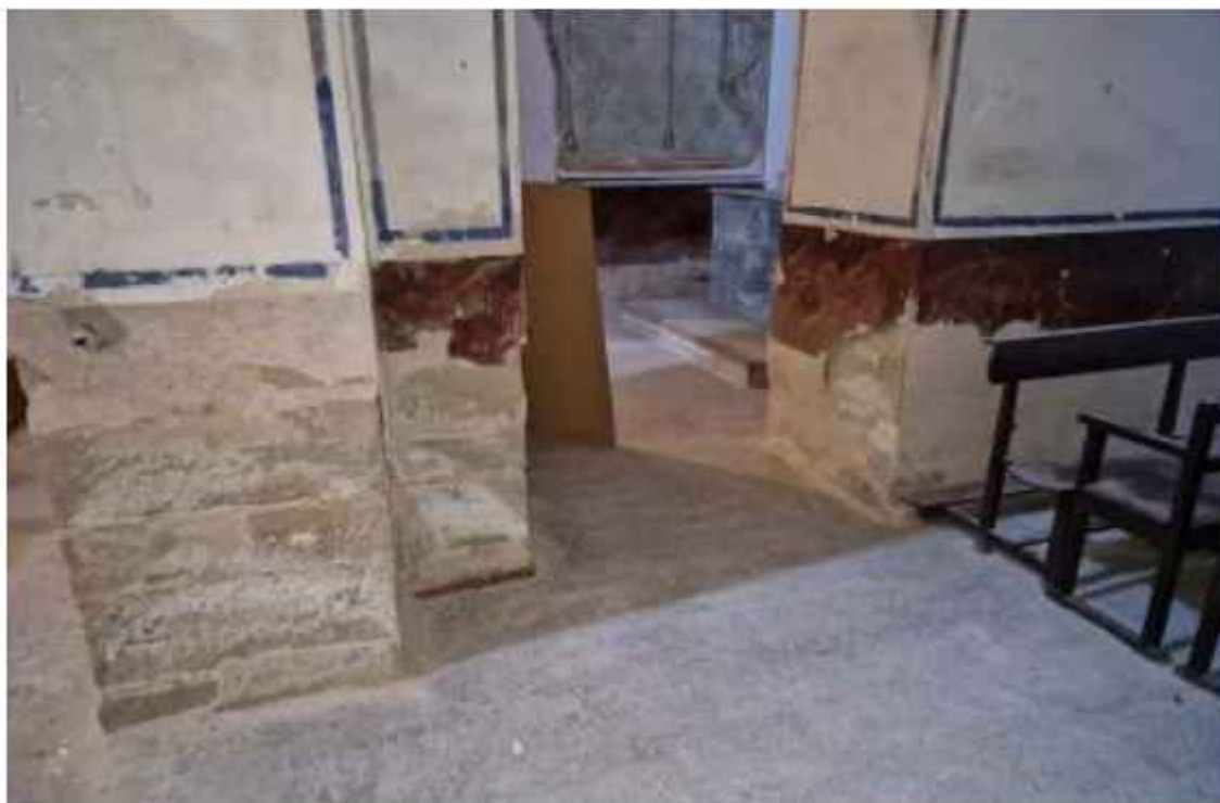
Vista de la parte inferior de pilares y muros en una de las capillas laterales, con la presencia de sales y humedad
