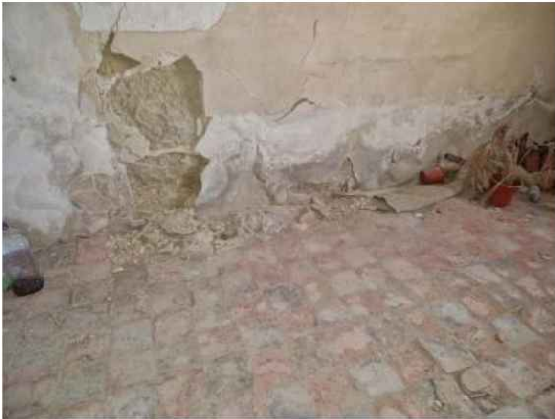
Vista del pavimento de la sacristía, cuyas baldosas se encuentran muy deterioradas, incluso disgregadas
