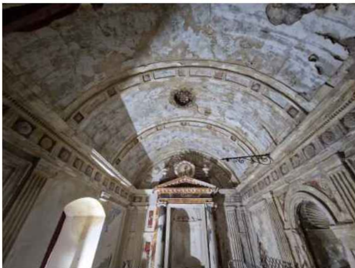
Vista general de la capilla, donde se aprecia la extrema presencia de humedad en todo el conjunto
