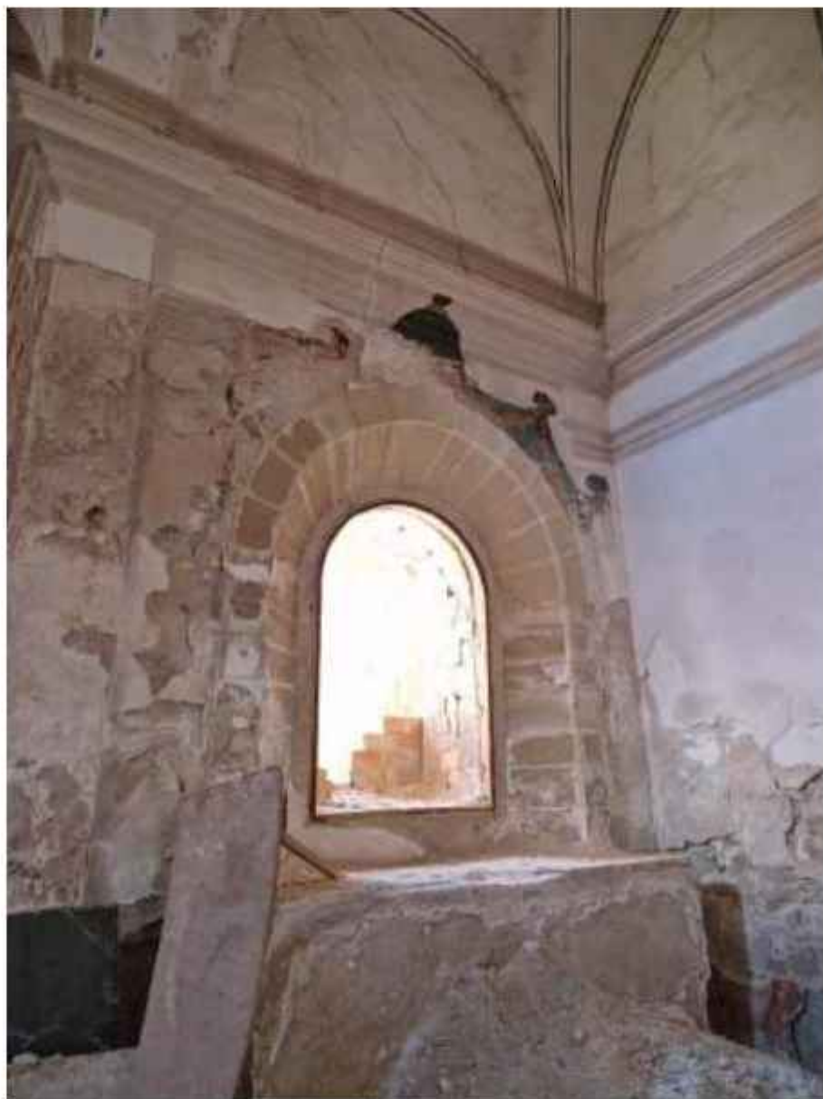
Fig. 121_Vista del altar este, en la que apreciamos la perforación del muro para crear un nicho, realizado en ladrillos huecos. La mesa del altar no muestra ninguna señal de estar hueca
