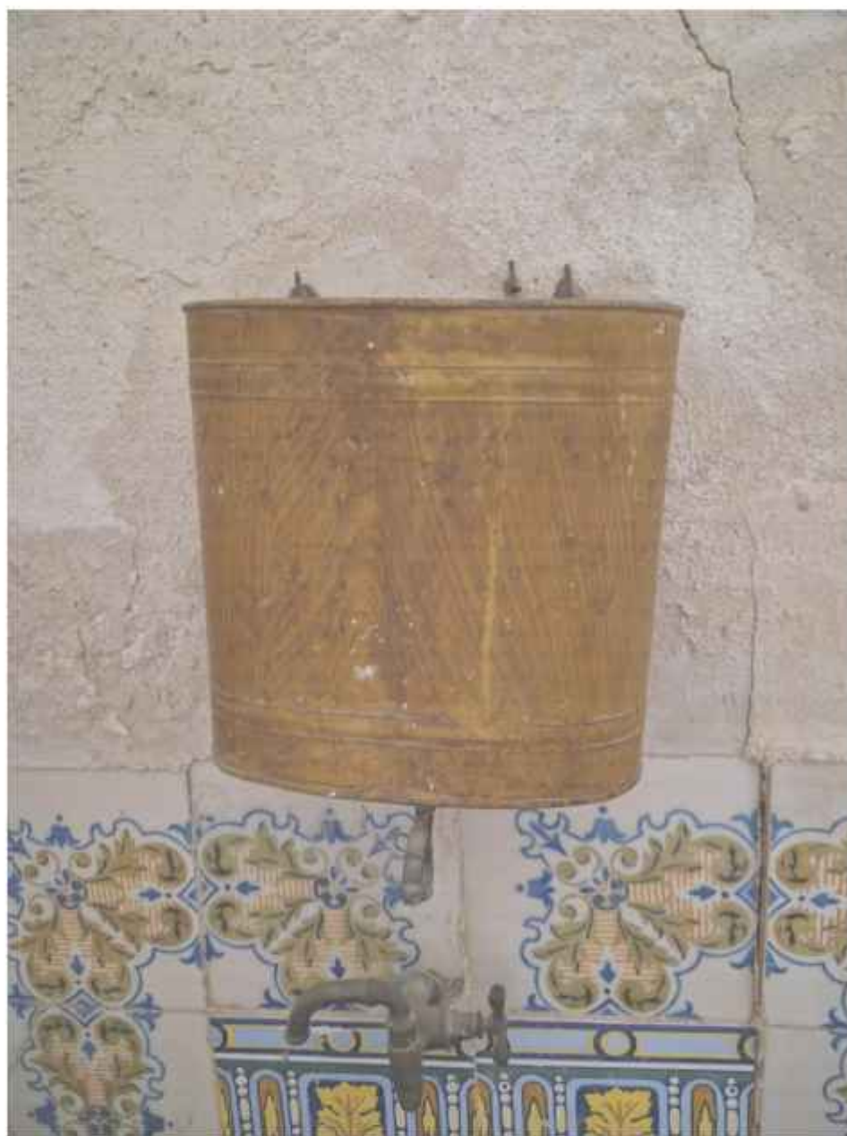
Fig. 195_Detalle de la cisterna encima de la pila, decorada con una pintura que simula madera. Vemos también el grifo de pared, y los azulejos que protegen el muro
