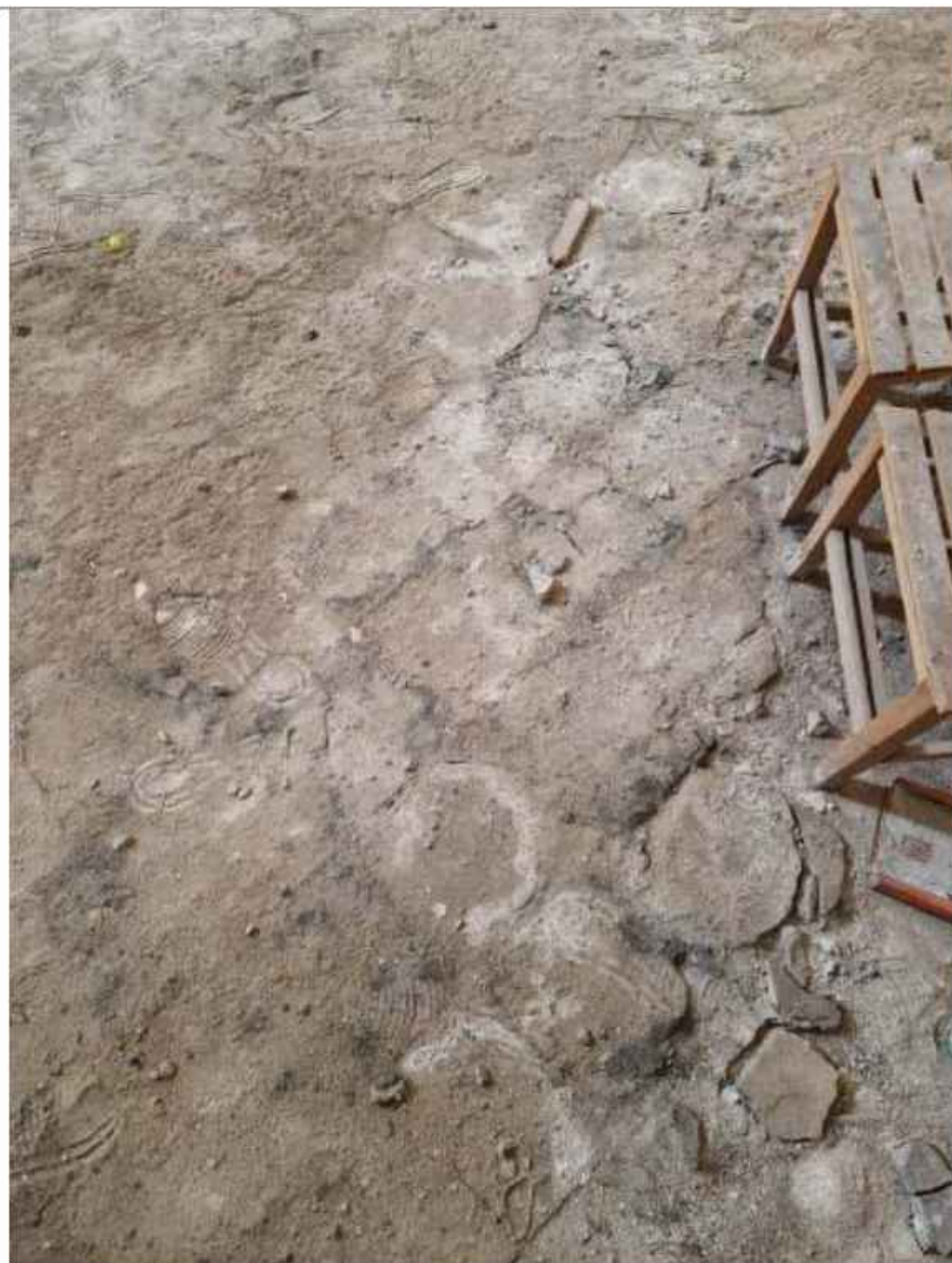
Detalle del pavimento de la Capilla de San José, donde se ven las baldosas totalmente disgregadas. El material se ha pulverizado, de tal manera que ni siquiera se consigue apreciar donde termina la zona de baldosas
