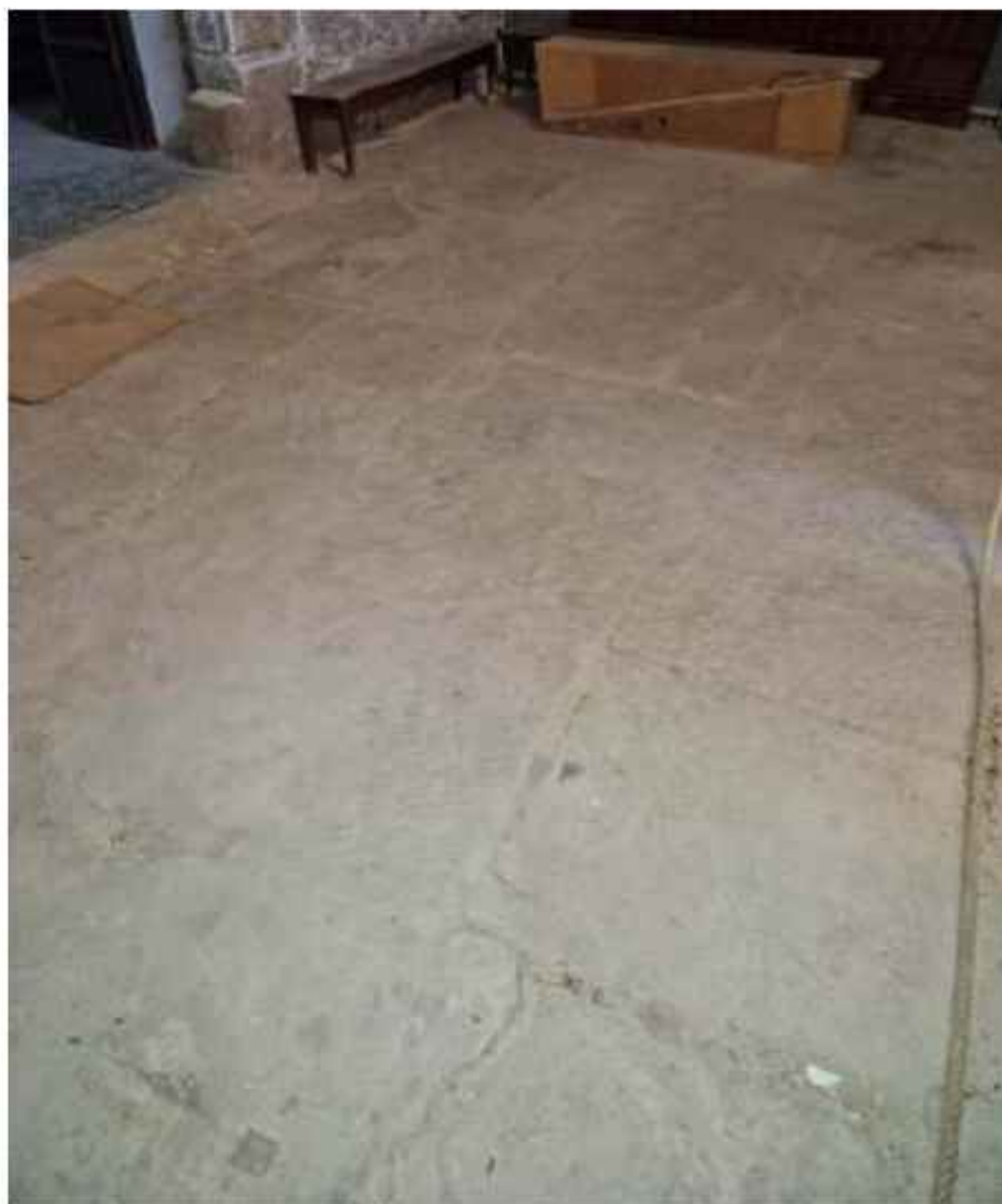
Fig. 125_ Pavimento original compuesto de grandes losas de piedra caliza
