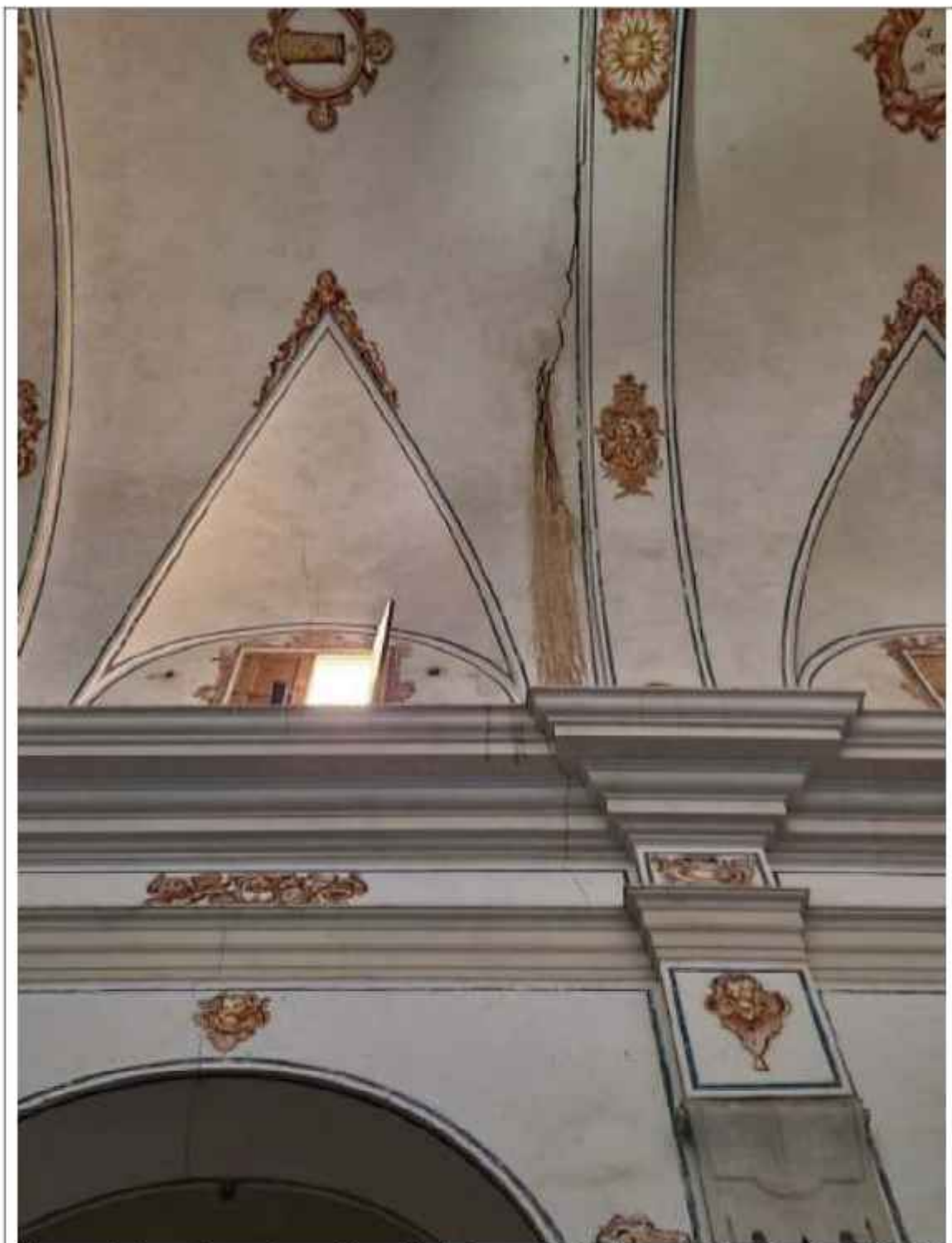
Grietas verticales en el centro de una de las crujeas de la nave central, así como en el lateral derecho, siguiendo la pilastra
