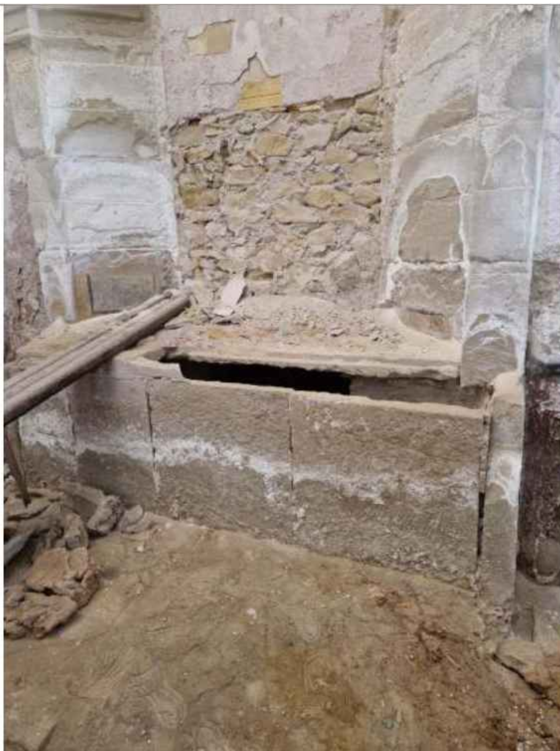
Vista del altar oeste de la Capilla de San José, afectado por subidas capilares, que provocan la disgregación del material, especialmente del mortero, así como la presencia de eflorescencias salinas. En este caso, vemos que se marca una línea clara, como si se tratase de la altura máxima a la que sube la humedad
