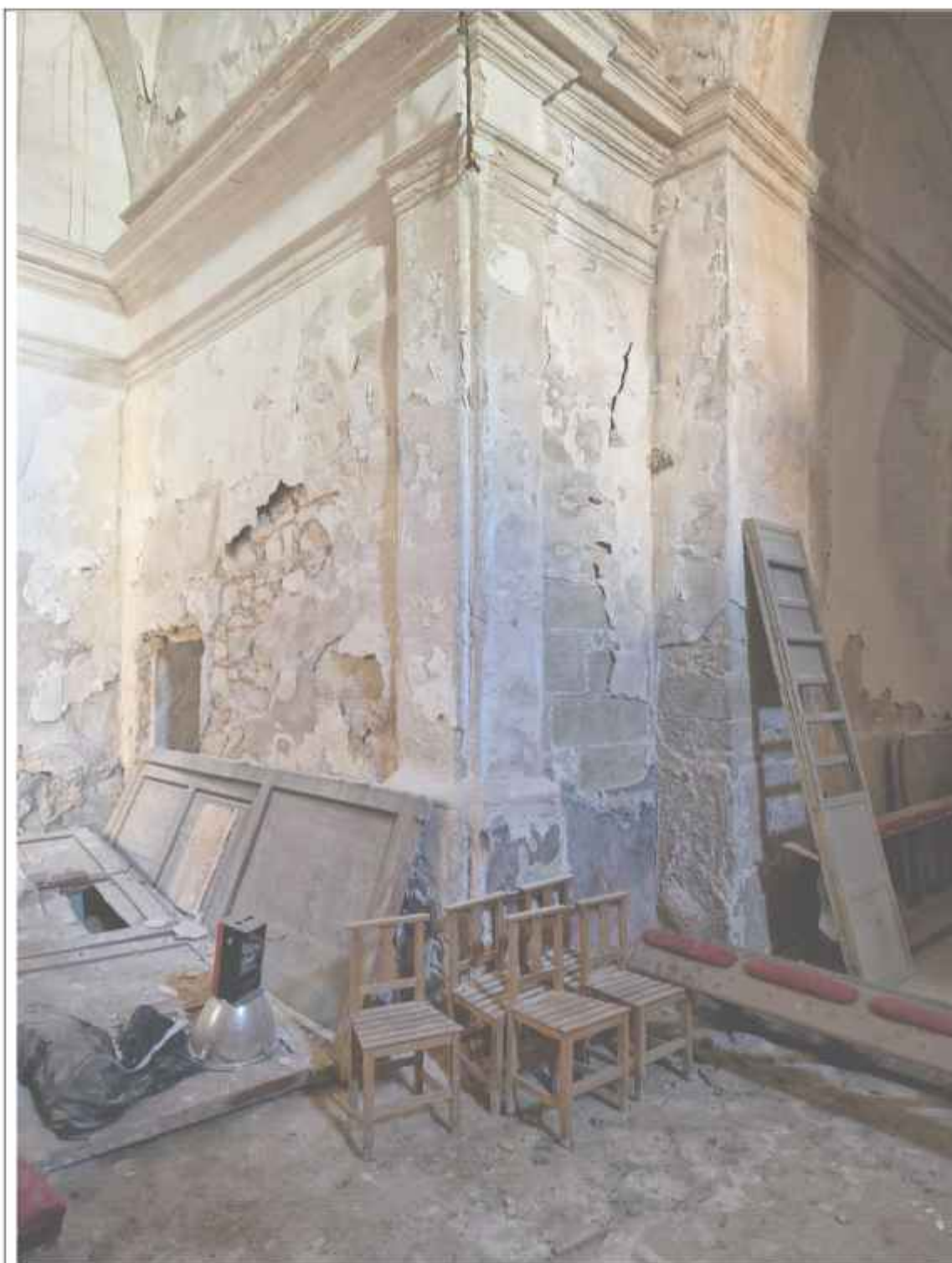
Vista de la Capilla de San José, con la pérdida de los enlucidos en la parte baja de los muros
