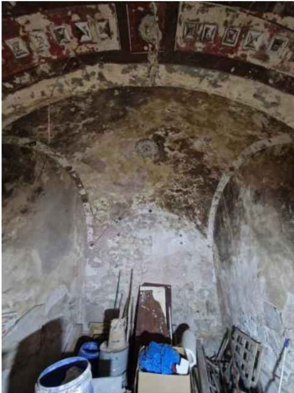
Vista de general de la sala, con la presencia de humedad y de microorganismos en todo el conjunto de paramentos, tanto en bóveda como en paredes
