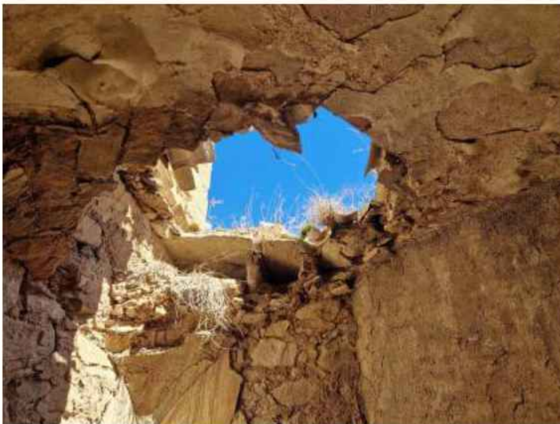
Imagen del agujero en la cubierta del espacio trasero del altar lateral este
