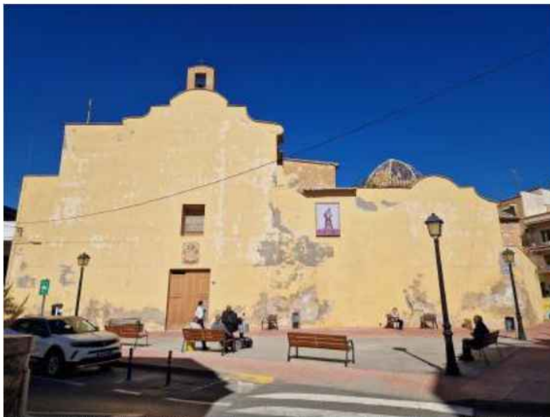
Vista general de la fachada principal. Se ven varias zonas muy afectadas por la humedad, con pérdida de policromía, presencia de eflorescencias salinas, fracturación de enlucido, erosión, e incluso abombamientos.
