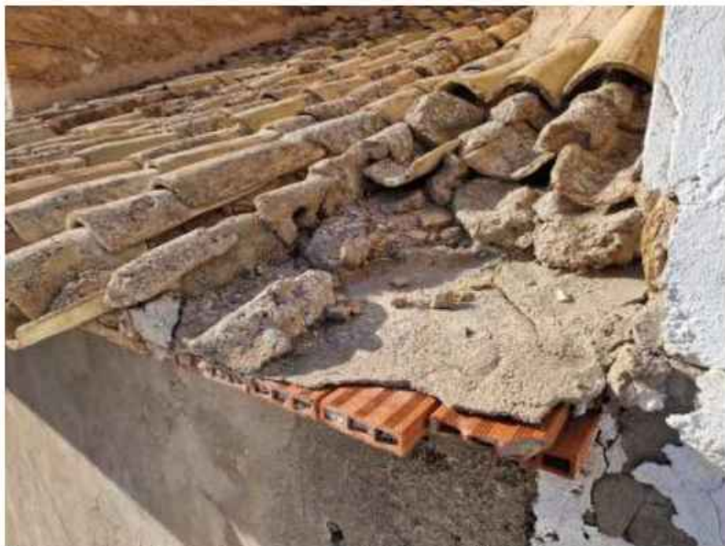
Detalle una cubierta del colateral sur, con un trozo faltante. Se ve la utilización de mortero de cemento
