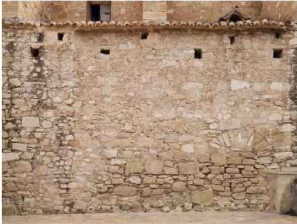
Fig. 11_Mampostería visible en uno de los muros de la iglesia
