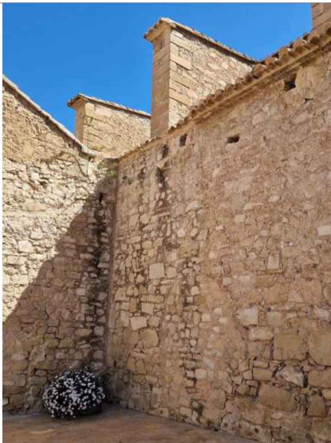
Vista de la esquina entre la fachada lateral de la Capilla de San José y la fachada norte de la iglesia, con la presencia de una planta que ha crecido en el canalón de evacuación del agua de lluvia, y el musgo y microorganismos que ha crecido en la zona húmeda que corresponde a la caída de agua desde la gárgola
