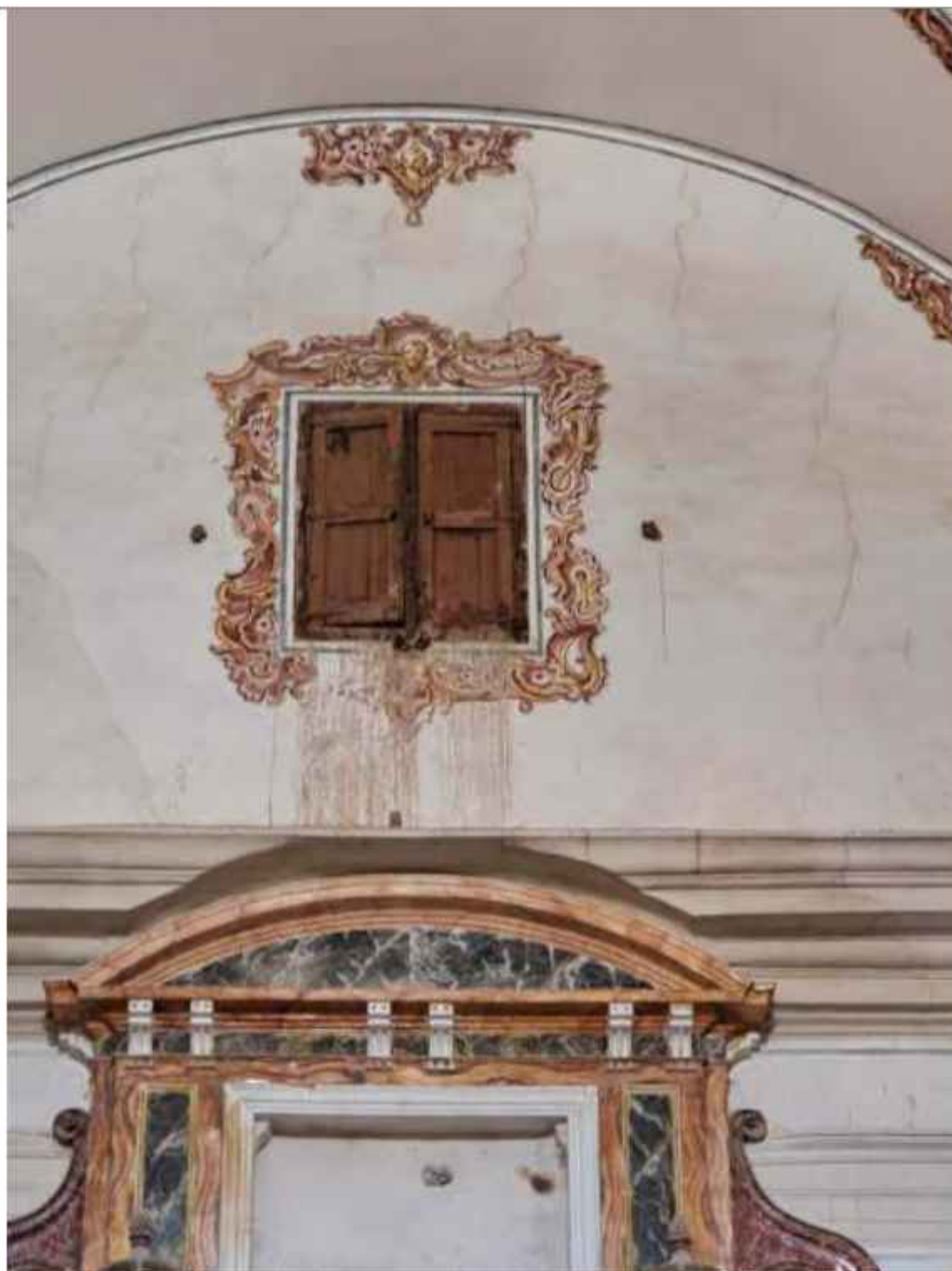
Ventana de la parte superior del brazo sur del transepto, con la deterioro de la policromía por filtraciones
