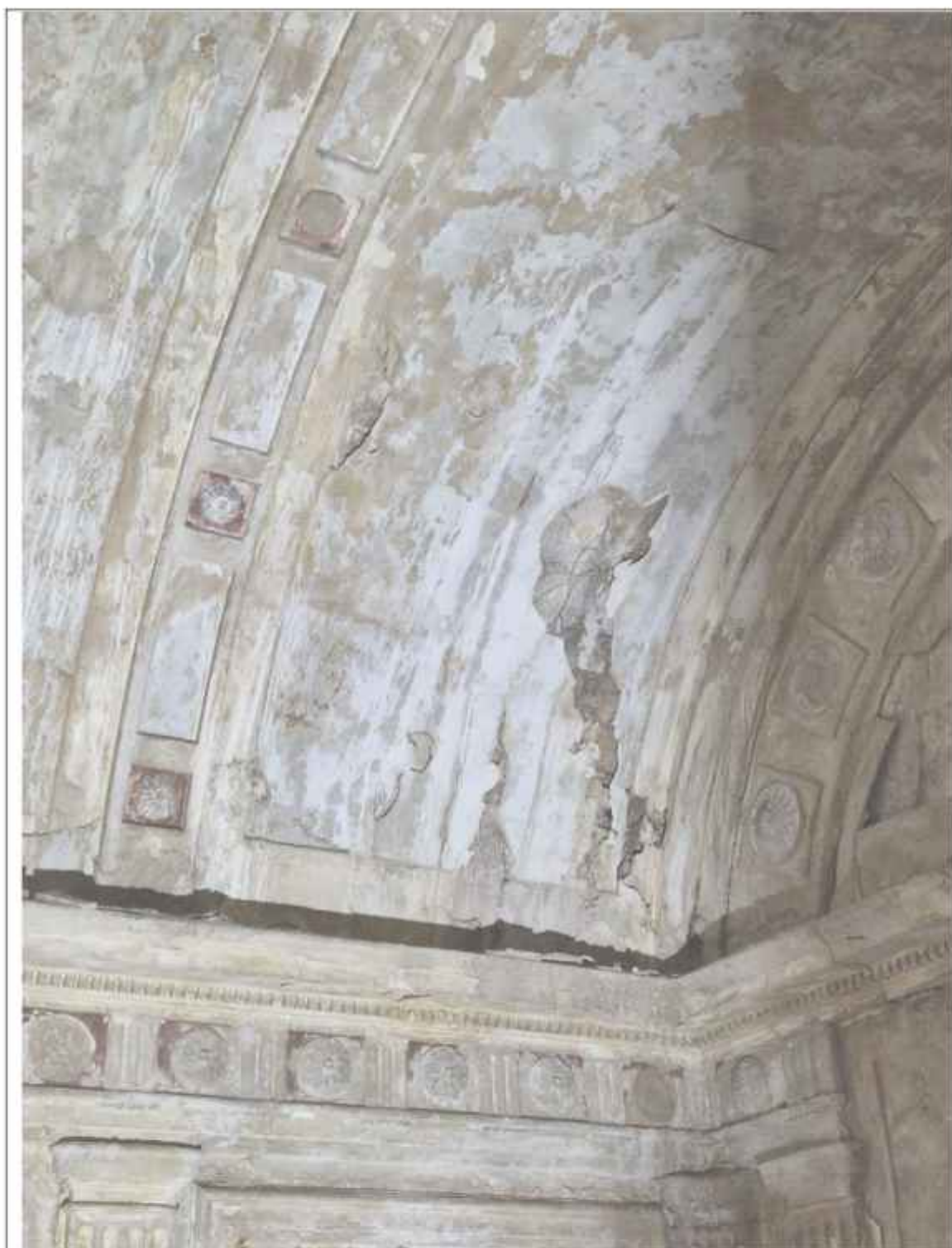
Detalle de la bóveda, donde se aprecia el deterioro de enlucidos y decoraciones, y la presencia de hongos y raíces
