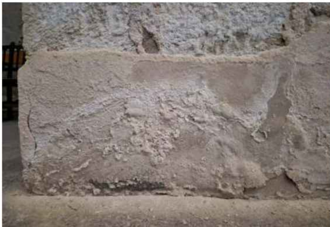
Detalle de un zócalo, con concreciones salinas, disgregación de enlucido, y pérdida de material
