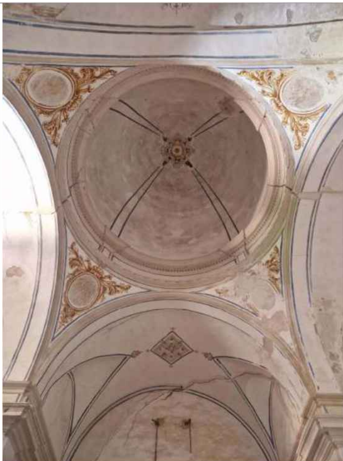
Vista general de las grietas del presbiterio y de la cúpula
