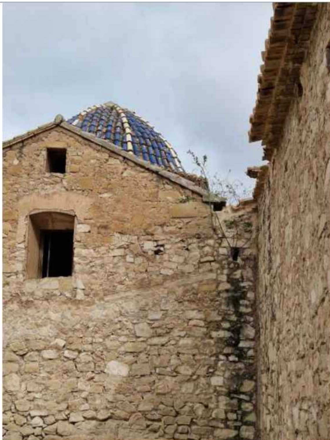
Vista de la fachada lateral de la Capilla de San José, con la presencia de una planta que ha crecido en el canalón de evacuación del agua de lluvia, y el musgo y microorganismos que han crecido en la zona húmeda que corresponde a la caída de agua desde la gárgola
