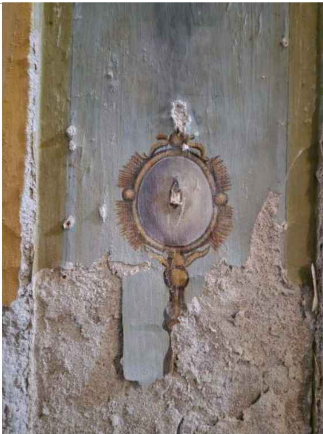
Detalle de una pintura, con la pérdida de policromía por desprendimiento del enlucido y presencia de sales.
