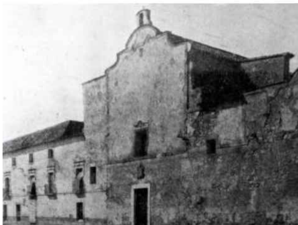
Fig. 198_Vista de la fachada de la iglesia y del convento, donde se ve la mampostería original, al faltar parte del enlucido (Fuente: Marcial Peñata)
