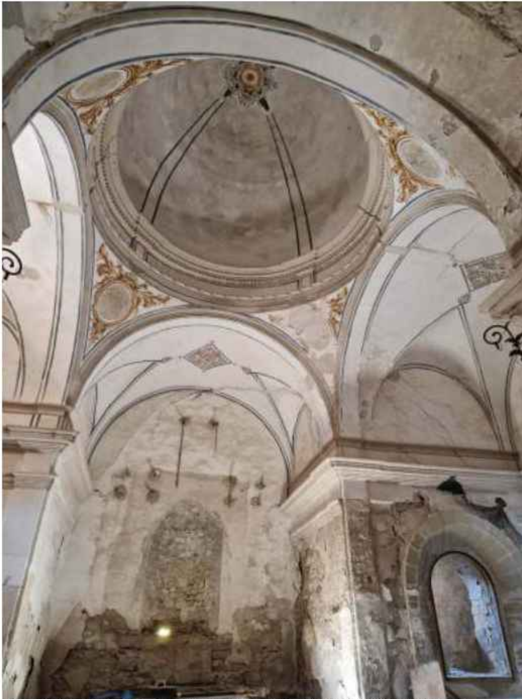
Presencia de numerosas grietas en todo el conjunto de la estructura de la Capilla de San José
