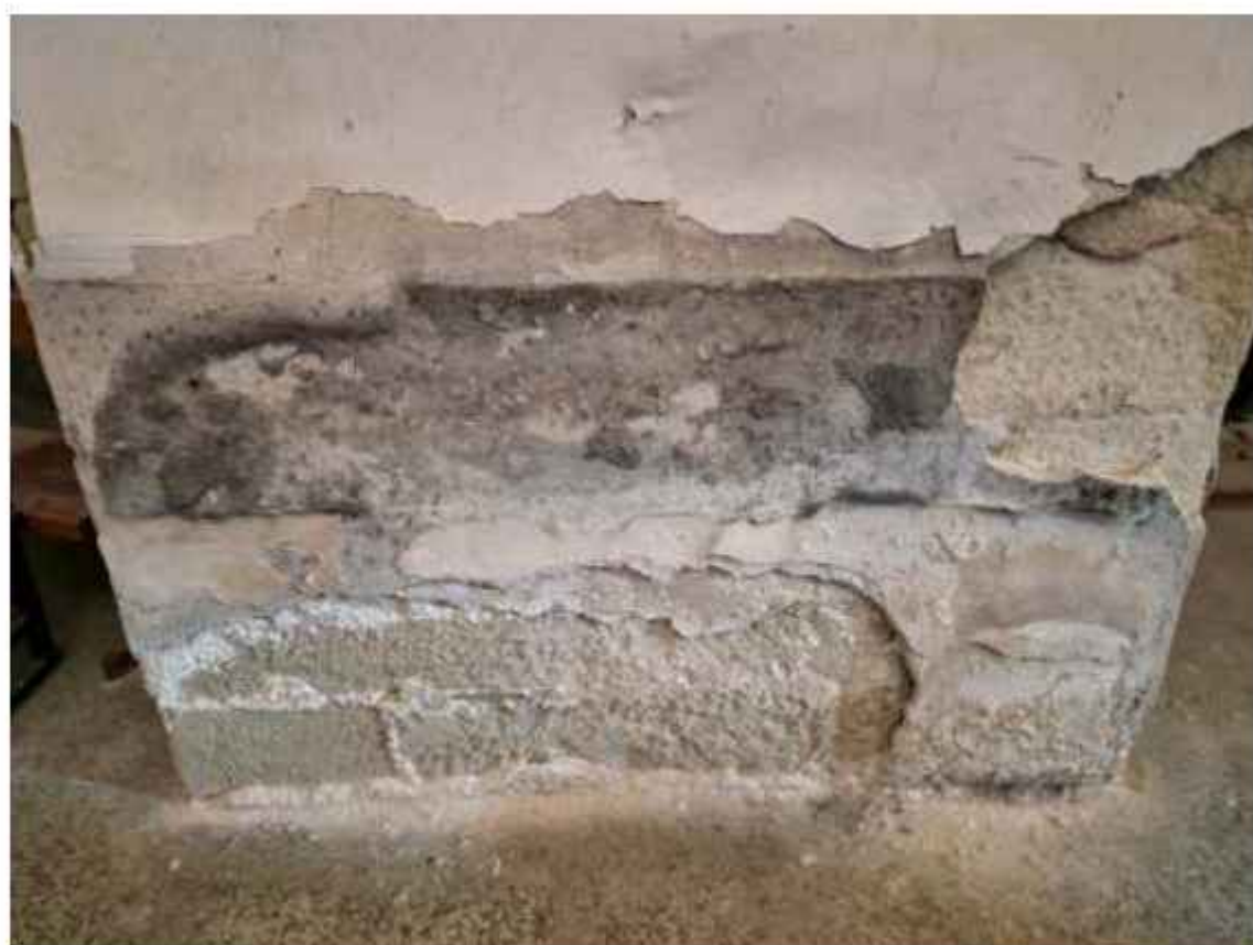
Vistas de dos zócalos, con concreciones salinas, disgregación de enlucido, y pérdida de material
