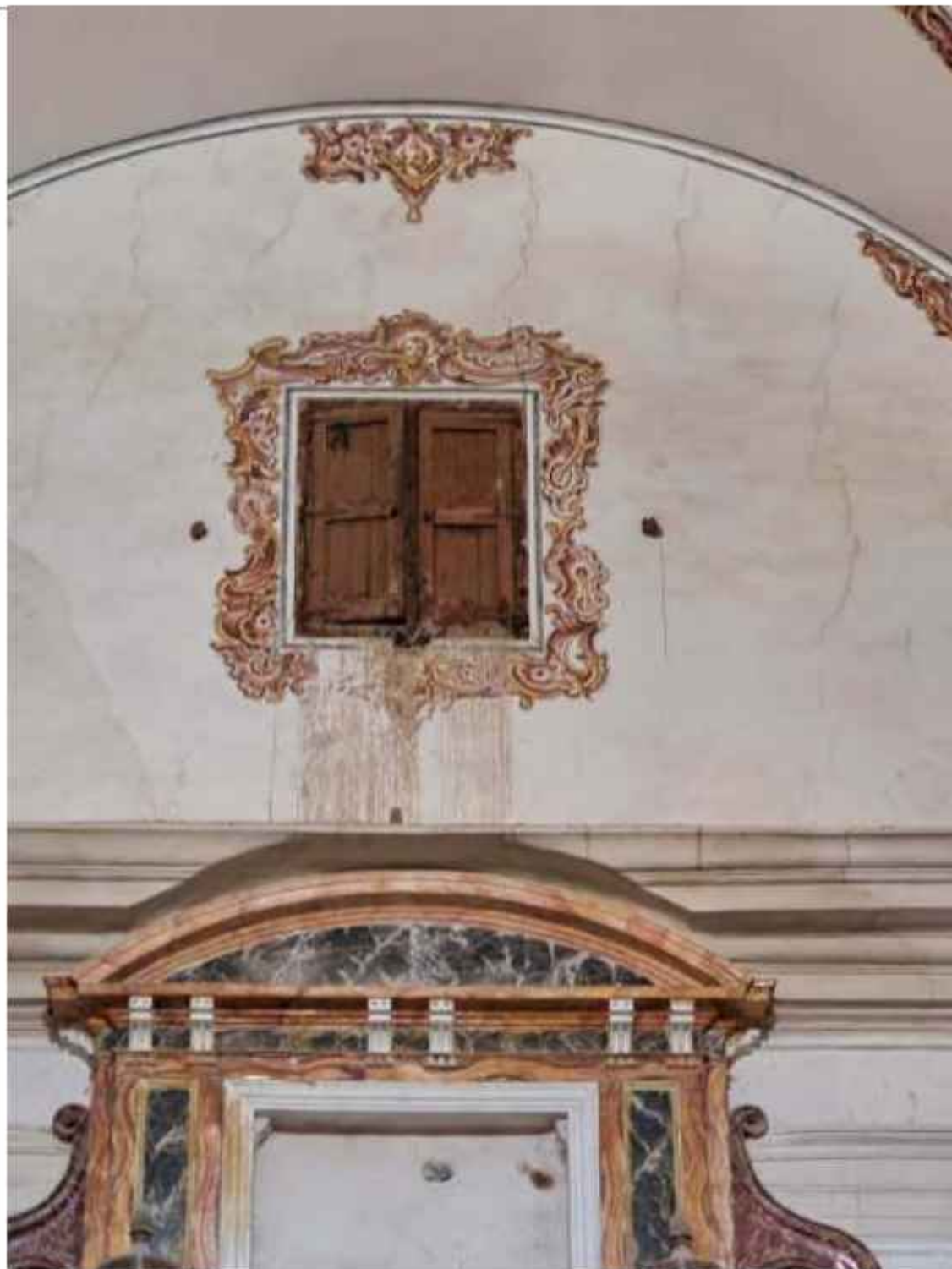
Vista de la ventana superior situada en el brazo sur del crucero, con filtración de agua de lluvia por una falta de estanqueidad de la carpintería. La ventana ha perdido las hojas acristaladas exteriores
