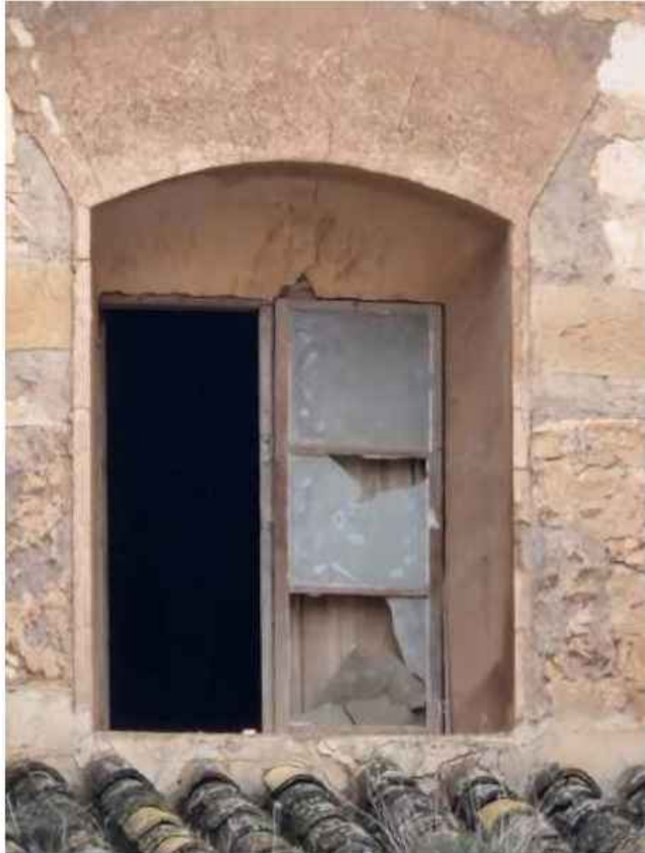
Fig. 97_Detalle de las hojas exteriores de una de las ventanas de la nave principal, donde se ven los cristales rotos
