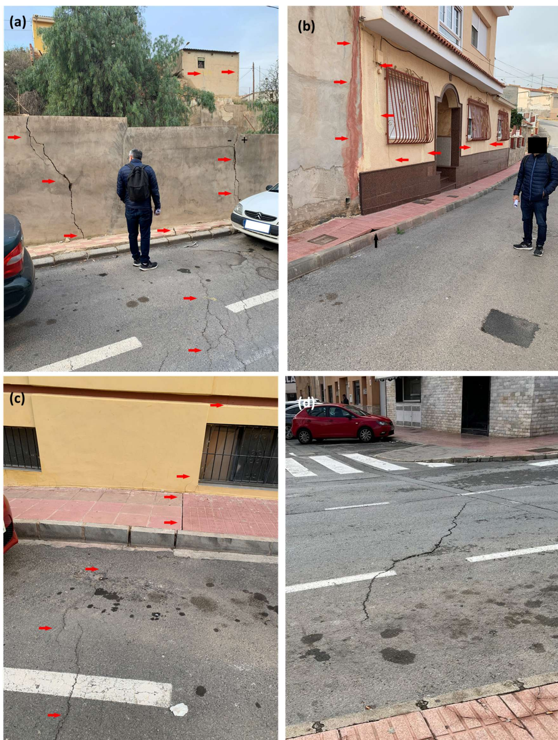
Figura 14. Grietas afectando a elementos constructivos: a) Grietas en firme y muro con elevada continuidad de la calle San Blas. b) Grietas (flechas rojas) en muro y fachada de vivienda, y levantamiento del pavimento de la acera por esfuerzos de compresión en la calle Raval Cuartel. Obsérvese también la deformación de las placas del zócalo de la vivienda. c) Aspecto de las grietas de la calle San Blas mostradas en la figura a) en el otro lado de la calle, con continuidad en la acera y el edificio. d) Grieta en el pavimento de la Calle Mayor a lo largo de la cual existen numerosas grietas adicionales paralelas y de orientación similar.
