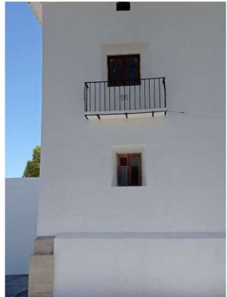
086. Acabado de fachada en el entorno de la balconera. Origen: finales, p. 1, imagen 3.
