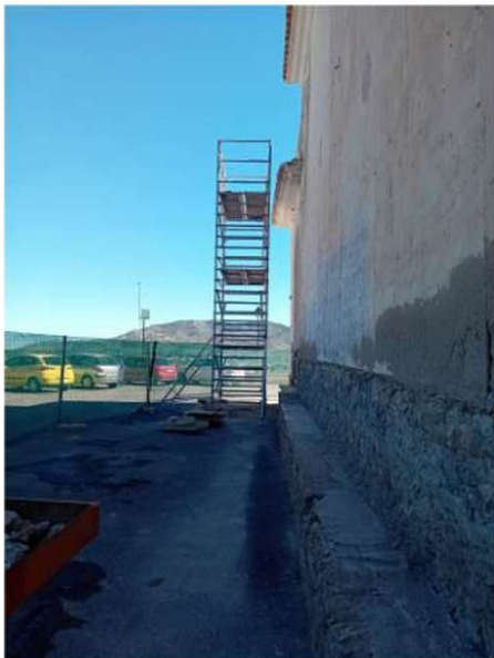
003. Eliminación del revestimiento deteriorado en la zona baja. Origen: rascado pinturas, p. 2, imagen 2.
