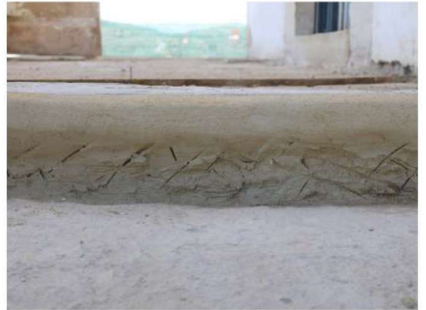
018. Reconstrucción del perfil de una moldura.
