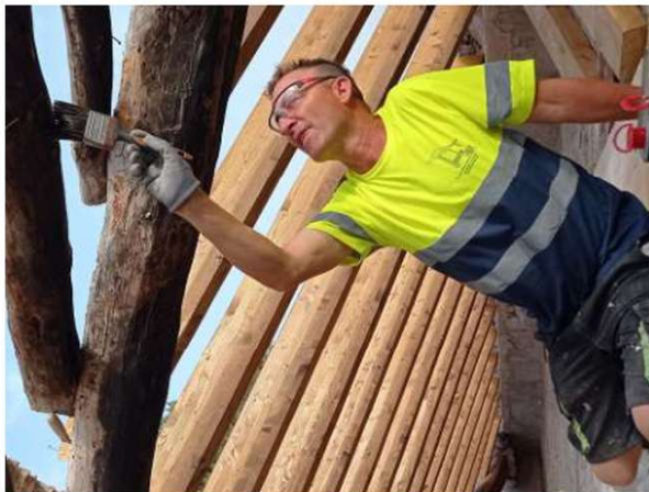
071. Trabajos en el encuentro de la nueva viguería y la existente.
