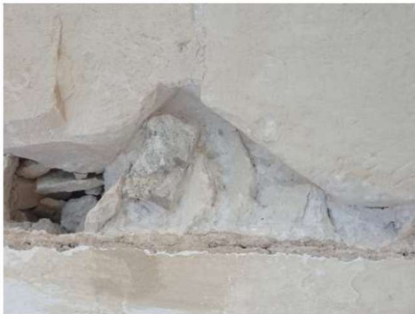
019. Detalle de moldura y soporte durante la reparación.
