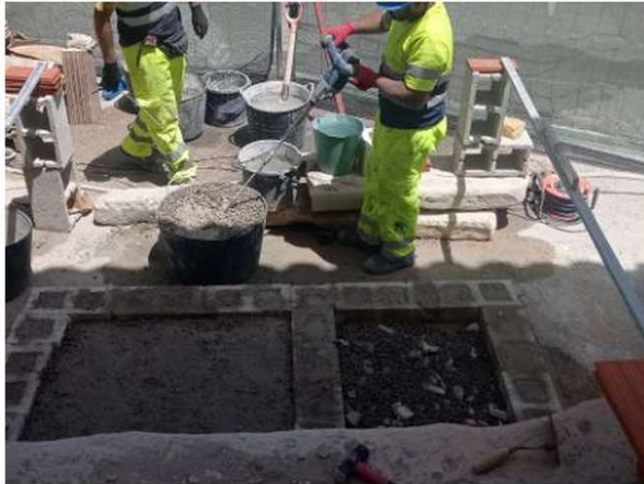
037. Preparación de materiales para la reparación de la piedra. Origen: escalinata, p. 9, imagen 5.
