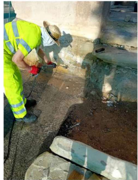
022. Intervención en el zócalo pétreo y su encuentro con el suelo. Origen: limp piedra, p. 1, imagen 2.
