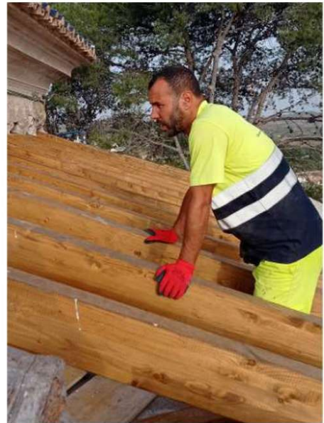
070. Ajuste y colocación de las nuevas piezas de madera.
