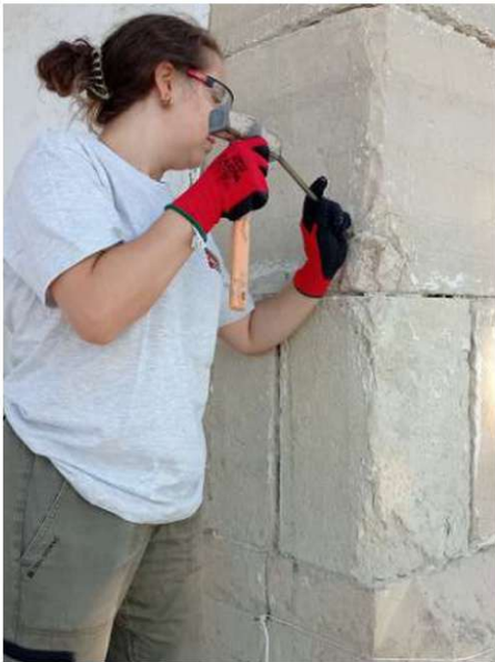
017. Intervención manual en el encuentro entre piezas de piedra.
