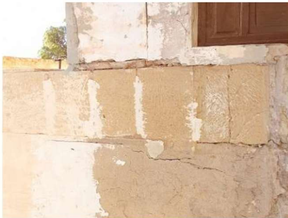
027. Estado de las juntas de piedra durante la reparación.
