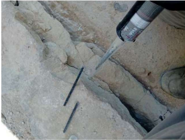
013. Perforación para la reparación localizada de una junta.
