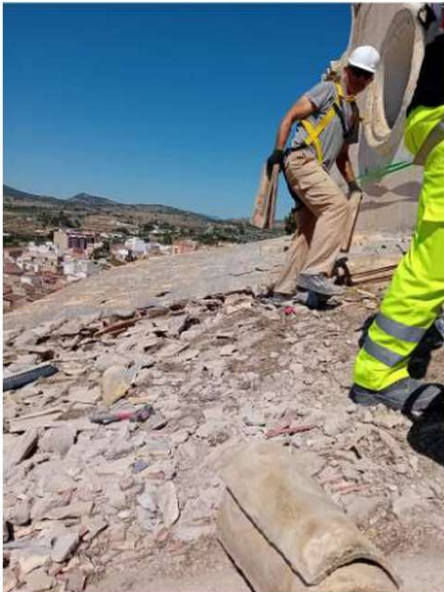
051. Levantado de la cobertura y saneado del soporte.
