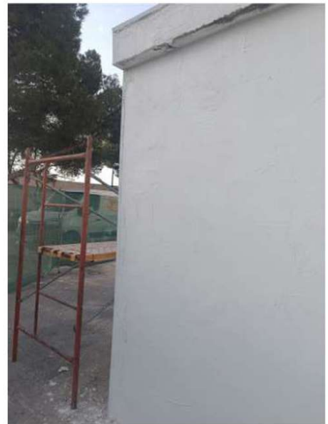
008. Acabado de los revestimientos y remates de fachada. Origen: rascado pinturas, p. 8, imagen 5.
