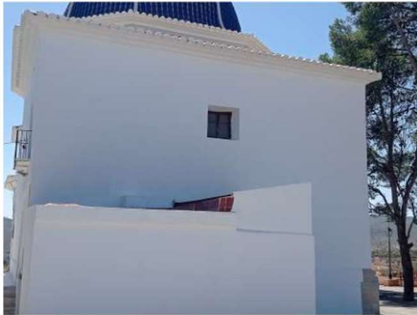
089. Acabado de los paramentos exteriores del volumen posterior. Origen: finales, p. 1, imagen 8.
