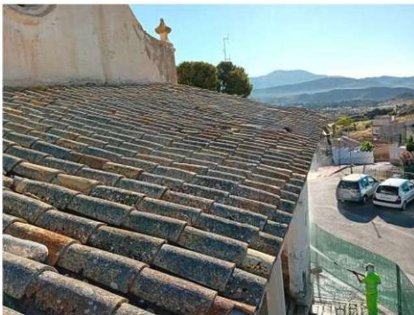
Fotografía 49. Vista del faldón con la cobertura de teja colocada.
