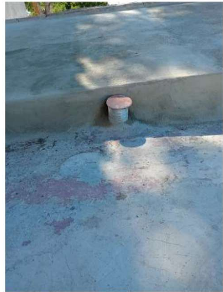
082. Detalle del sumidero y de la formación del soporte. Origen: cub ermitaño, p. 5, imagen 4.
