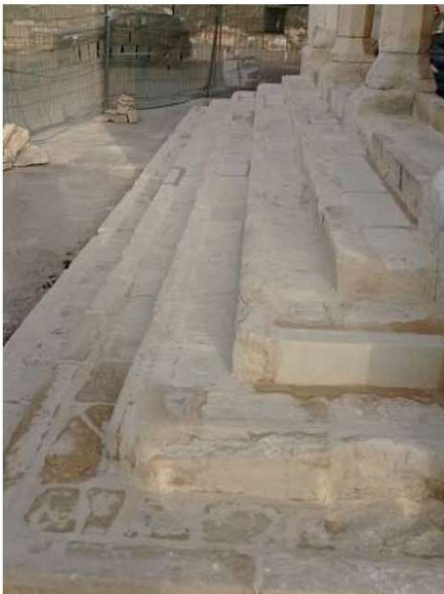
039. Vista de los peldaños y del rejuntado durante la intervención. Origen: escalinata, p. 12, imagen 5.
