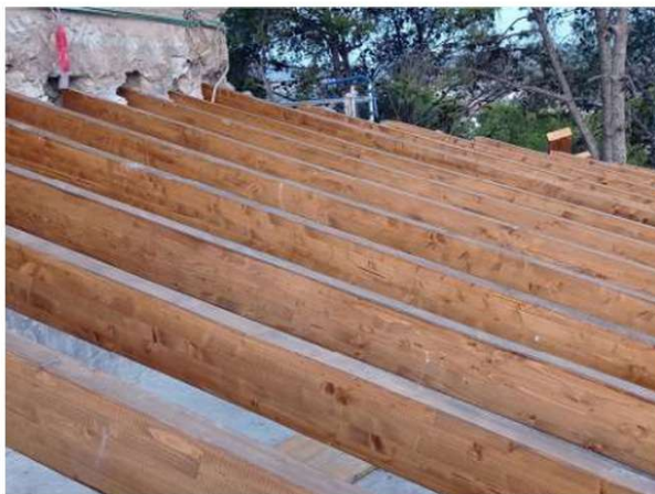
067. Disposición de las nuevas viguetas de madera.
