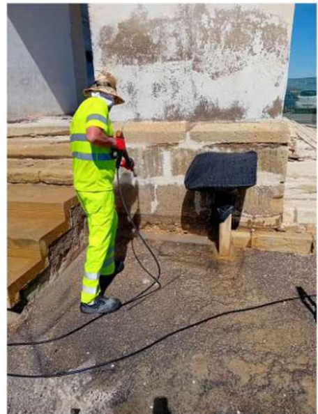
028. Limpieza de la piedra en la zona de la escalinata.
