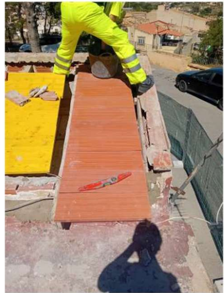
078. Colocación de piezas cerámicas para formar el tablero.
