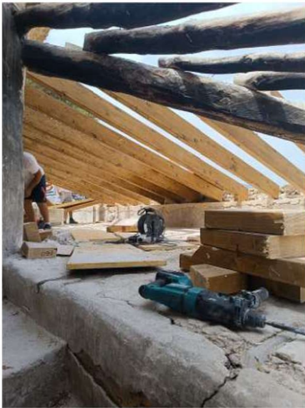
069. Vista interior de la viguería colocada.
