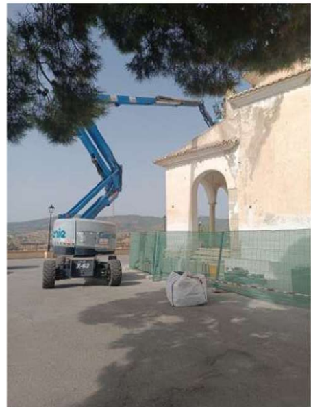
012. Trabajos en altura y estado intermedio de los paramentos. Origen: rascado pinturas, p. 14, imagen 2.
