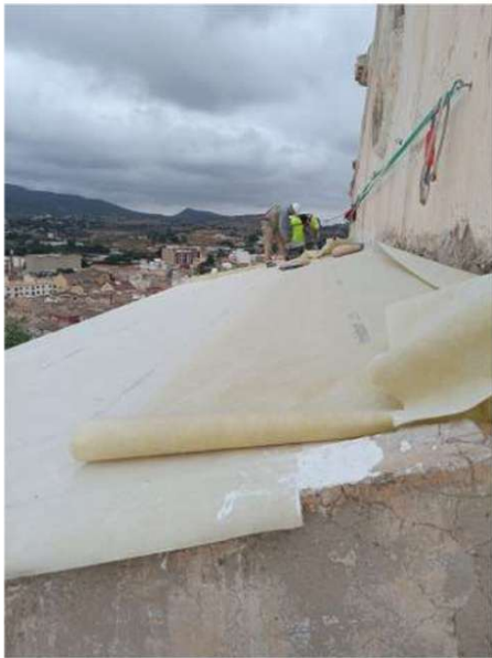
053. Preparación de materiales para la intervención en cubierta. Origen: teja porche, p. 7, imagen 3.
