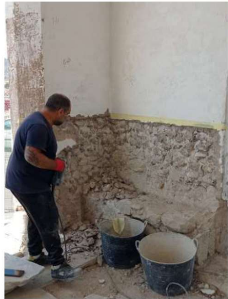
010. Reparación del revestimiento sobre la fábrica descubierta. Origen: rascado pinturas, p. 10, imagen 6.
