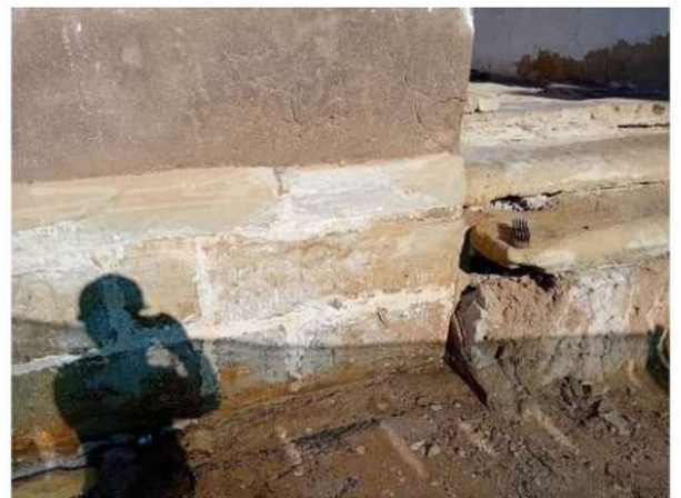
024. Detalle de basamento durante la intervención. Origen: limp piedra, p. 1, imagen 6.
