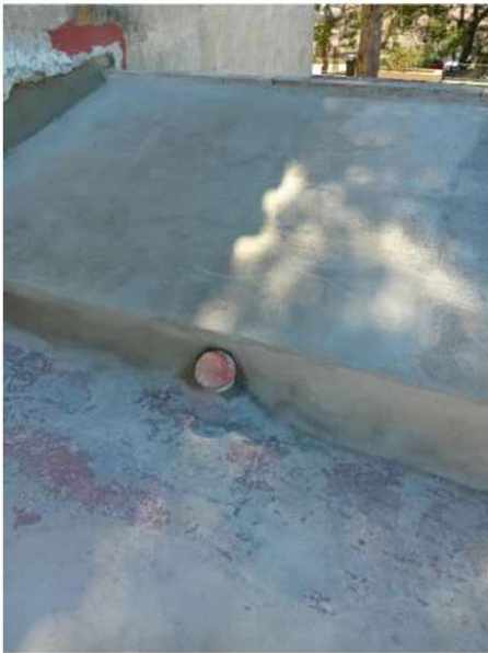
081. Preparación del soporte y encuentro con el desagüe. Origen: cub ermitaño, p. 4, imagen 5.
