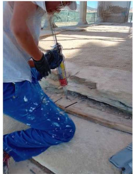
014. Aplicación de material de reparación en una junta abierta.
