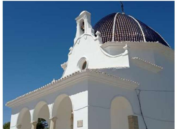
Fotografía 95. Vista oblicua de la fachada y de sus remates.
