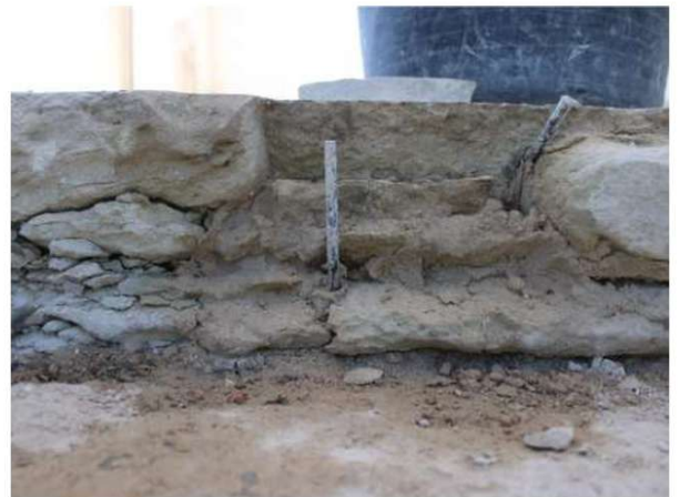
016. Detalle de la fábrica descubierta durante la reparación.
