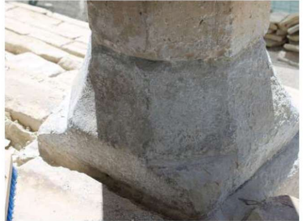
034. Detalle del basamento tras su limpieza.
