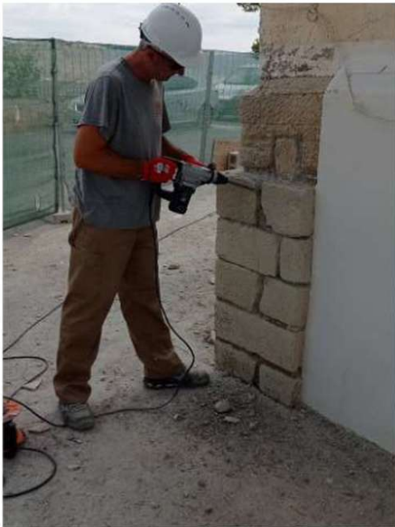
025. Trabajos de limpieza y preparación de la sillería.
