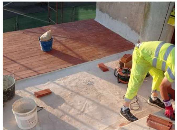
084. Colocación del pavimento cerámico de protección. Origen: cub ermitaño, p. 8, imagen 7.
