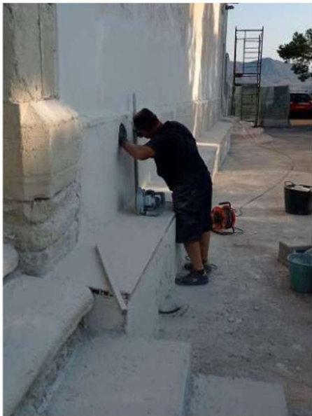
011. Aplicación y regularización del revestimiento en fachada. Origen: rascado pinturas, p. 12, imagen 3.
