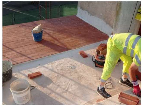
Fotografía 84. Colocación del pavimento cerámico de protección.
