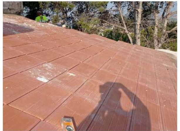
072. Tablero cerámico colocado sobre las viguetas.
