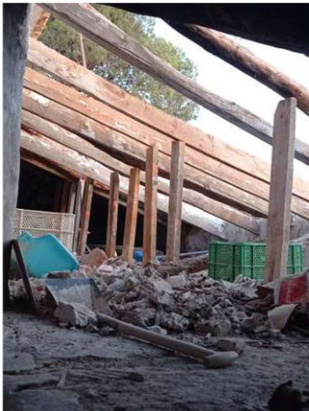
059. Estructura de madera descubierta durante el desmontaje.
