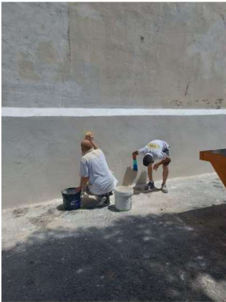
005. Preparación y reparación de los revestimientos del zócalo. Origen: rascado pinturas, p. 5, imagen 5.
