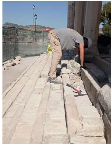
036. Trabajos de reparación y ajuste de piezas de los peldaños.
