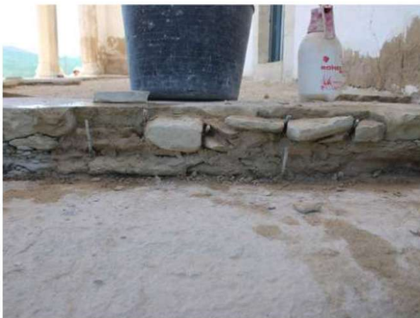
015. Saneado de la fábrica y del revestimiento de una bancada.
