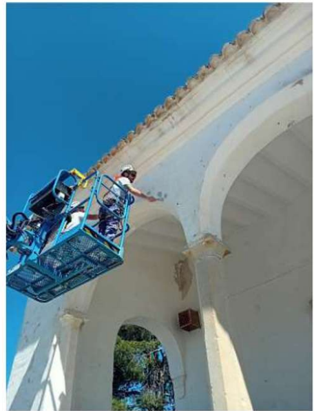
002. Trabajos de preparación de los paramentos del porche. Origen: rascado pinturas, p. 1, imagen 6.
