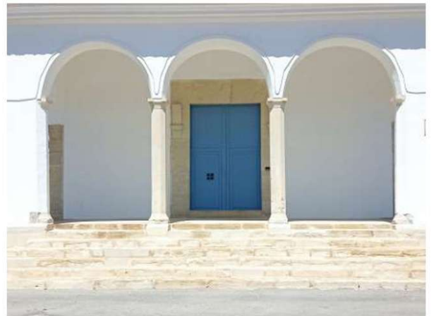
096. Estado final del porche y la escalinata principal. Origen: finales, p. 2, imagen 6.
