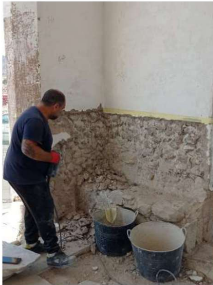
Fotografía 10. Reparación del revestimiento sobre la fábrica descubierta.
