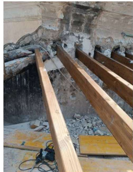
068. Detalle de los apoyos de las nuevas viguetas.
