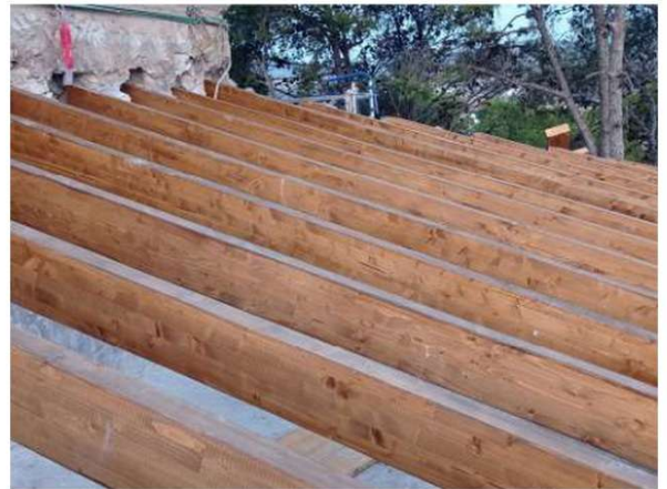
Fotografía 67. Disposición de las nuevas viguetas de madera.
