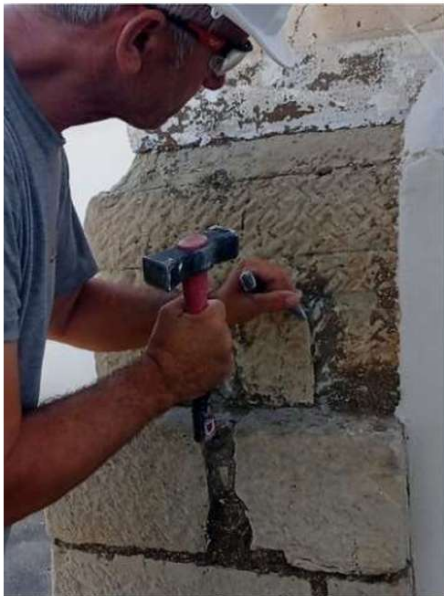
021. Limpieza y preparación de las juntas de la piedra. Origen: limp piedra, p. 1, imagen 1.
