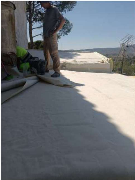
083. Trabajos previos al acabado de la cubierta anexa. Origen: cub ermitaño, p. 7, imagen 7.
