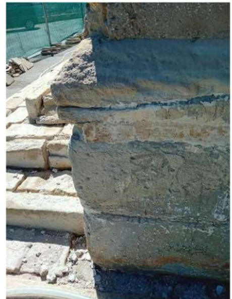
032. Basamento pétreo en fase de saneado. Origen: escalinata, p. 3, imagen 1.
