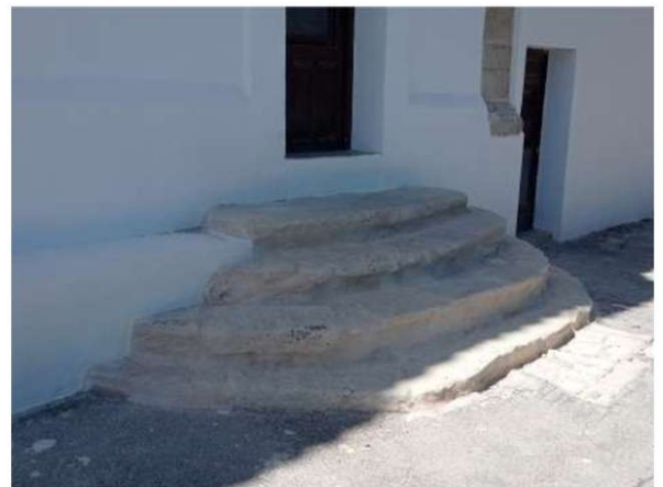
Fotografía 88. Estado final de la escalera de acceso a la casa del ermitaño.
