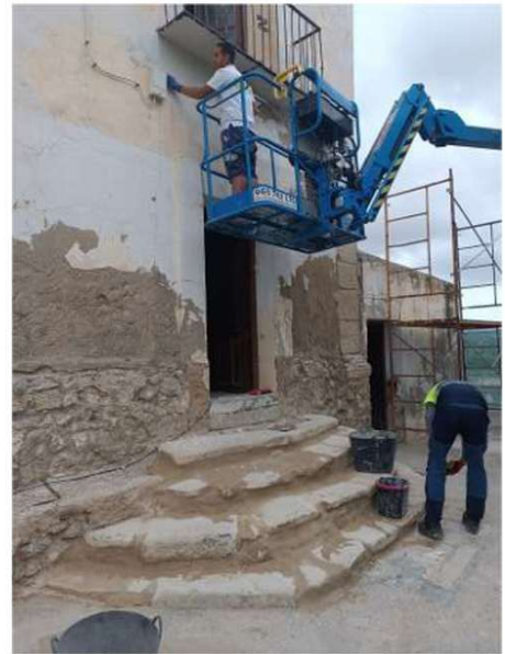
006. Saneado de fachada junto al acceso de la casa del ermitaño. Origen: rascado pinturas, p. 6, imagen 8.
