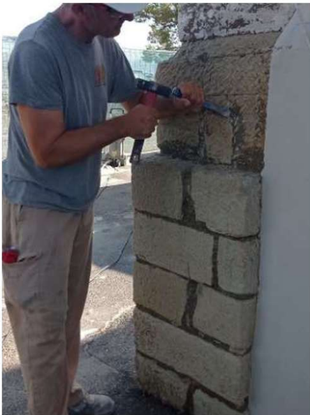
023. Limpieza de la superficie y juntas de un pilar de piedra. Origen: limp piedra, p. 1, imagen 4.
