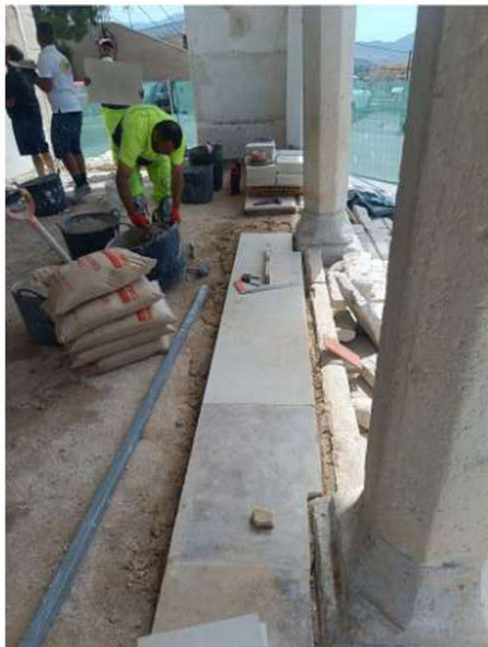
043. Colocación de piezas de pavimento en el soportal.
