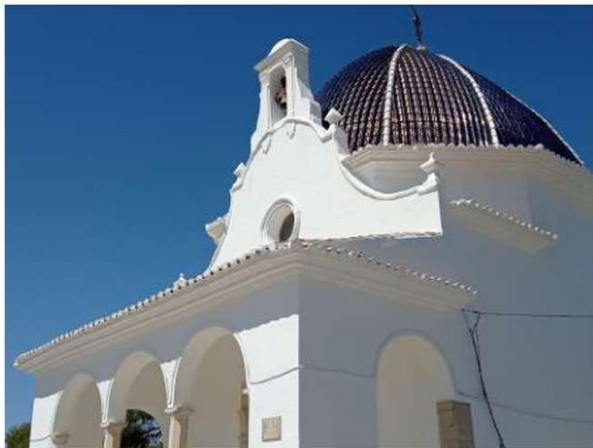
095. Vista oblicua de la fachada y de sus remates. Origen: finales, p. 2, imagen 5.
