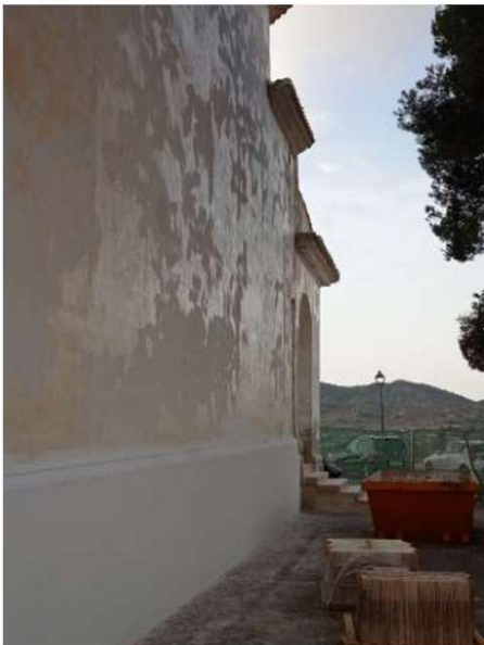
007. Paramentos en distintas fases de preparación del soporte. Origen: rascado pinturas, p. 7, imagen 6.
