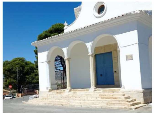
092. Fachada principal y escalinata tras la intervención. Origen: finales, p. 2, imagen 2.
