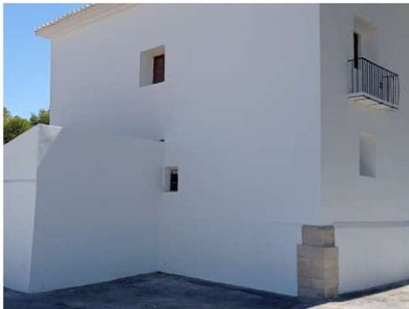
087. Vista final del volumen de la casa del ermitaño y anexo. Origen: finales, p. 1, imagen 5.
