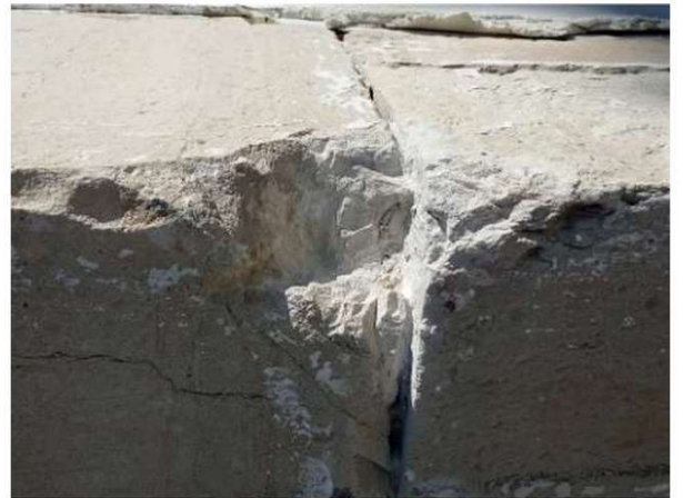
020. Pérdida de material en una pieza pétrea antes de reponerla.
