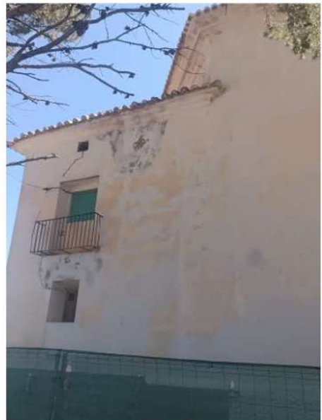
004. Fachada con revestimientos abiertos durante la intervención. Origen: rascado pinturas, p. 3, imagen 5.
