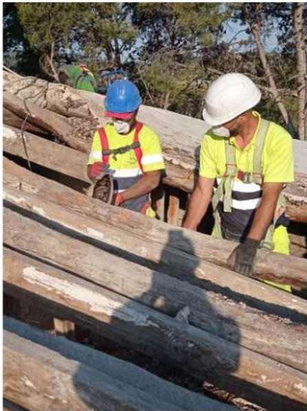
065. Retirada de piezas de madera en mal estado.
