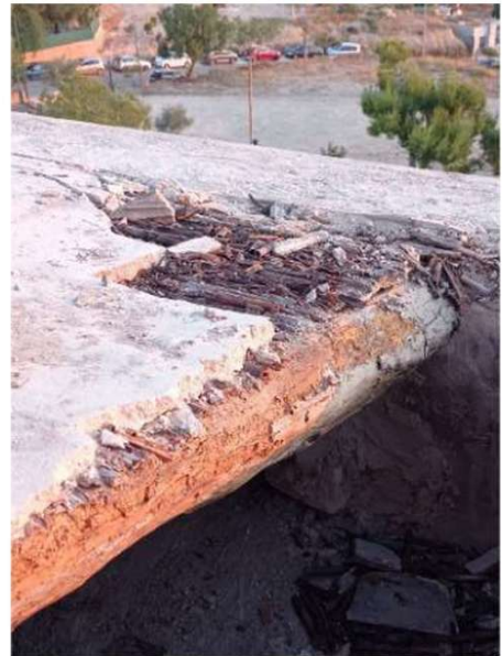
062. Pérdida de material en el extremo de una pieza de madera. Origen: cub sacristía, p. 3, imagen 2.
