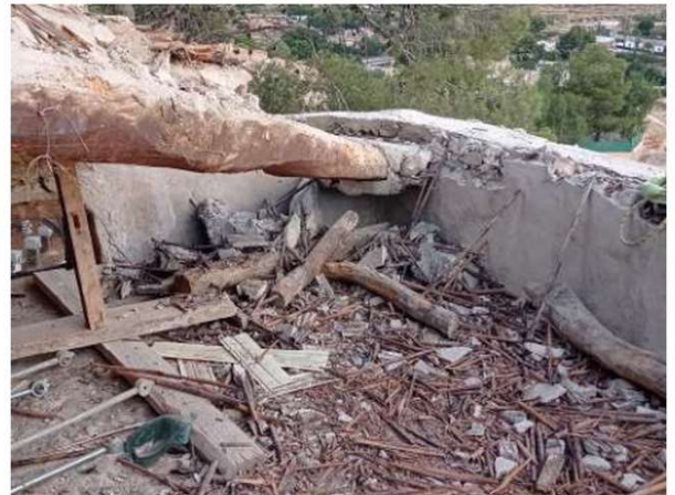
066. Interior tras el levantado del tablero de cubierta.
