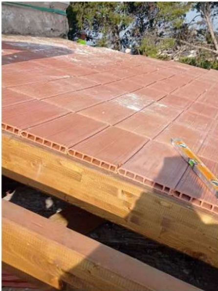
073. Detalle del tablero cerámico y de la vigería de apoyo. Origen: cub sacristía, p. 8, imagen 8.
